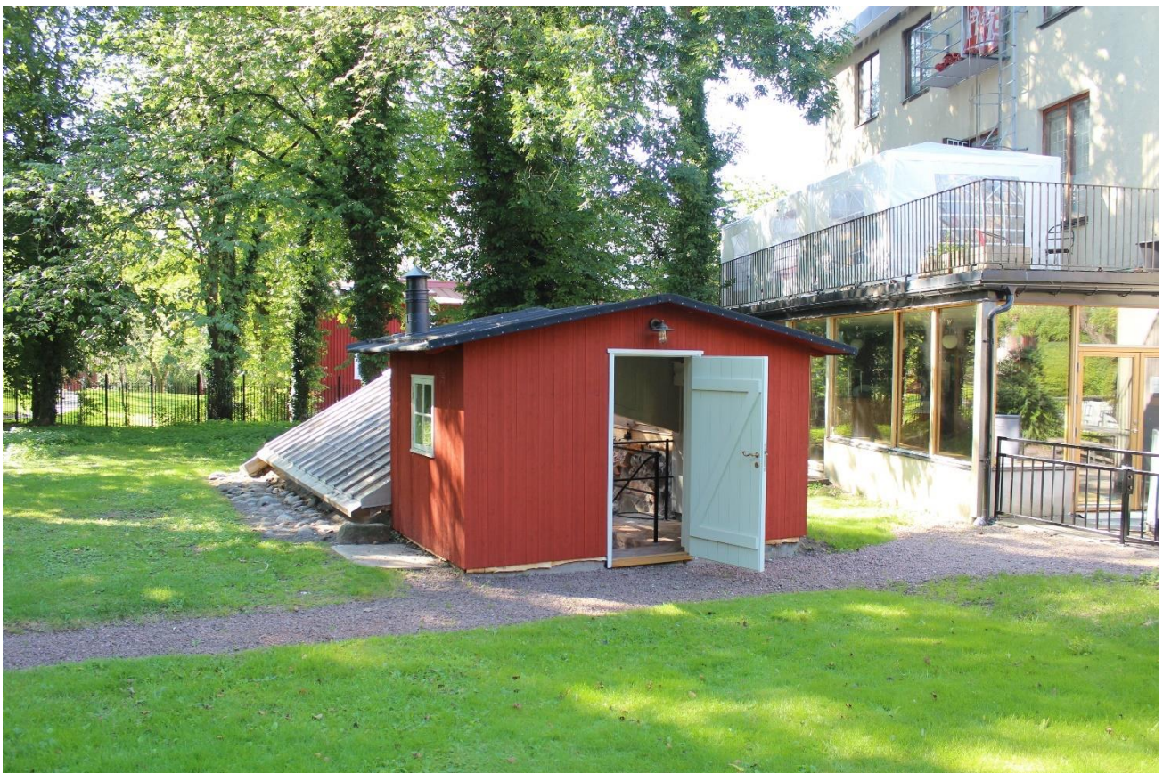
NYLIGEN RENOVERAT VÄXTHUS. SANMLIKT UPPFÖRT MELLAN 1900 OCH 1920.
