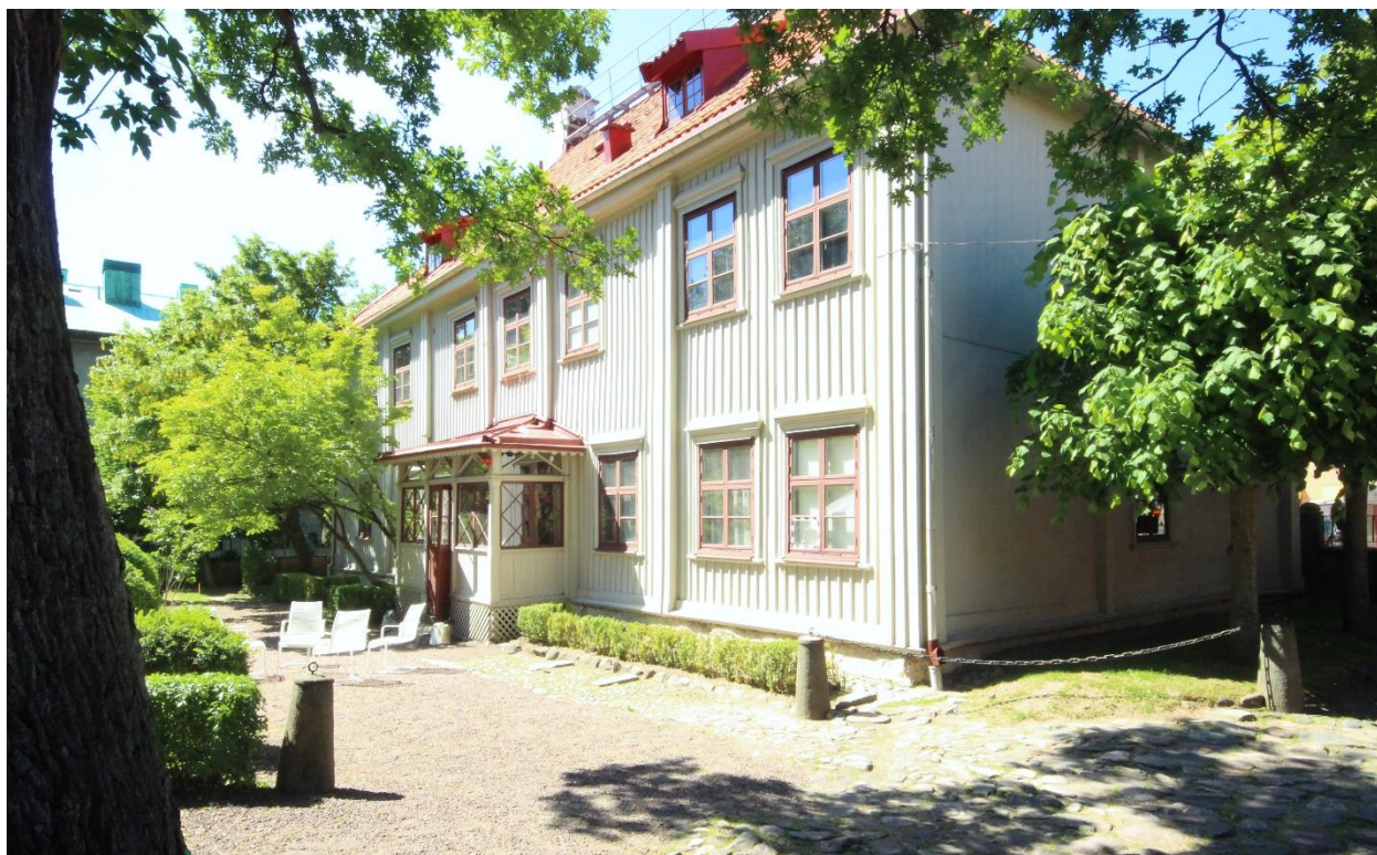
FASADEN MOT TRÄDGÅRDEN I SÖDER HAR EN UTBYTT LOCKLISTPANEL SAMT UTBYTTA FÖNSTER. DEN GLASADE VERANDAN TILLKOM 1874. FÖNSTREN MOT SÖDER ÄR FRÅN 1970-TALET MED INDELNING LIKA DE URSPRUNGLIGA.
