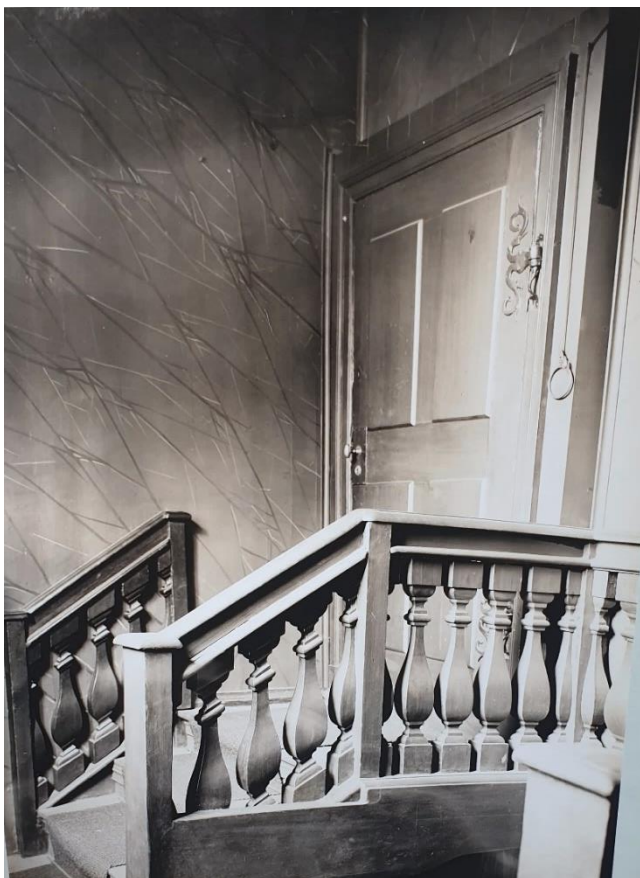
FOTOGRAFI AV ÖVERSTA TRAPPAVSATSEN. 1916 MONTERADES MELLANVÄGGAR SOM AVSKILDE TRAPPAN FRÅN DEN ÖVRE TRAPPHALLEN. FOTOGRAFIET VISAR ATT ÄLDRE DÖRRAR MONTERADES I DE NYA VÄGGARNA. KÄLLA: GSM
