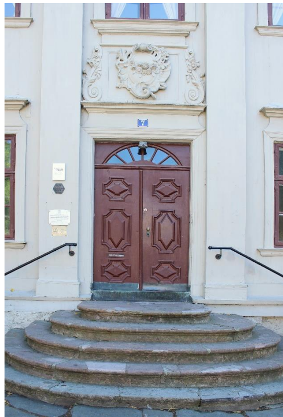
URSPRUNGLIG PÅRDÖRR MED ÖVERLJUS SAMT OVAN DET EN SNIDAD VAPENSKÖLD.
