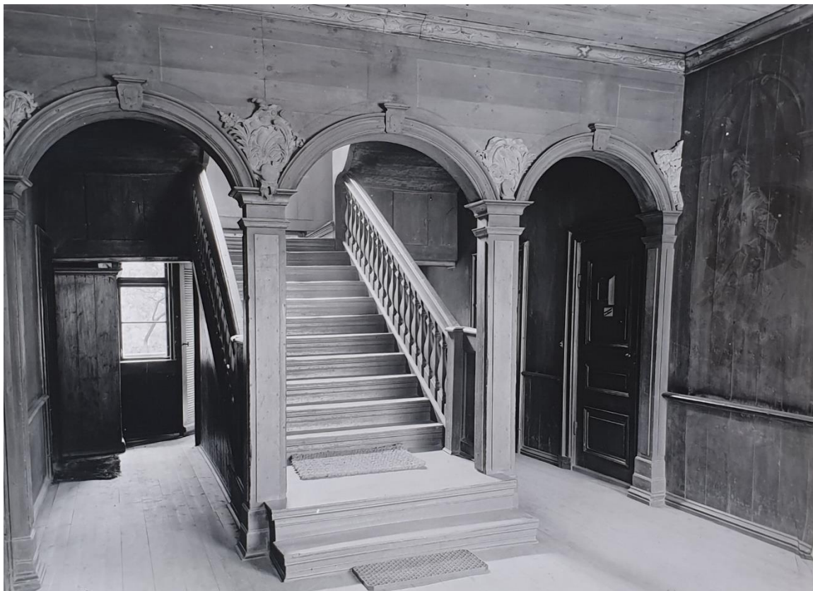
FOTO AV ENTRÉHALLEN UÅ TAGET AV AXEL HARTMAN (1850-1931) MÖJLIGEN INNAN RESTUARERINGEN AV MÅLERIET GENOMFÖRDES PÅ 1910-TALET. KORRIDOREN VID SIDAN AV TRAPPAN ÄR ÖPPEN MOT BAKRE HALLEN.
