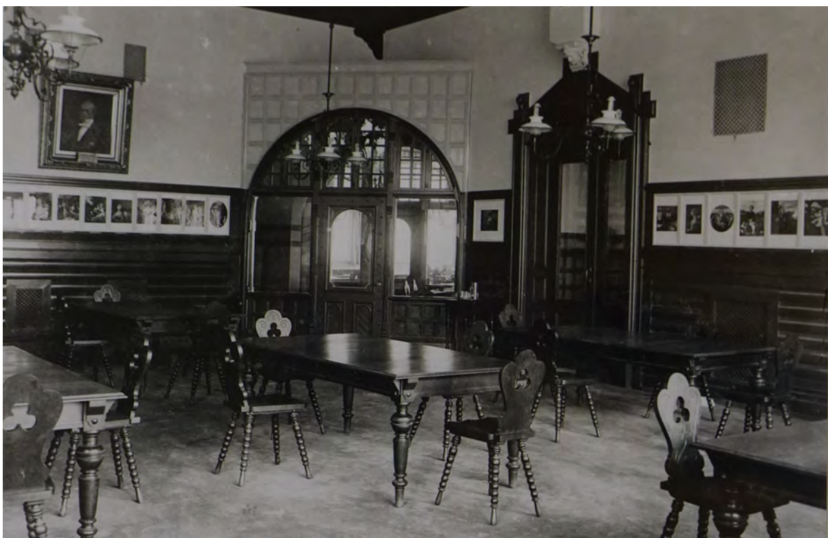
Läsruminteriör 1906 (nuvarande rum 205). Notera att den målade bröstningen har ersatts av en liggande träpanel som troligtvis var målad i en mörkt brun kulör. (GSM, fotograf okänd)
