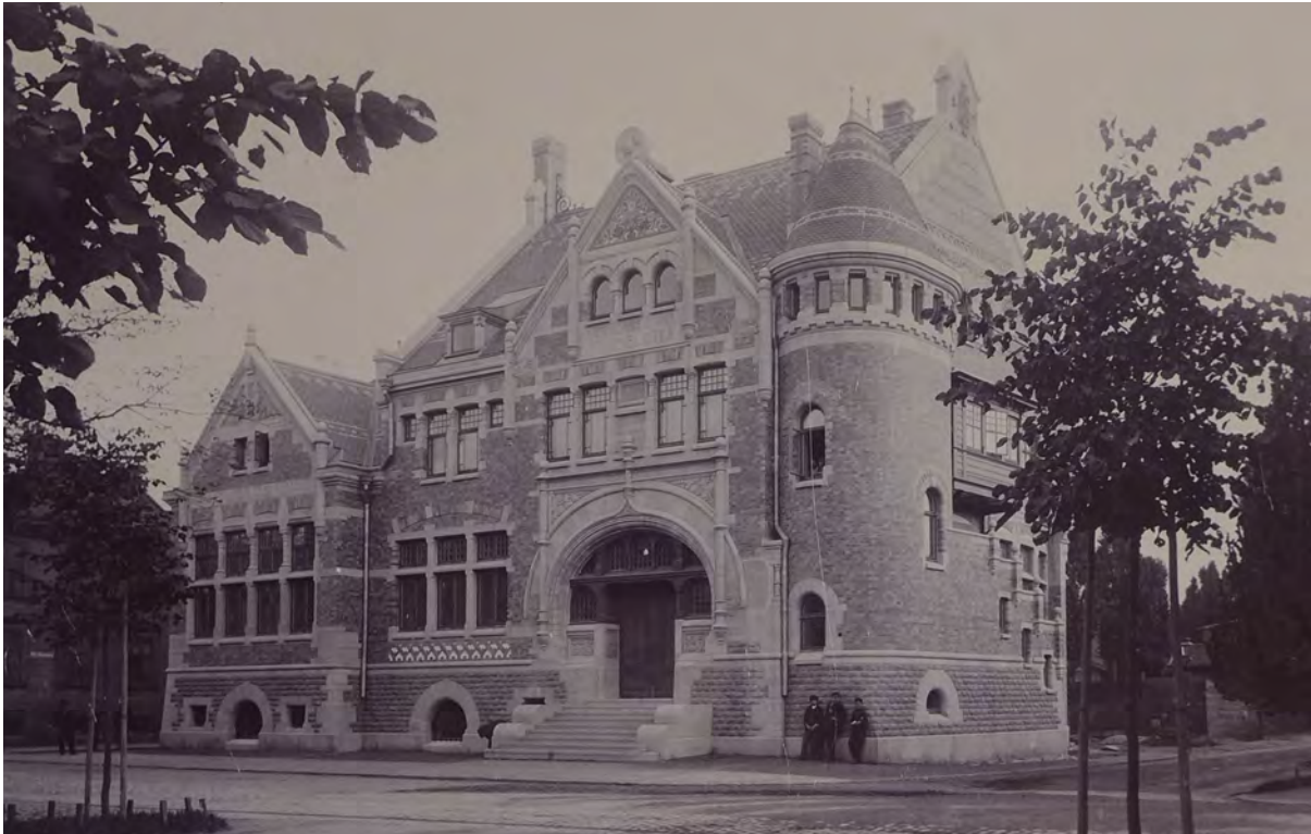
Foto från tidigt 1900-tal, huvudfasad mot Södra Allégatan. Notera Al Frescomålningen i gavelspetsen samt den vackert utformade takkupan (inzoomade detaljer). Här syns också hur skiffertaket ursprungligen hade en mönsterläggning. Notera också särskilt gavelrösternas profilerade kalkstensavslut, vilka idag är plåtinklädda. (GSM, fotograf Hjalmar Blink)
