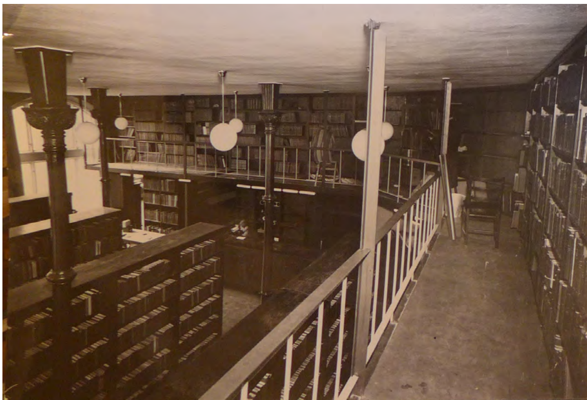
Foto från fd tidningssalen på bottenvåningen kring 1935. Rummet iordningställdes som bokmagasin och försågs med öppna bokhyllor samt en ny läktare med hyllor. Notera de nedpendlade globarmaturerna. (Regionarkivet)
