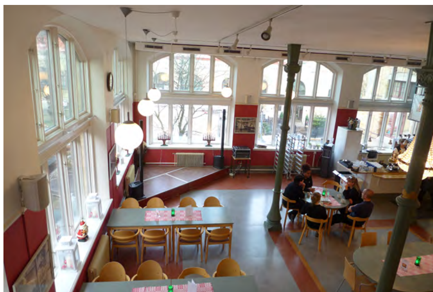
Rum 213, fd tidningssalen (nuv. Café) har en bevarad planlösning och ursprungliga gjutjärnsspelare. I övrigt är rummet kraftigt förändrat och präglas av moderna material och kulörer vilket förklarar den äldre karaktären.
