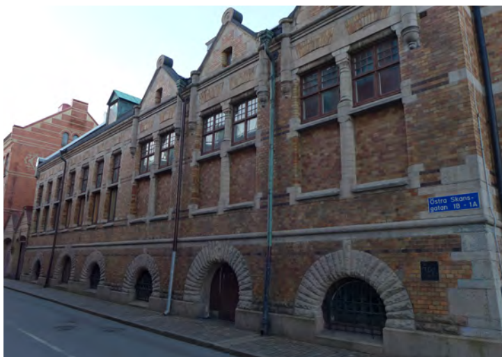
Fasad mot Östra Skansgatan. Den nedre delen av fönstren in mot läsesalen är igenmurade.
