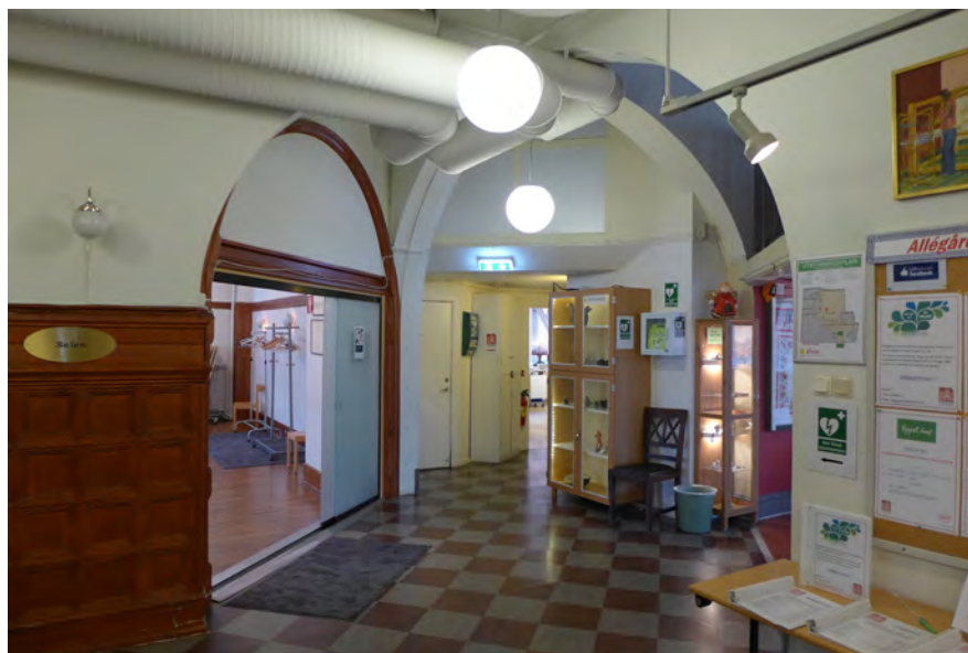
Rum 204, fd utlåningsrummet, med sitt öppna kryssvalv där utlåningsdisken tidigare var belägen. Rummet är kraftigt förändrat och präglas av moderna material och mycket synliga installationer som förklarar rummets äldre karaktär.
