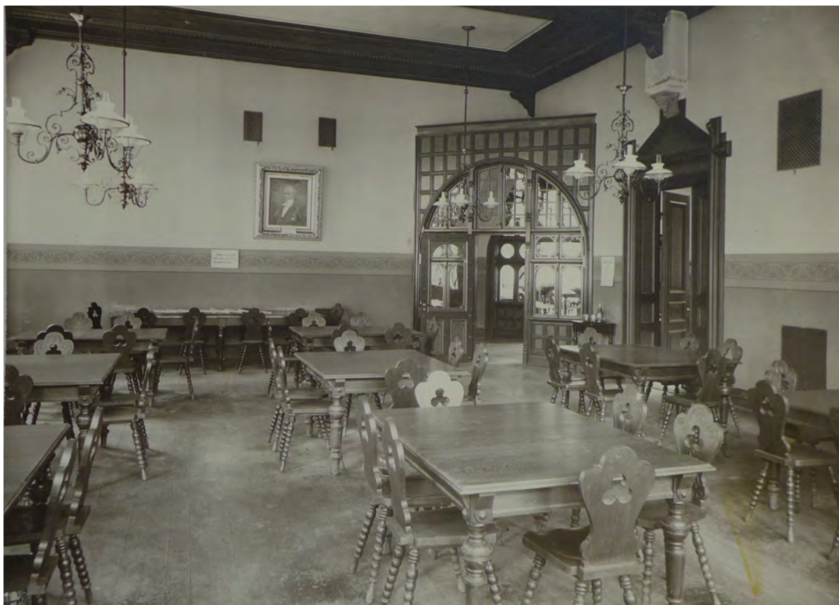
Läsruminteriör 1901 (nuvarande rum 205). Väggarna var målade med en hög bröstning som avslutades av en jugendinspirerad bård. Här syns även det ursprungliga och välvda dörrpartiet mot utlåningsrummet vilket ska återskapas år 2017. Till höger i bild syns den parspegeldörr som finns kvar än idag. De takhängda armaturerna finns dock inte längre kvar. (GSM, fotograf A Jonason)
