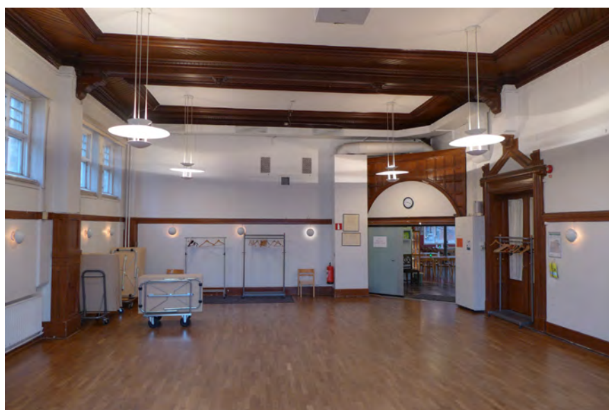
Rum 205, fd läsesalen, har bevarat sin planlösning men i övrigt genomgått stora förändringar som delvis förvanskade rummet. Den äldre bröstpanelen är endast delvis bevarad och fönster mot Östra Skansgatan är igenmurade. Bevarade äldre detaljer är bl a parspegeldörrblad med dekorativ omfattning mot vestibulen, sockel och dekorativa takbjälkar.
