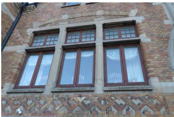
Fönsterparti in mot fd läsesal för kvinnor med ursprungliga karmar och bågar.
