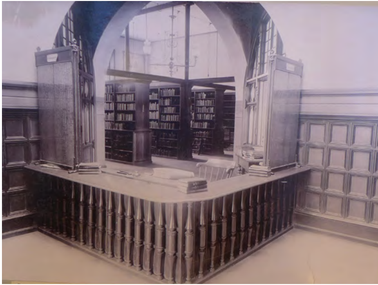
Foto från 1905 som visar utlåningsrummet innanför vestibulen (nuvarande rum 204). I det öppna kryssvalvet mellan utlåningsrum, läsesal, boksamling och tidningsrum fanns utlåningsdisken med svarvade balusterdockor. Golvet var belagt med kalksten och väggarna klädda med en hög bröstpanel. I bakgrunden skymtas bokmagasinet med sina bokhyllor. (Regionarkivet)
