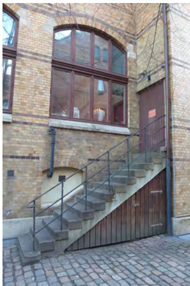
Gårdsentré med ursprunglig trappa. Själva entrén är igensatt och försedd med ett modernt dörrblad.
