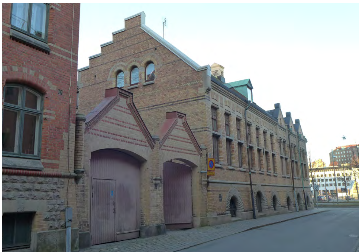
Fasad mot Östra Skansgatan med anslutande murparti. De moderna portarna i muren förtar den äldre karaktären. Notera även takkupa från 1940-50-talet i det östra takfallet.
