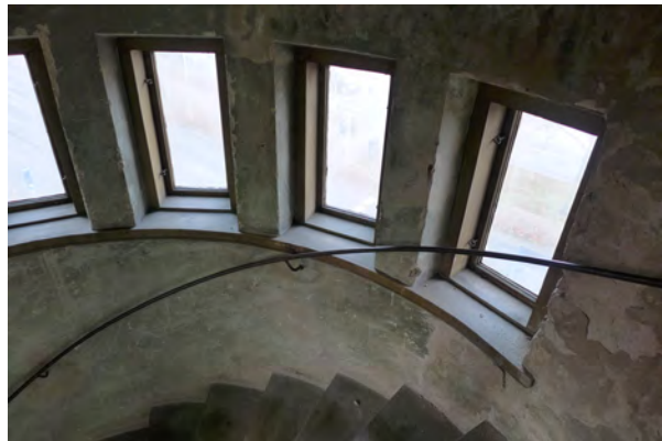
Torntrapphuset med ursprunglig trappa, handledare och fönster.
