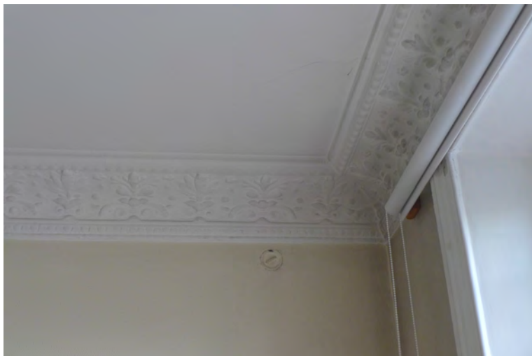
Ursprunglig stuckfris i rum 405 som vid uppförandet fungerade som lägenhet för föreståndarinnan.
