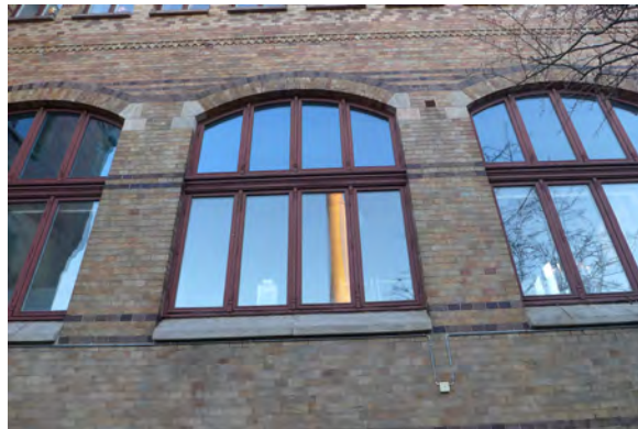
Välvda fönsterpartier in mot fd tidningssalen (nuv. Café). Merparten av karmarna är ursprungliga men fönsterbågarna är moderna.
