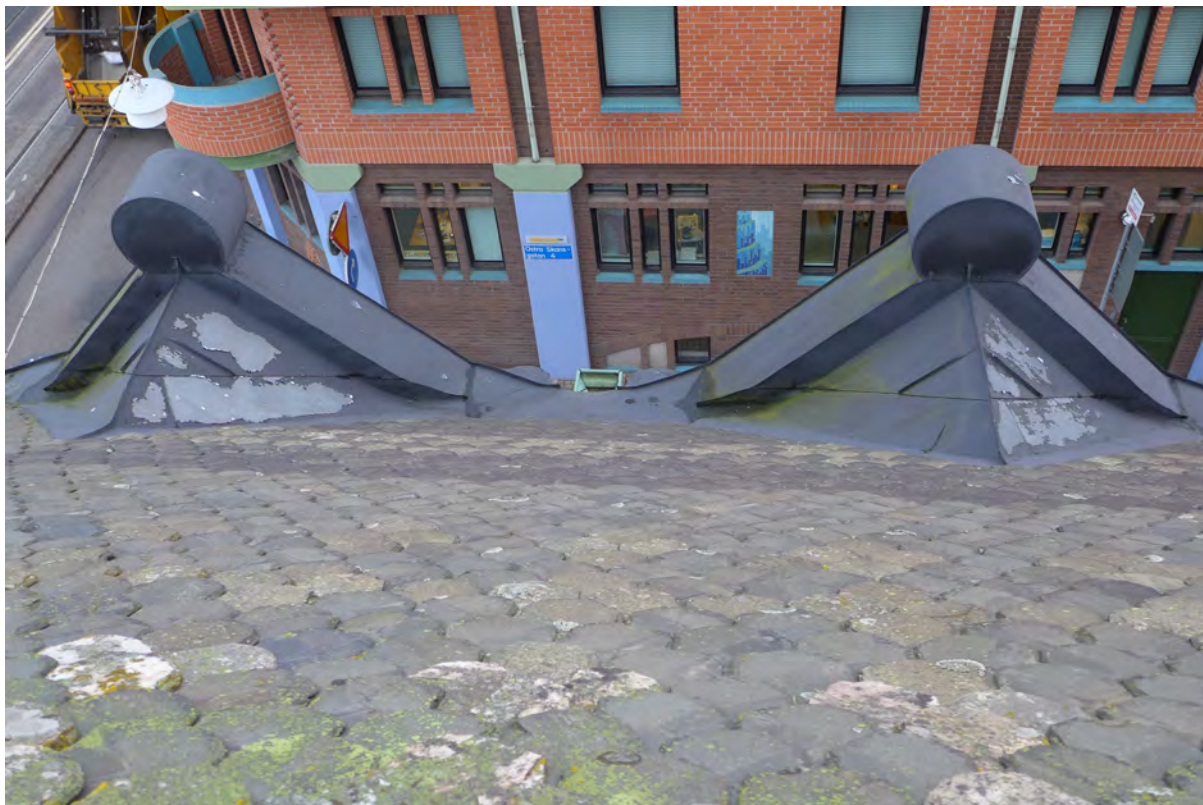
Östra takfallet med sin skiffertäckning, idag med algpåväxt. Notera plåtinklädda gavelrösten.
