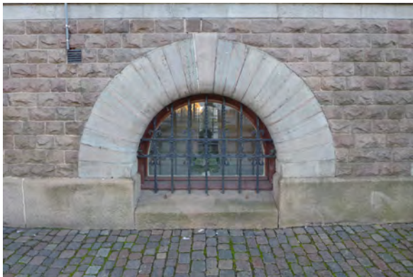
Välvt källarfönster med kalkstensomfattning och dekorativt smidesgaller.
