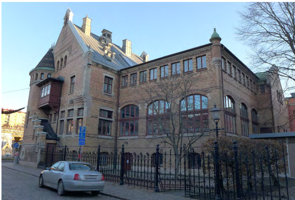
Fasad mot Kaponjergatan med trapphustorn och dekorativt burspråk av trä i den främre byggnadskroppen. Den bakre byggnadskroppen mot gården byggdes på med en våning på 1930-talet.
