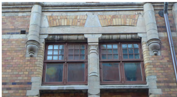
Fasaderna är försedda med riklig kalkstensdekor, bl a i anslutning till fönster. Bilden visar även två ursprungliga 4-lufts-fönster med profilerade mittposter och småspröjsade övre luft.
