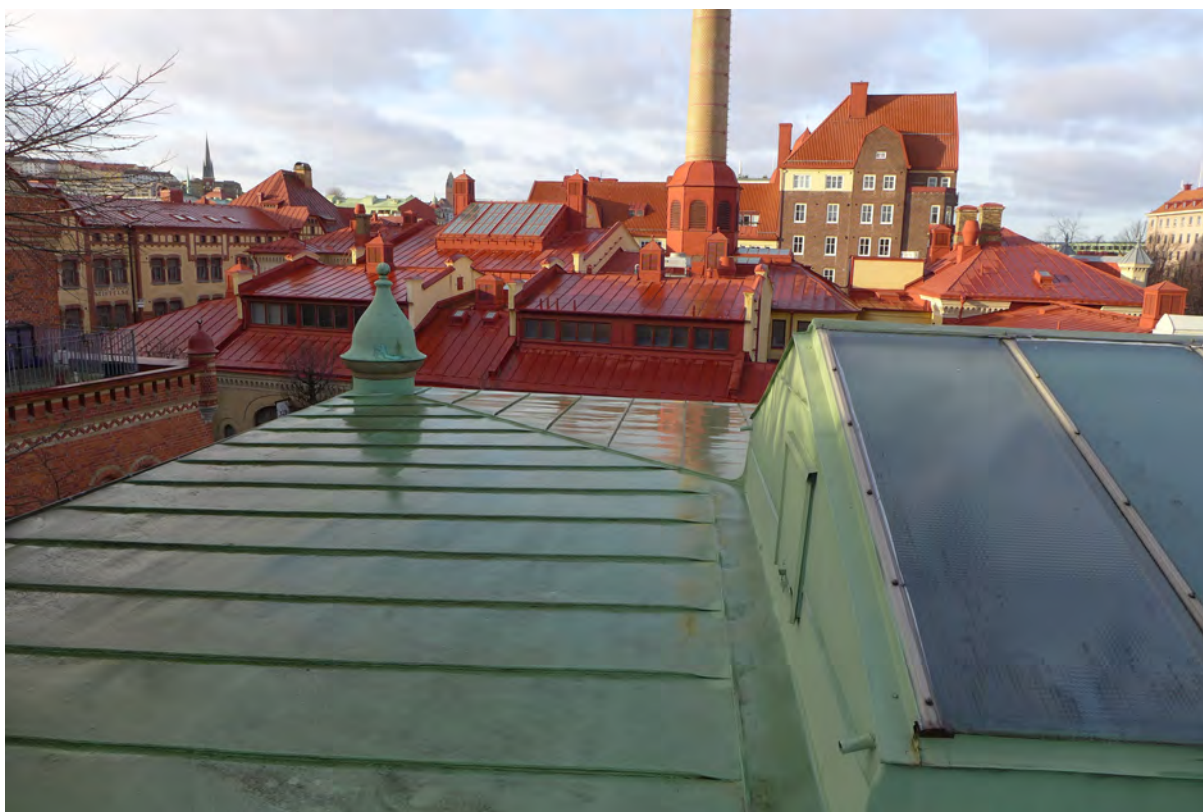
Lågdels takfall mot gården med bandtäckt plåt i ärggrön kulör. Notera lanternin med trådglas.
