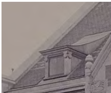
Foto från tidigt 1900-tal, huvudfasad mot Södra Allégatan. Notera Al Frescomålningen i gavelspetsen samt den vackert utformade takkupan (inzoomade detaljer). Här syns också hur skiffertaket ursprungligen hade en mönsterläggning. Notera också särskilt gavelrösternas profilerade kalkstensavslut, vilka idag är plåtinklädda. (GSM, fotograf Hjalmar Blink)
