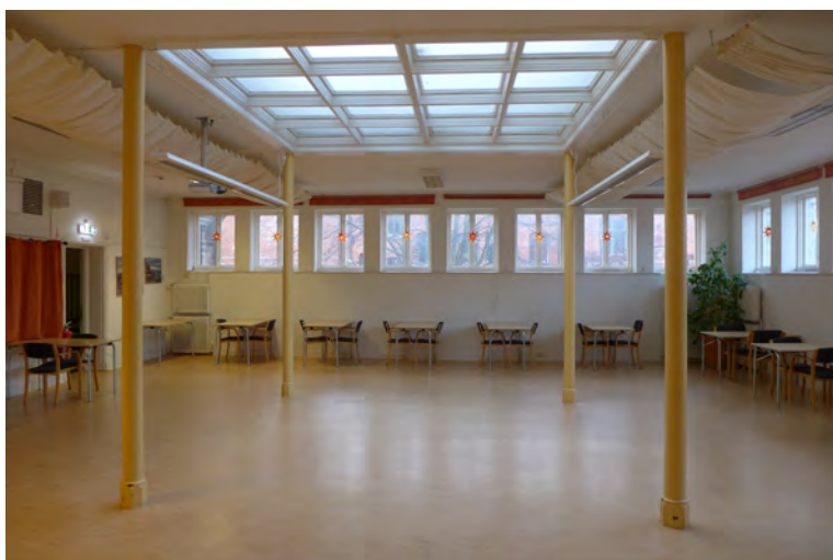
Rum 408 utgör en påbyggnad ovan tidningssalen från 1930-talet och fungerade som läsesal för barn. Rummet har bevarat sin planlösning men präglas till stora delar av moderna material. Bevarat från 1930-talet är stålpelarna, golvsockel, fönster, lanternin, ett antal spegeldörrblad samt en mindre trätrappa.
