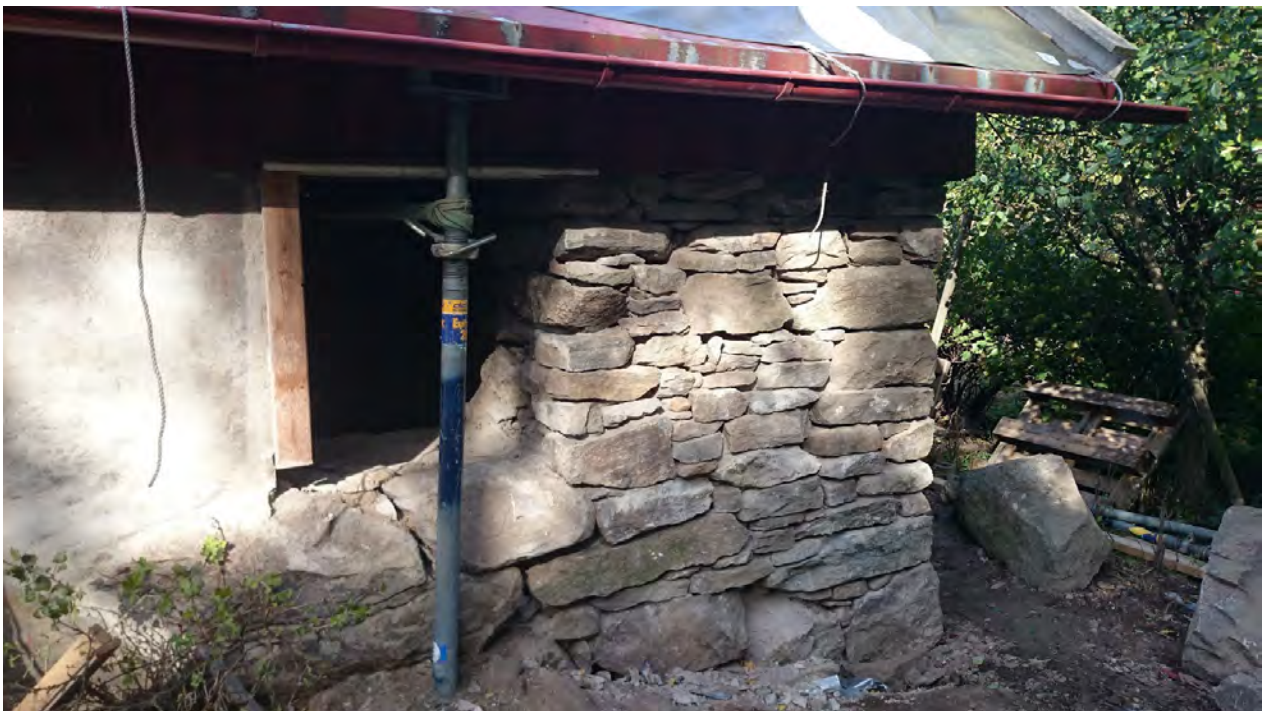
Renovering av naturstensmurar i hönshuset 2014. Foto: FC Mureri
