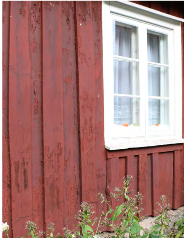
Östfasaden har en lockpanel med en mängd olika dimensioner och utföranden på såväl panel- som lockbrädor.
