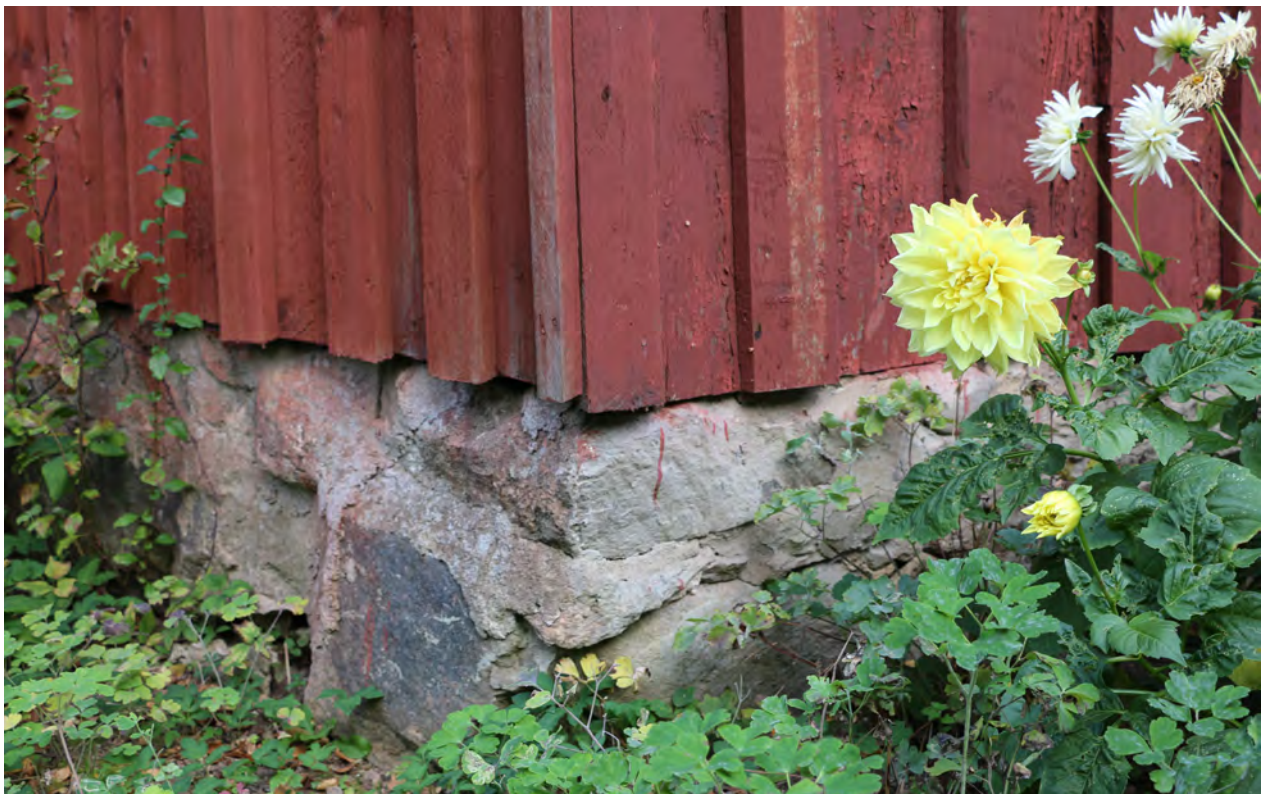
Grundmuren av gråsten, manbyggnadens hörn mot sydost
