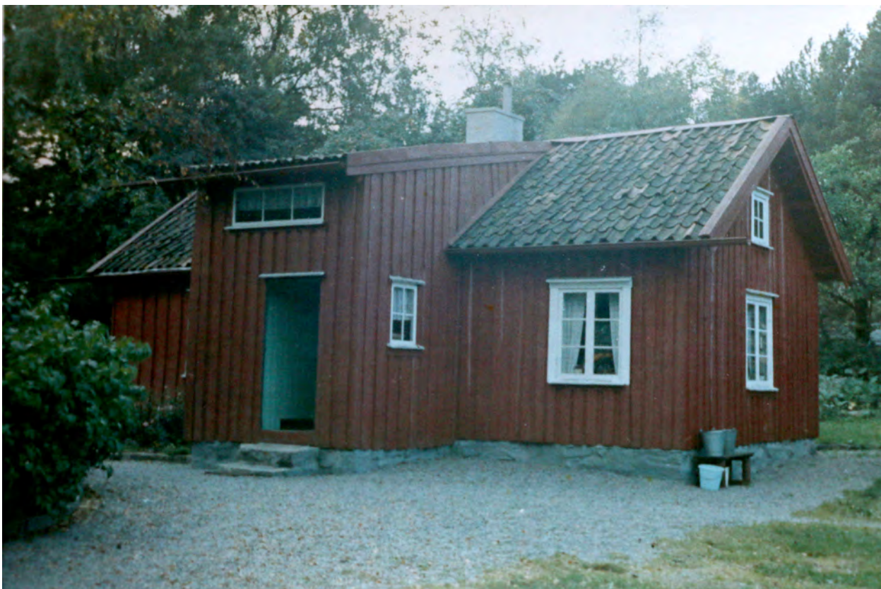
Manbyggnaden sedd från öster, troligen tidigt 1960-tal. Vindskivor är målade med rödfärg likt fasaden, sockeln är putsad och avfärgad i en grå kulör.
