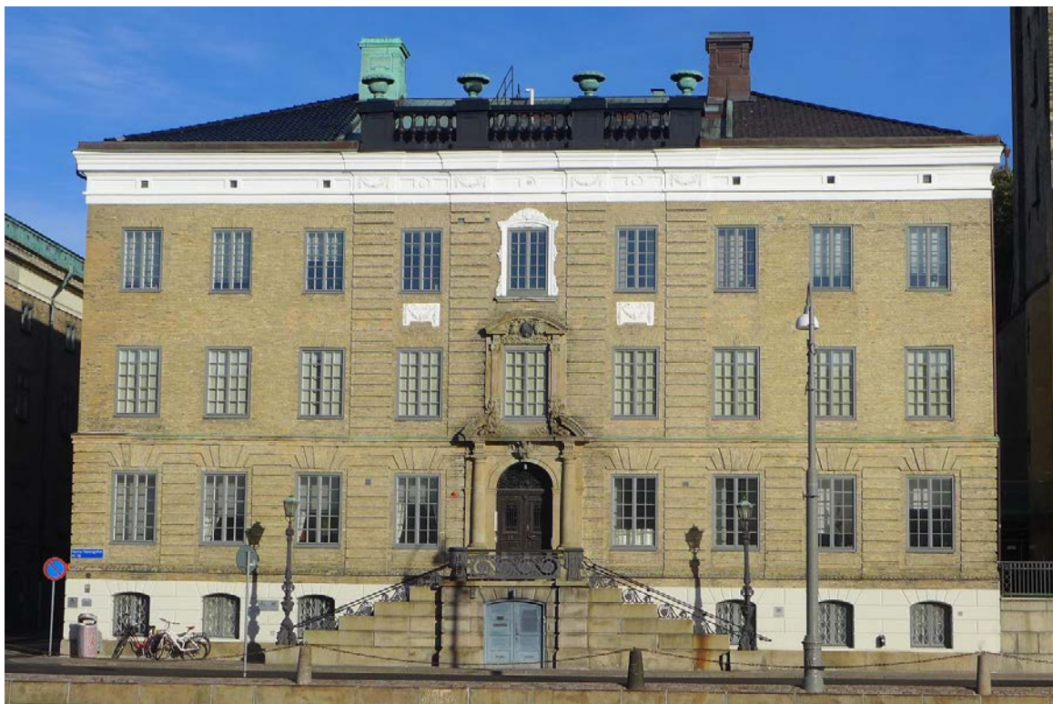
Huvudfasad mot Norra Hamngatan.
