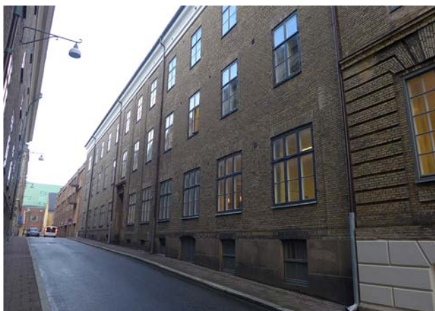
Fasad mot Tyggårdsgatan.
