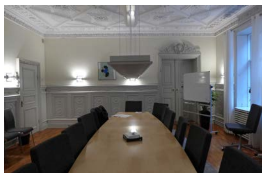
Rum 318 med bröstpanel och kraftigt stucktak.
