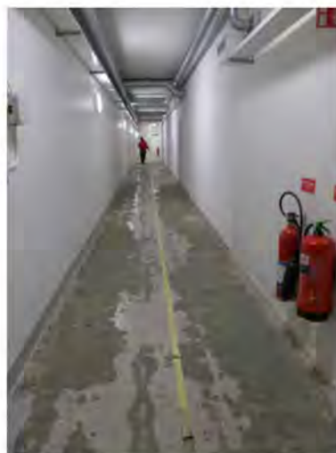
Korridor i tillbyggnaden under gården.
