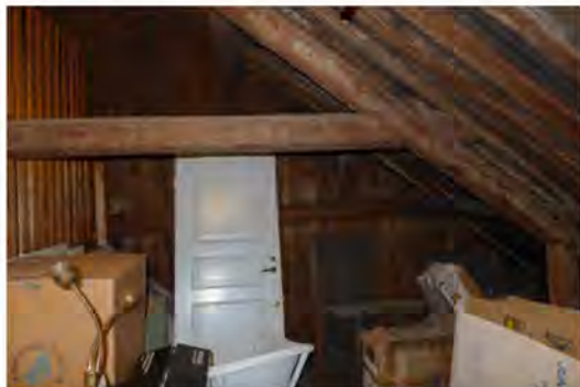
Kallvind med ålderdomligt brädundertak.
