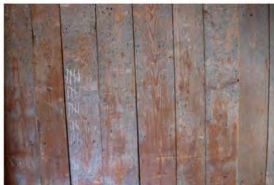
Brädvägg med ålderdomlig stänkmålning och kritmarkeringar.
