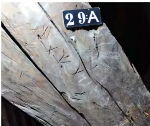
Exempel på olika timmermansmärkningar på takstolarnas olika delar. En egen klurig text/nummerkodning som timmermännen använt sedan medeltiden och fram till 1900-talet.
