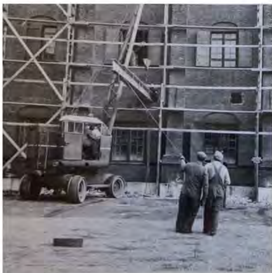
Foton från 1955 då bjälklaget förstärktes med 12 stålbalkar som togs in via öppningar i fasaden. Golven i bjälklagen mellan plan 1 och 2 samt 2 och 3 revs. (GSM)
