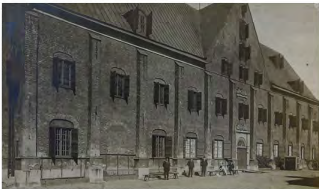
Foto på södra fasaden år 1913. Notera igenmurat fönster i bottenvåningen samt att kontreforeornas baser var putsade och försedda med en enkel plåttäckning - dvs ett enklare utförande än det ursprungliga. Kontreforeornas baser återställdes på 1930-talet då det profilerade listverket rekonstruerades. (GSM, fotograf Folke Reyde)
