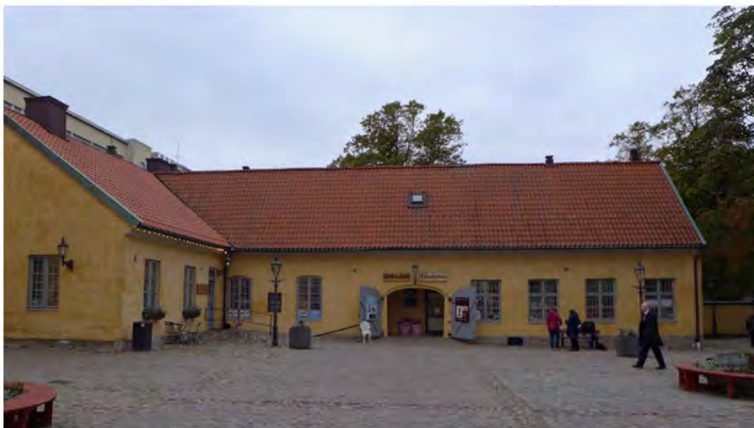
Postgatan 6 (Nordstaden 702:32), fasad mot Kronhusgården.
