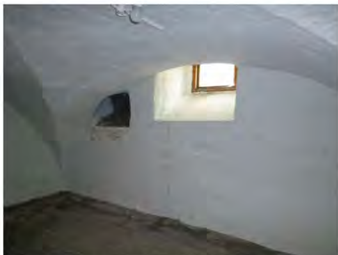
Kryssvälvad källare under huvudbyggnaden.
