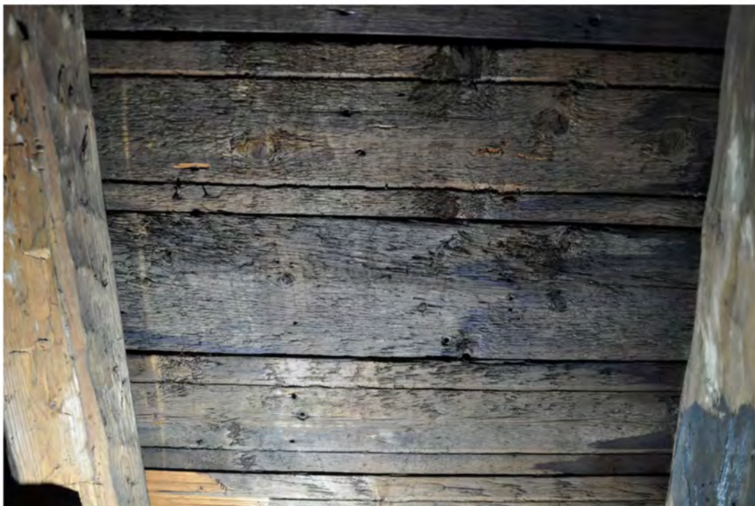
Sparrarna har spikhål med läktavstånd och brädundertaket har spår för avrinning av vatten och är troligtvis återvunnet.
