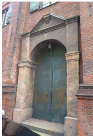
Portal mot norr.
