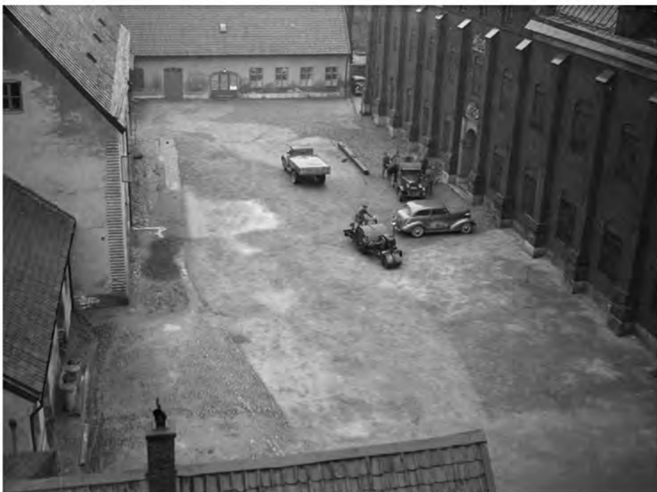
Pågående markarbeten på Kronhusgården på 1930-talet. Marken var belagd med kullersten. I fonden syns västra längan (Postgatan 6). Notera att fasaden mot gården var försedd med två entréer vid denna tid. (Kamerareportage)
