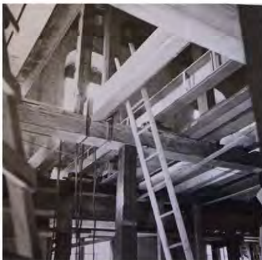
Foton från 1955 då bjälklaget förstärktes med 12 stålbalkar som togs in via öppningar i fasaden. Golven i bjälklagen mellan plan 1 och 2 samt 2 och 3 revs. (GSM)
