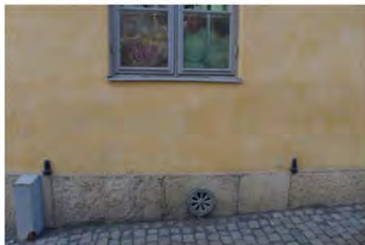
Fasad mot Postgatan med spår av tidigare entré till fd spruthuset i form av bevarade gångjärn i fasaden.
