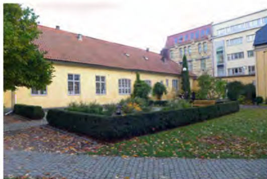
Fasad mot Kronhusparken. Ursprungligen var fasaden helt fönsterlös. De välvda fönstren tillkom troligtvis i slutet av 1800-talet eller början av 1900-talet. Korspostfönstren tillkom 1938.
