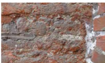
Äldre tegel med spår av slamning mot norr.
