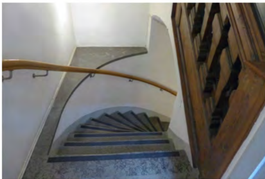
Huvudtrapphuset med kalkstenstrappa.
