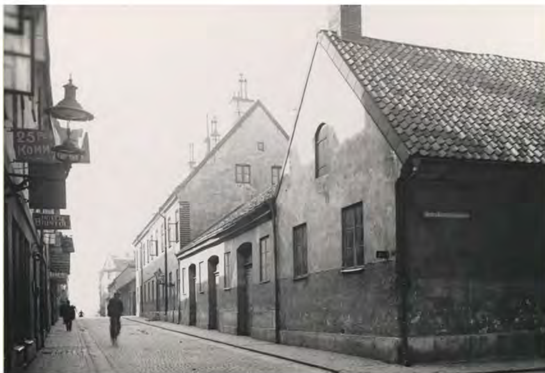
Fotografi från ca 1910-talet som bland annat visar två fönster i den östra gaveln samt det murparti från 1866 som förband Corps de Gardet med smedjan främst i bild. Denna del av tillbyggnaden revs 1971. (GSM)
