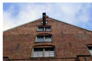
Kran för inlastning av materiel.
