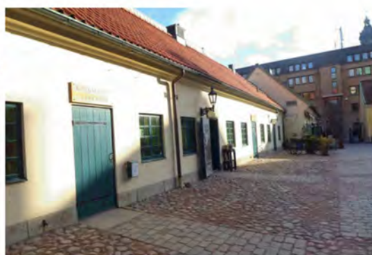
Verkstadslängans fasad mot Kronhusgården.
