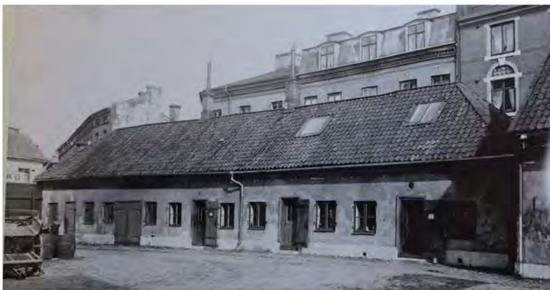
Bild från 1900-talets början visar att entréerna till verkstadslängan var försedda med dubbla dörrblad, där det yttre utgjordes av enkla bräddörrar med bandgångjärn medan de inre utgjordes av fyllnadsörrar med glasad och spröjsad övre del. Notera även verkstadslängans valmade sadeltak och de högresta skorstenarna, takfönstren och kalkstenssockeln. (GSM)
