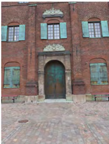
Portal mot syd.
