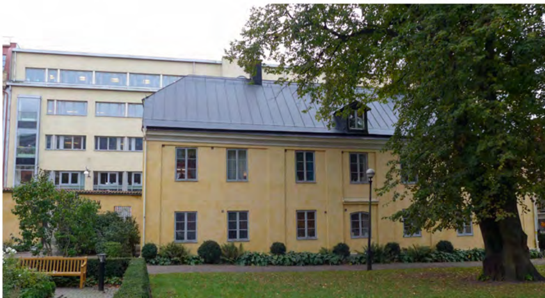
Fasad mot Kronhusgården.
