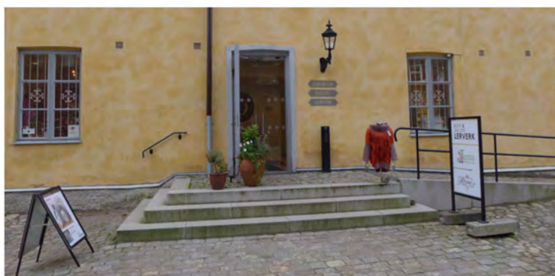
Entré från gården. Öppningen togs upp år 2014, i samma läge som den ursprungliga öppningen. Samtidigt tillkom en ramp.
