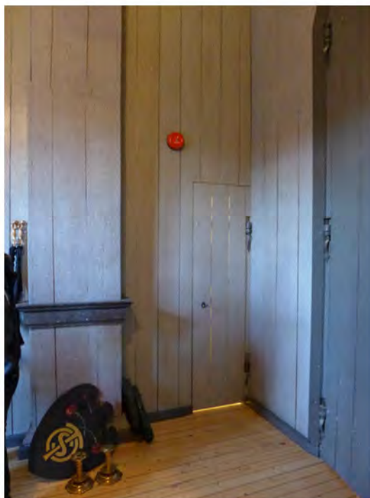
Hisschaktväggar utfördes med de äldre väggarna som förlaga och stänkmålades. Notera det mindre bräddörbladet till förrådet som tillverkats av äldre virke.
