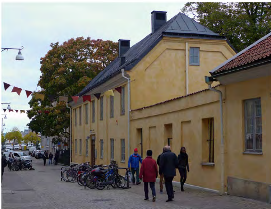
Fasad mot Postgatan samt det murparti (fd tillbyggnad) som sammanbinder Postgatan 4 och 6.
