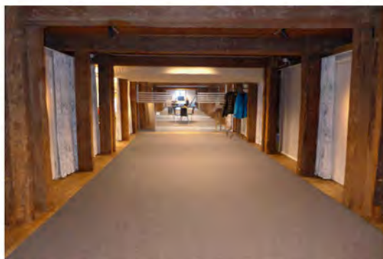
Takstolstassarna är kapade i nederkant och försedda med betongstöd.
