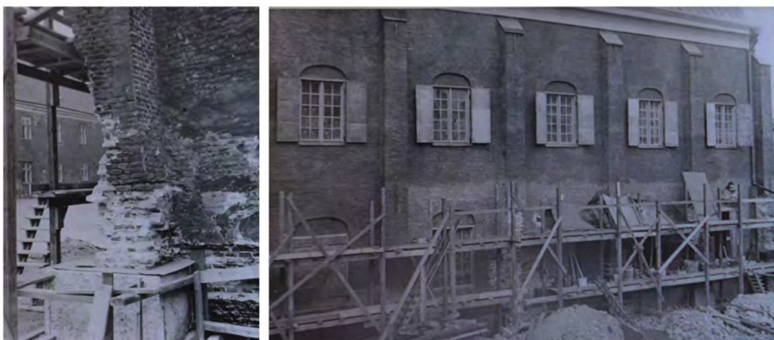
Fotografier från 1930-talets restaurering av bl a södra fasaden. Kontreforerna murades om och deras profilering återställdes. Bilderna visar också att delar av fasaden murades om. (GSM)
