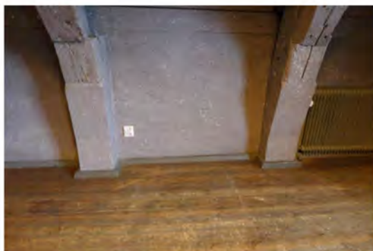
Takstolstassarna är kapade i nederkant och försedda med betongstöd.
