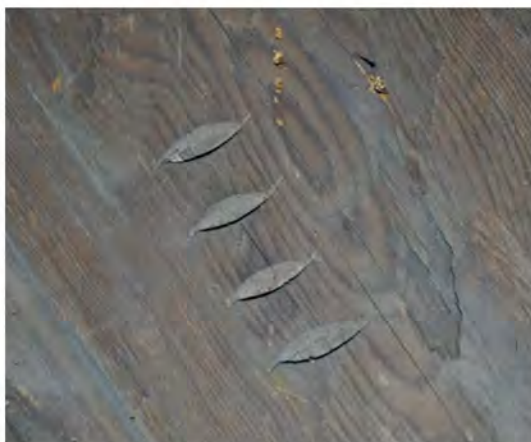
Exempel på olika timmermansmärkningar på takstolarnas olika delar. En egen klurig text/nummerkodning som timmermännen använt sedan medeltiden och fram till 1900-talet.
