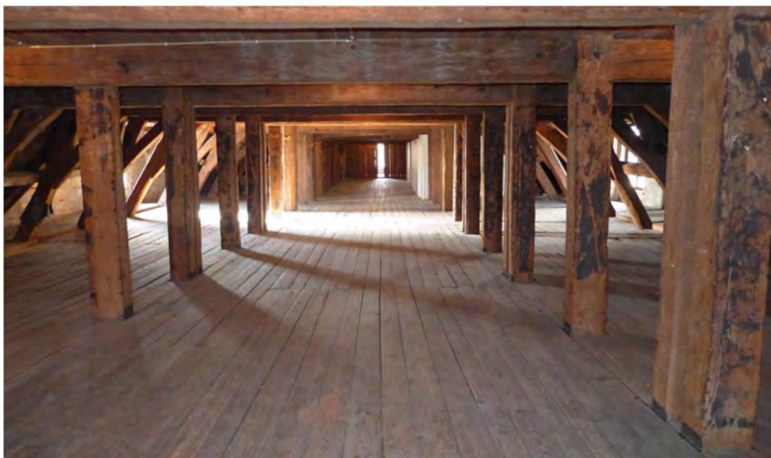
Plan 4 med sina dubbla rader av hängdockor. Vinden har en utpräglad ålderdomlig karaktär.
