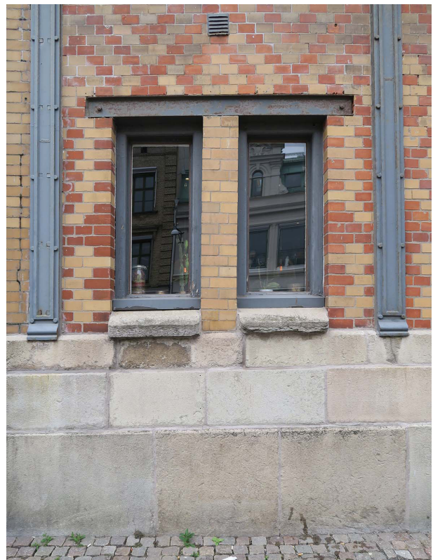
SMALA FÖNSTER URSPRUNGLIGA FRÅN 1906.
