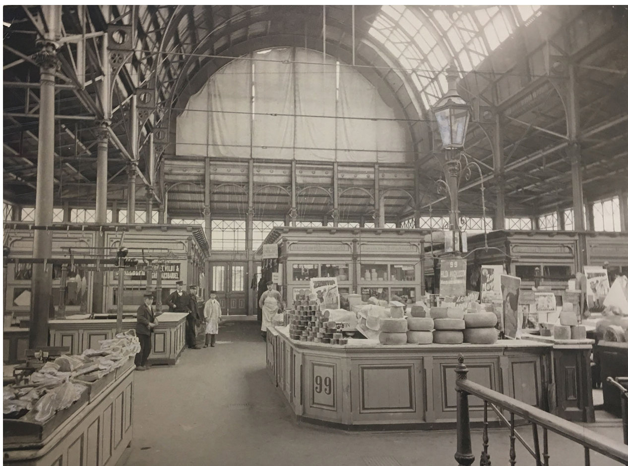
STORA SALUHALLEN INTERIÖR 1901, KÄLLA GSM.
