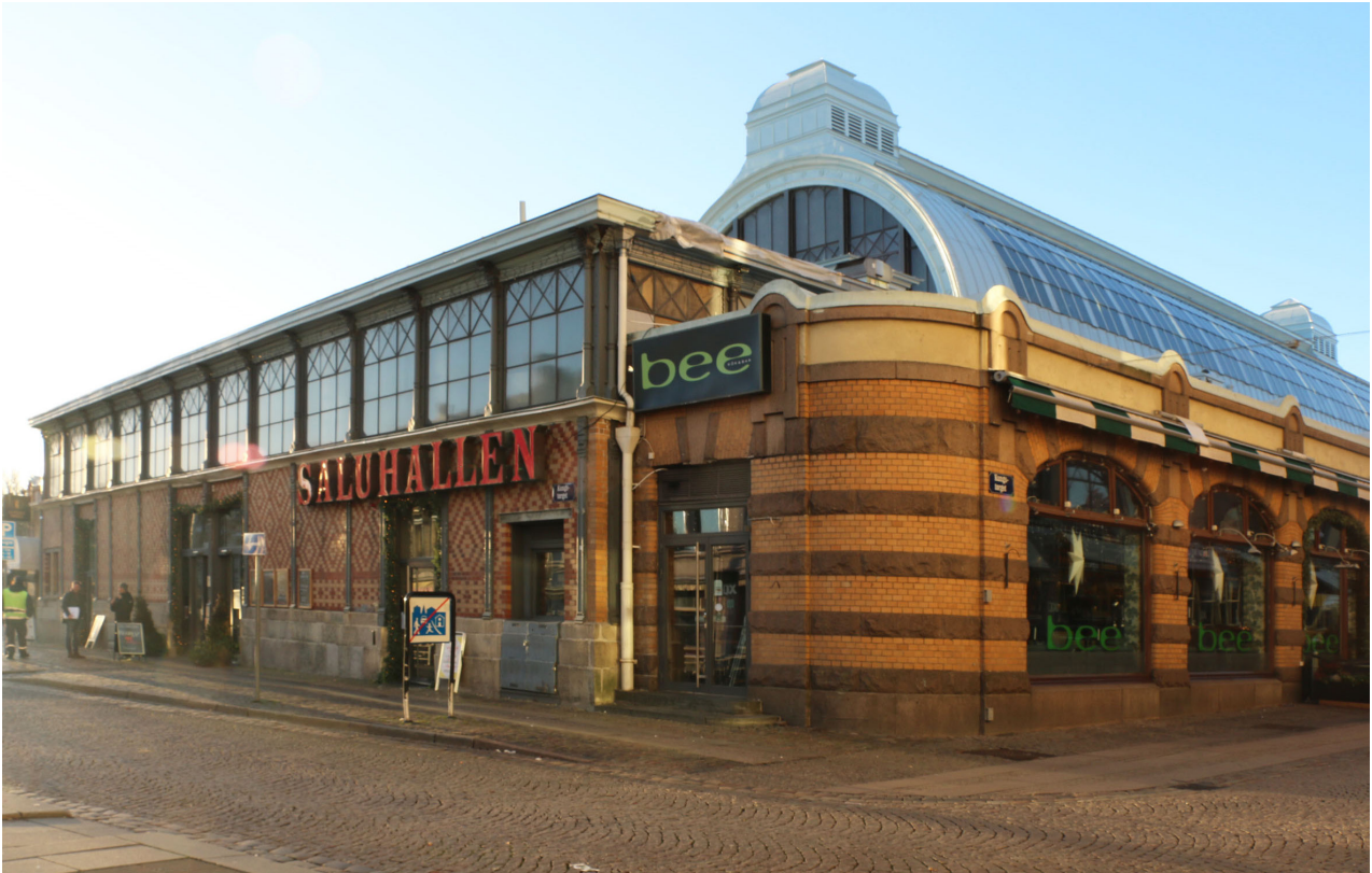
FASAD MOT ÖSTER/NORR 2018. DEN ÖSTRA GAVELN BYGGDES UT 1906 MED EN UTFORMNING LIKT DEN URSPRUNGLIGA BYGGNADSKROPPEN MED MÖNSTERMURAT TEGEL OCH KALKSTENSSOCKEL.
