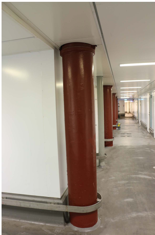
GJUTJÄRNSPEGLARE FRÅN 1888 I KÄLLARENS KORRIDOR.
