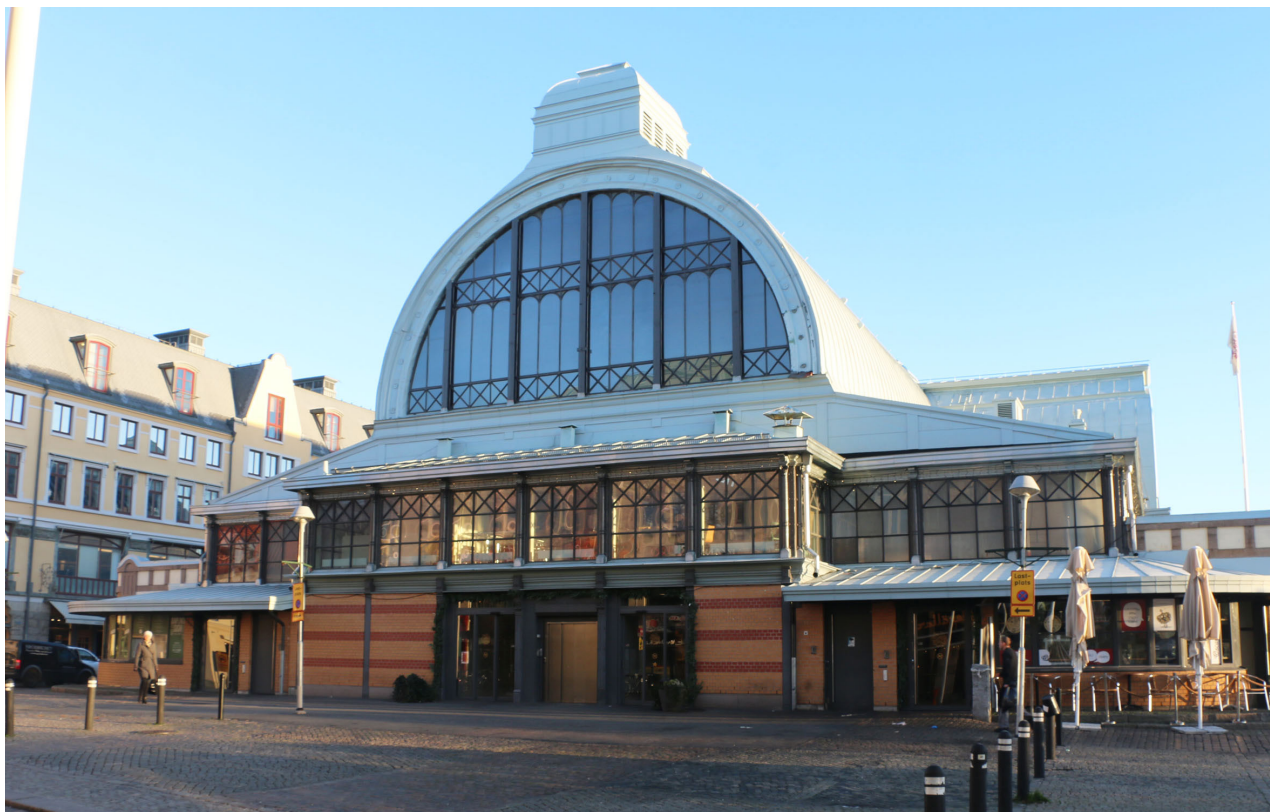
FASAD MOT VÄSTER 2018. TILL FORM OCH VOLYM ÅTERSKAPADES DEN VÄSTRA GAVELN I SAMBAND MED OMBYGGNADEN 2010-12. SAMTIDIGT BYGGDES DE LÄGRE BUTIKERNA MED FASADER I TEGEL PÅ VAR SIDA OM ENTRÉEN.
