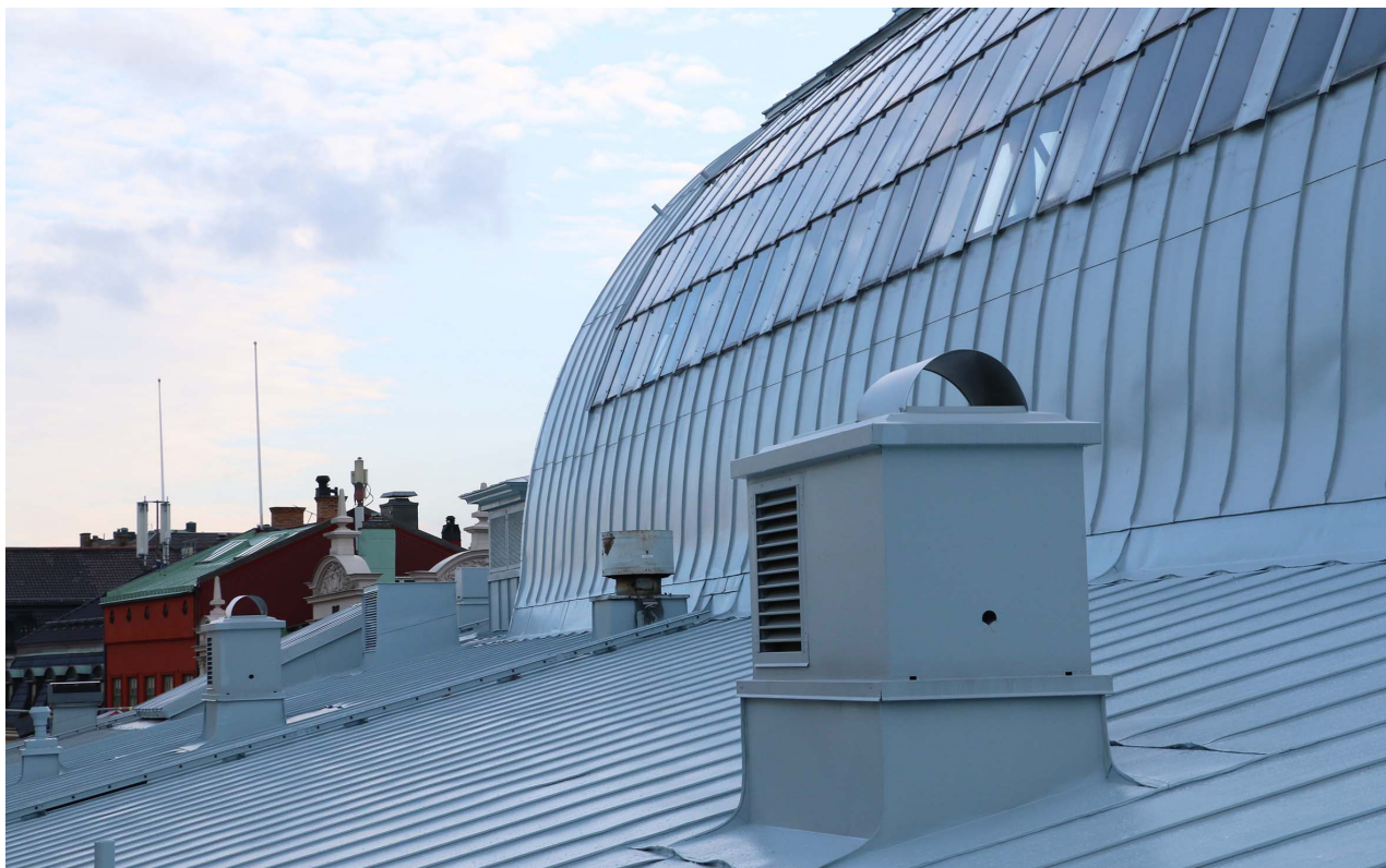
TAKET ÄR TÄCKT MED FALSAD PLÅT MÅLAD I EN ÄRGGRÖN KULÖR. ORIGINALTAKET VAR ISTÄLLET TÄCKT MED VALSAD SINUSKOORUGERAD PLÅT.
