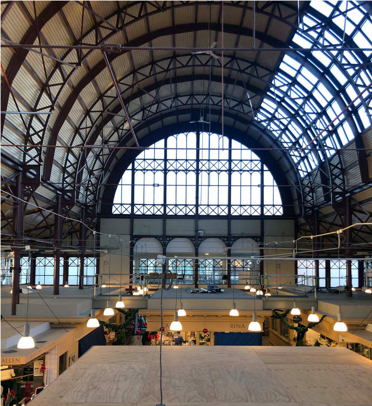
TAKKONSTRUKTIONEN I STÅL TILLVERKAD AV GÖTEBORGS MEKANISKA VERKSTAD 1888. VALVBÅGARNA FÖRSTÄRKTES 1913.
