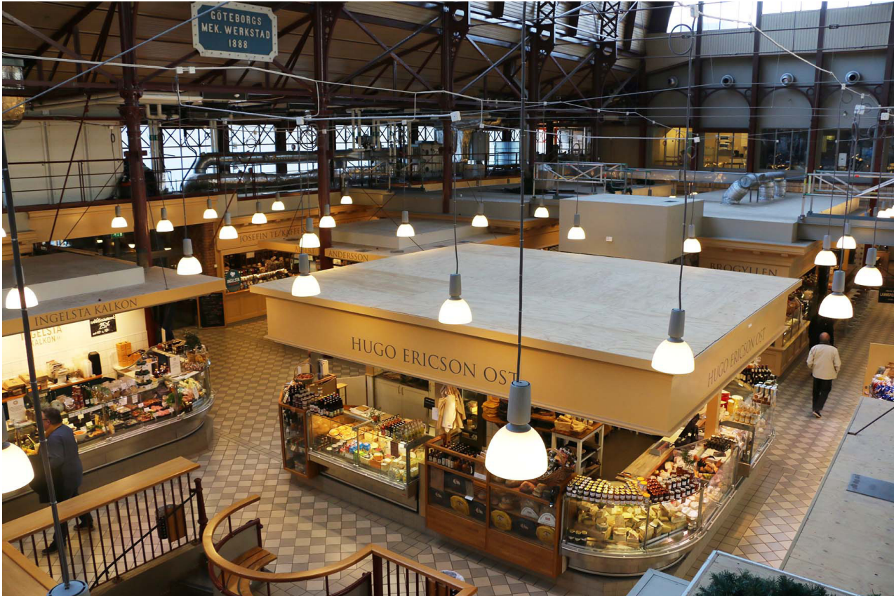
SALUBODARNAS KVARTER. I SAMBAND MED OMBYGGNADEN 2010-12 NYTILLVERKADES SALUBODARNA MED UPPMÄTNINGAR AV DE URSPRUNGLIGA SOM FÖRLAGA. DAGENS BODAR HAR VENTILATION PLACERAD I TAKET.
