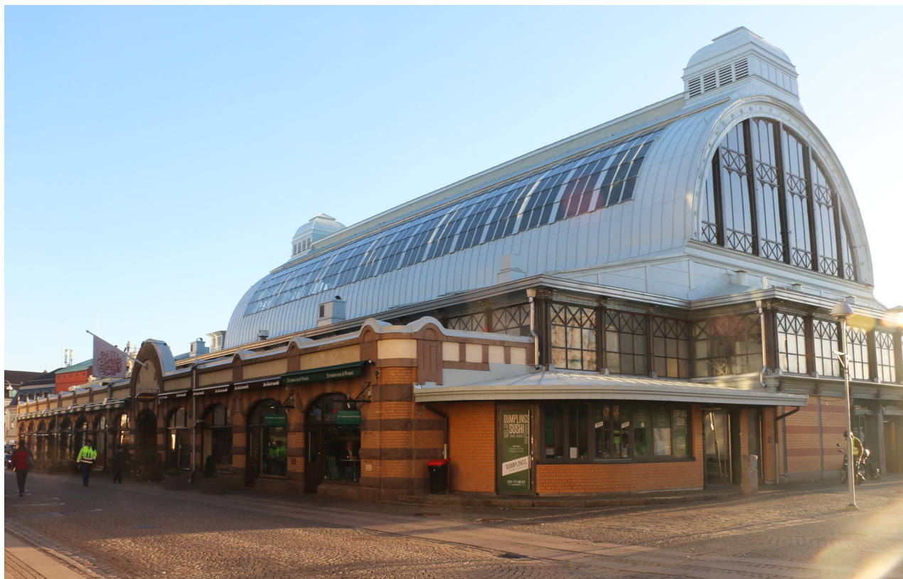
FASAD MOT NORR/VÄSTER 2018. DE STORA KUPOLÖPPNINGARNAS GJUTJÄRNSFÖNSTER, TAKFÖNSTER OCH FÖNSTERBANDEN I GJUTJÄRN RUNT BYGGNADEN SLÄPPER IN DAGSLJUS TILL DEN STORA HALLEN.
