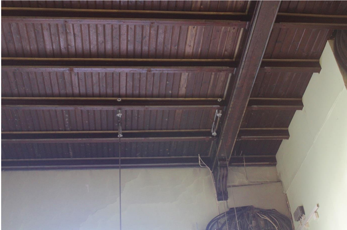
Mörkbetsat trätak med figursågade konsoler.
