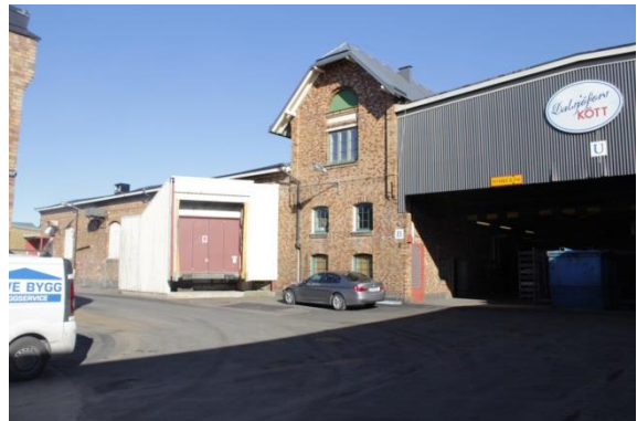
Ombyggd förbindningshall med anslutande slakthus för svin till vänster.
