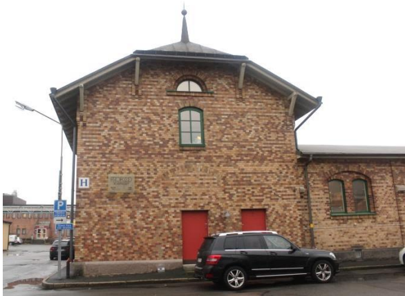
Byggnadskropp i två våningar med valmat bandtäckt plåttak.
