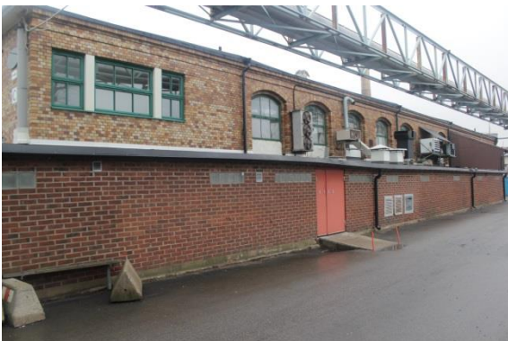
Slakthus för kalvar från 1912 med tillbyggnad i tegel framför.
