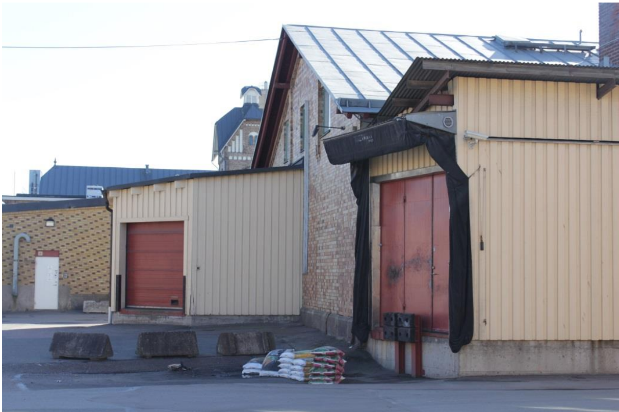
Tillbyggnader döljer delvis hela fasader och utgör tydliga kontraster mot de ursprungliga fasadernas karaktär.
