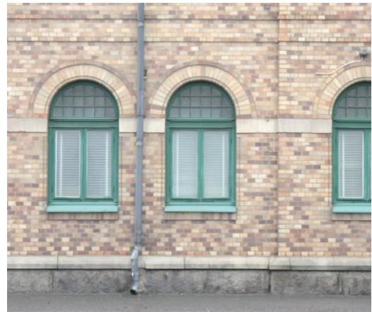
Granitklädd sockel, fasad klädd med gult förbländertegel och bågformiga treluftsfönster.
