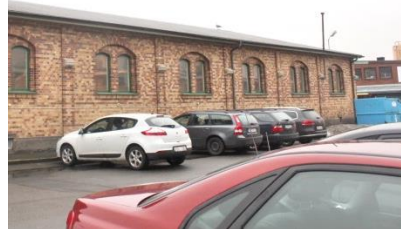
Hallbyggnad i en våning.
