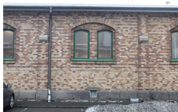
Smala kopplade enlufts-fönster mellan murade pilastrar.
