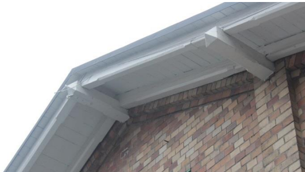
Utskjutande takfot med taktassar och synligt undertak i trä.
