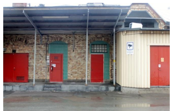
Originalfasad med tillbyggnad i trä och ombyggda dörröppningar.
