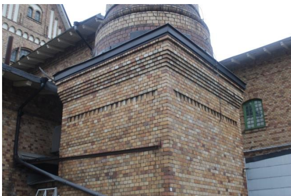
Mönstermurning i skorstenens bas.
