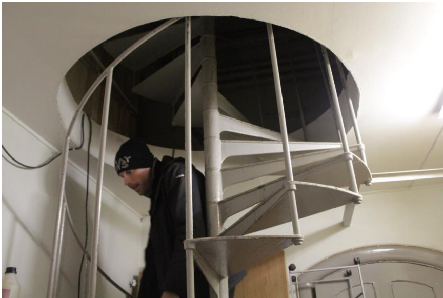
Spiraltrappa i järn.
