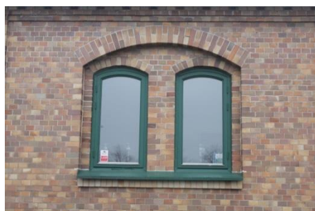
Smala enlufts-fönster i försänkt murat stickbågevalv.
