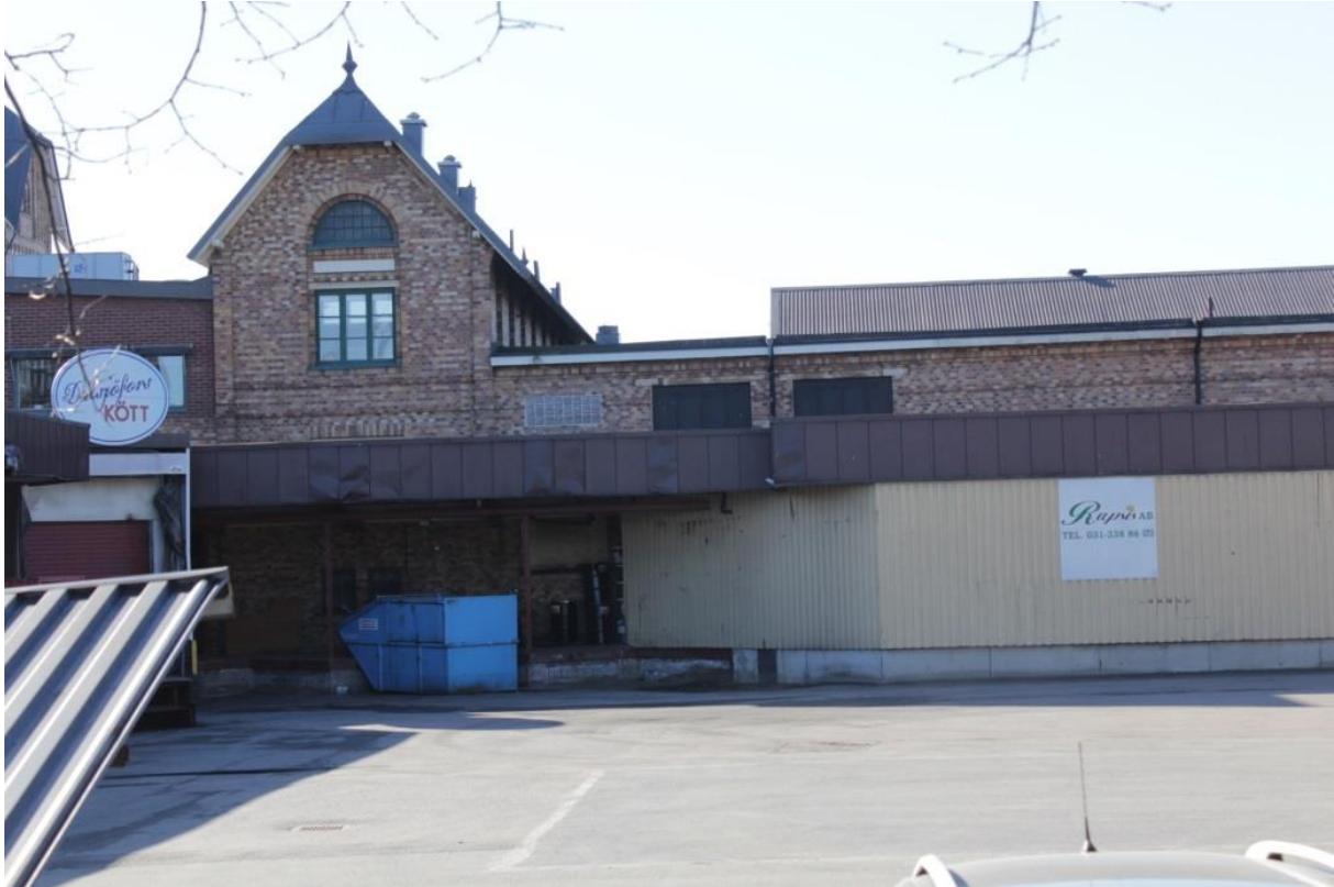
De branta plåttaken ger slakthusområdet en karakteristisk profil även då en stor del av fasaden döljs av tillbyggnader.
