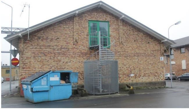
Gavelfasad mot nordöst – norra slaktstallet.
