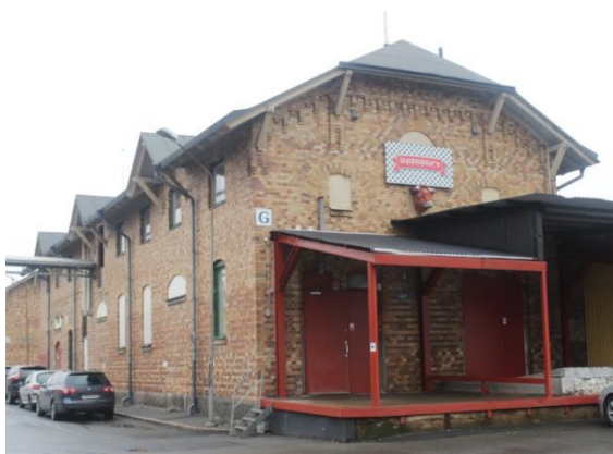
Gavelfasad döljs delvis av senare tillbyggda skärmtak.
