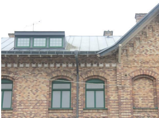
Låg takkupa med spröjsade fönster i takfall.
