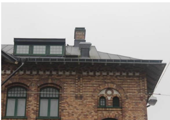
Välvda treluftsfenster med spröjsad stickbågig överluft, Kraftigt takutsprång och låg takkupa i takfallet.
