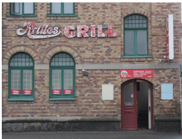
Granitklädd sockel, fasad klädd med gult hårdbränt tegel. Rundbågiga treluftsfenster i första våningen.
