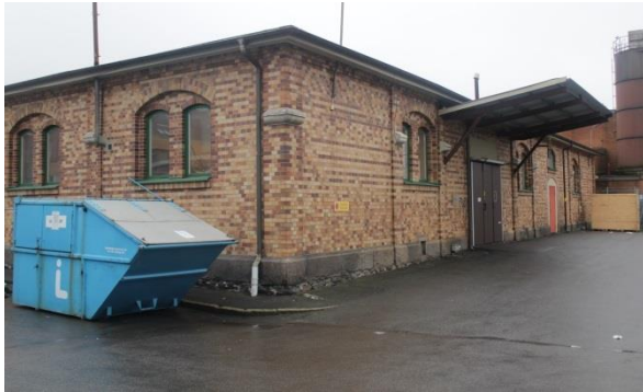
Port mot nordväst med tillbyggt skärmtak.
