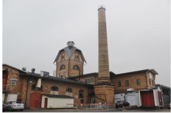
Skorsten och fasad mot öster.
