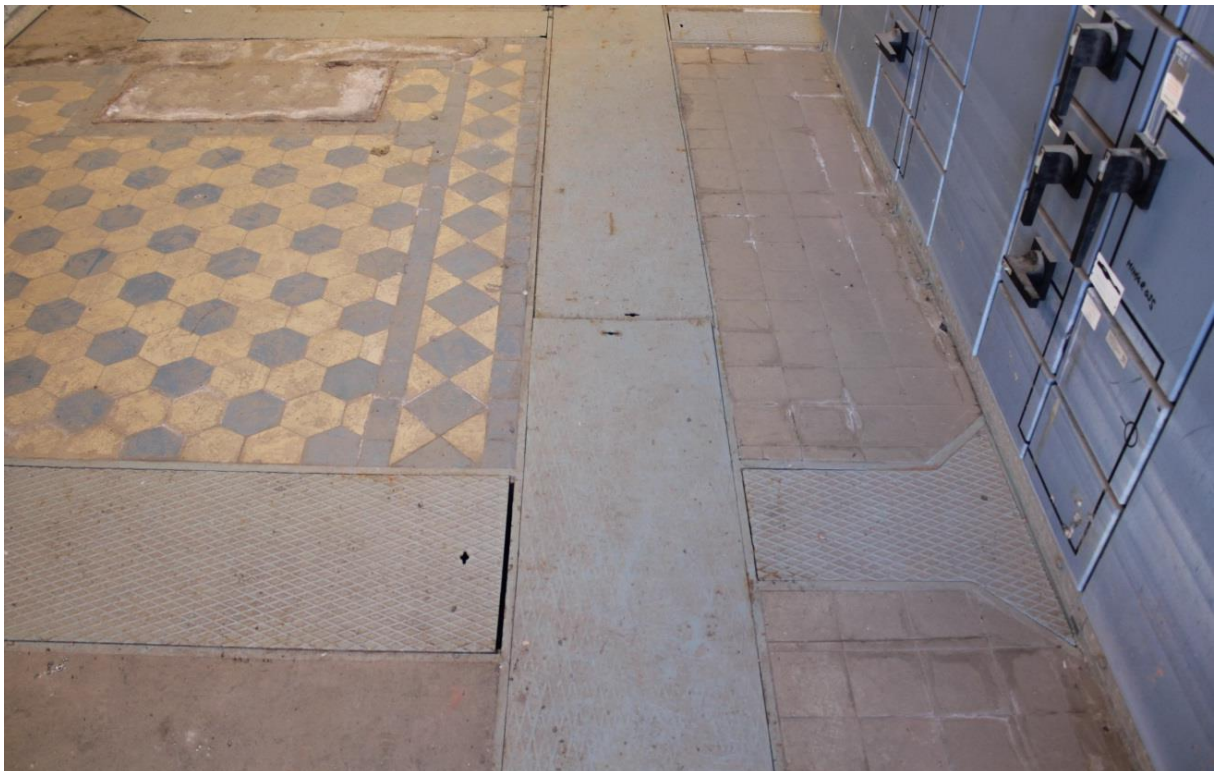
Keramikgolv i f.d. maskinhus.
