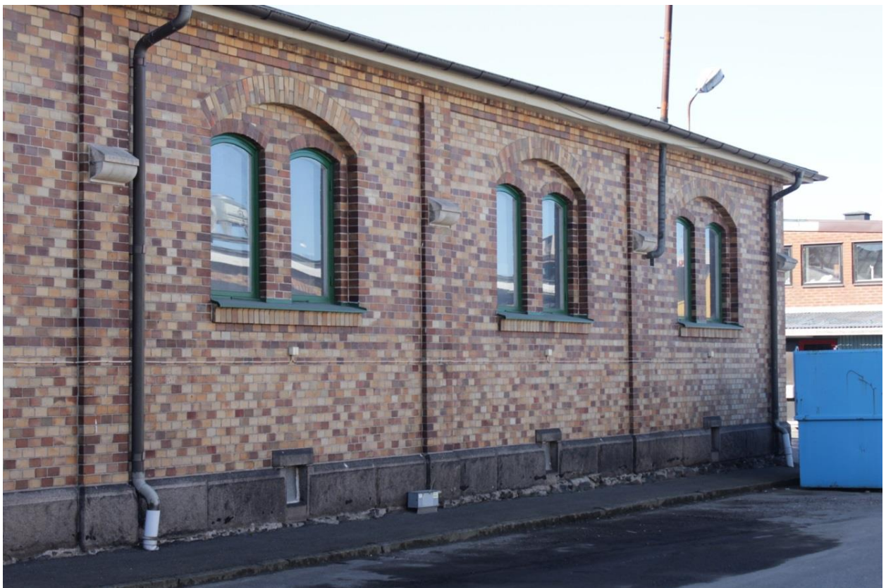
Byggnaderna har en delvis välbevarad originalkaraktär.
