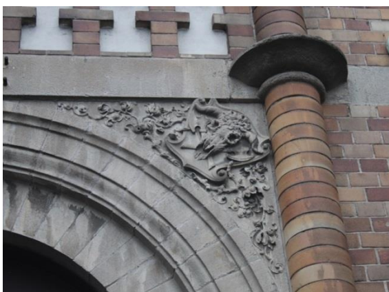
Symbol för slakteriväsendet i sten. På motstående sida finns Göteborgs vapen. Formtegel och mönstermurningar inramar entrén.
