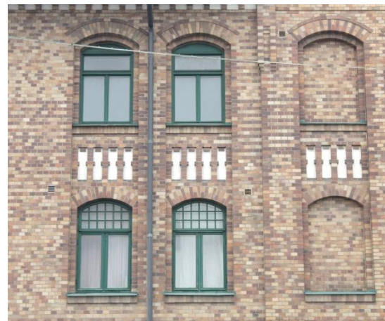
Fasad med murade detaljer. Fönster med stickbågeform och spröjsad överluft.
