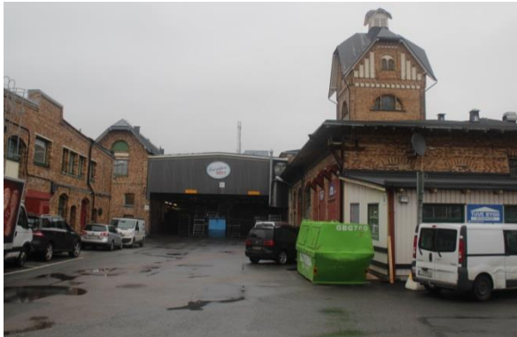
Maskinhus och vattentorn till höger i bild.
