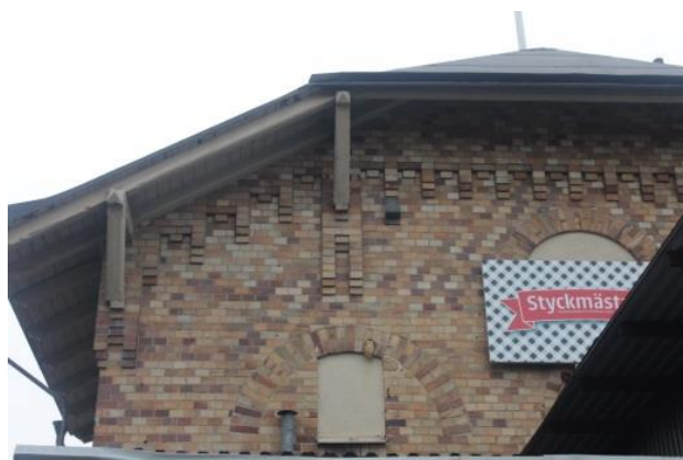
Valmat tak med kraftigt utskjutande takfot och konsoler i trä.
