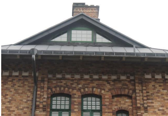
Takkupa utformad som en förlängning av taknocken.
