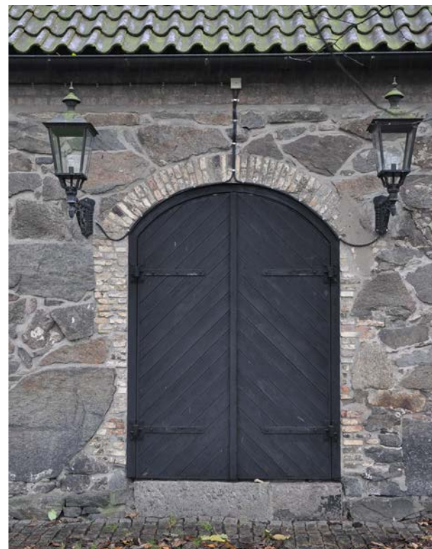
Parportar av modern karaktär men den bastanta stommen i natursten är ursprunglig från 1770-talet.
