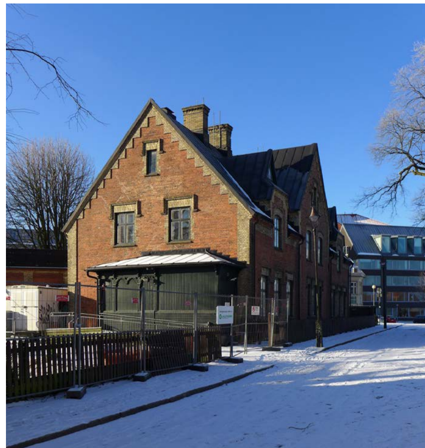
Klippan 7, den tidigare skolbyggnaden på Klippgatan.
