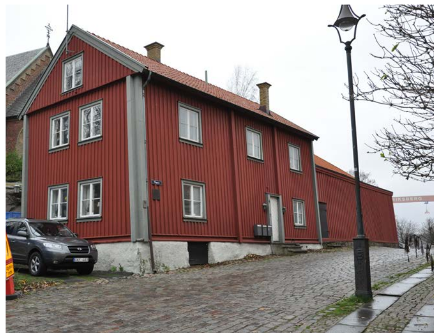
Röda byggnaden från sydöst. Byggnaden restaurerades 1968-69 då all panel förutom på baksidan (väster) och mot förråden byttes till modern lockpanel tillsammans med samtliga fönster samt yttertakets. Den utvändiga karaktären har dock bevarats.
