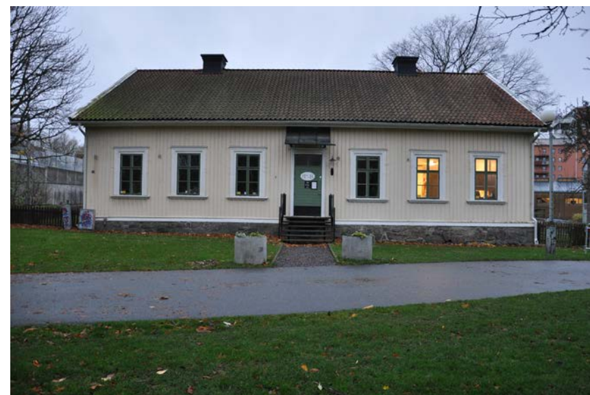
Den nordöstra långsidan har en nyligen utbytt dörr till butiken i bottenvåningen.
