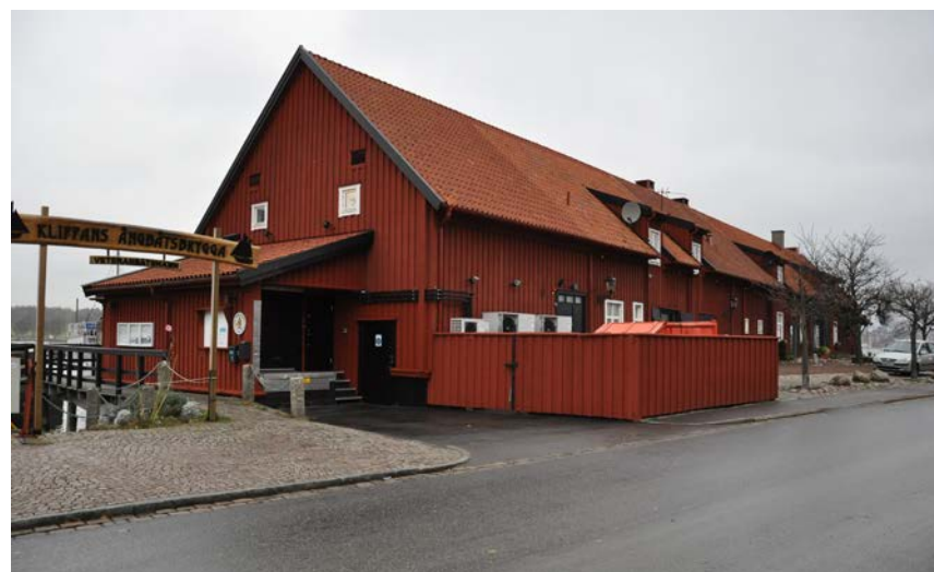
Fasadbilder av Sjömagasinet sydvästra gavel (nedan) och östra långsida (över).
