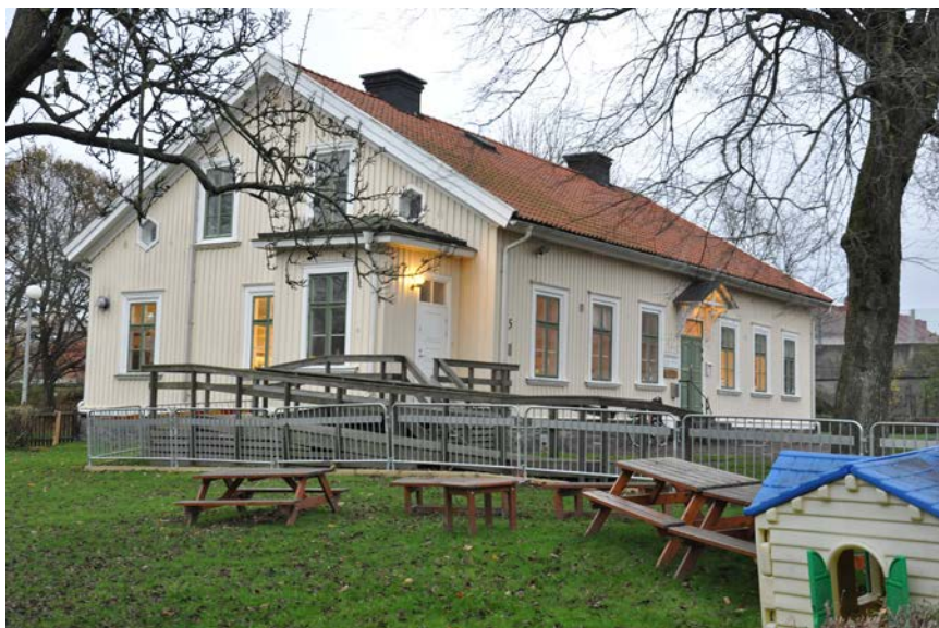
Tillgänglighetsanpassning på den nordvästra gaveln mot älven.
