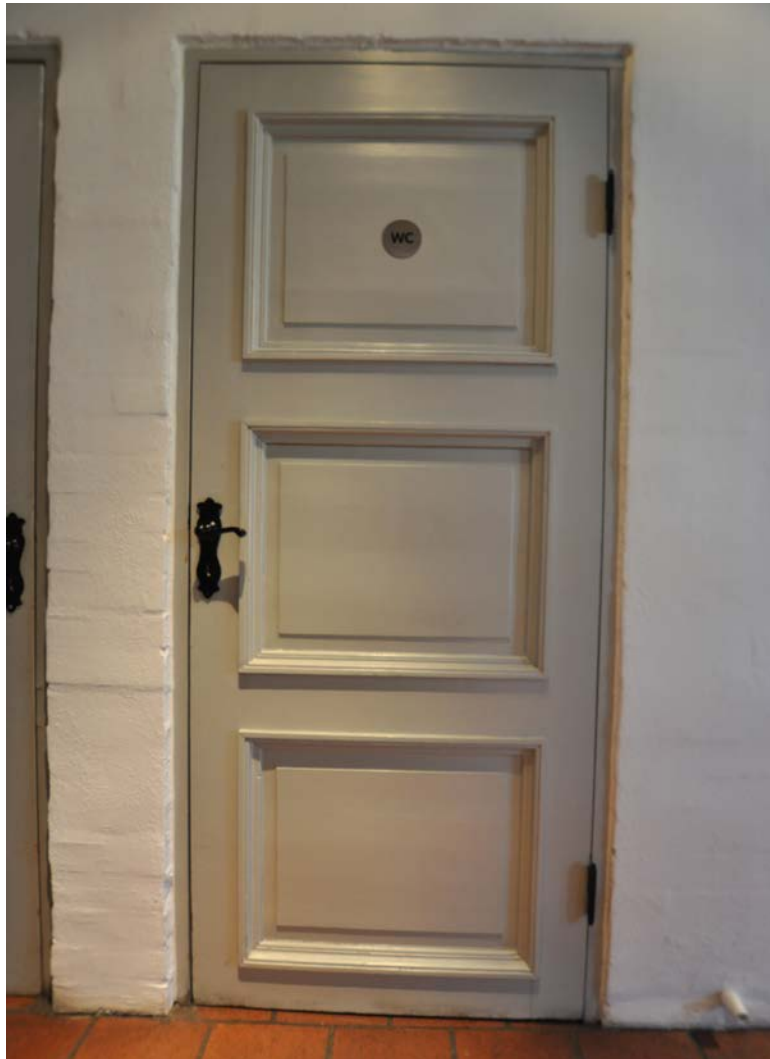
Äldre spegeldörr till toalett.
