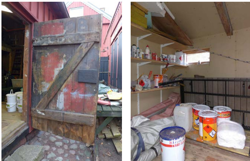
Detalj av dörr i förrådslänga och interiör av isolerad och inredd förrådsdel i södra delen av längan med avträden.
