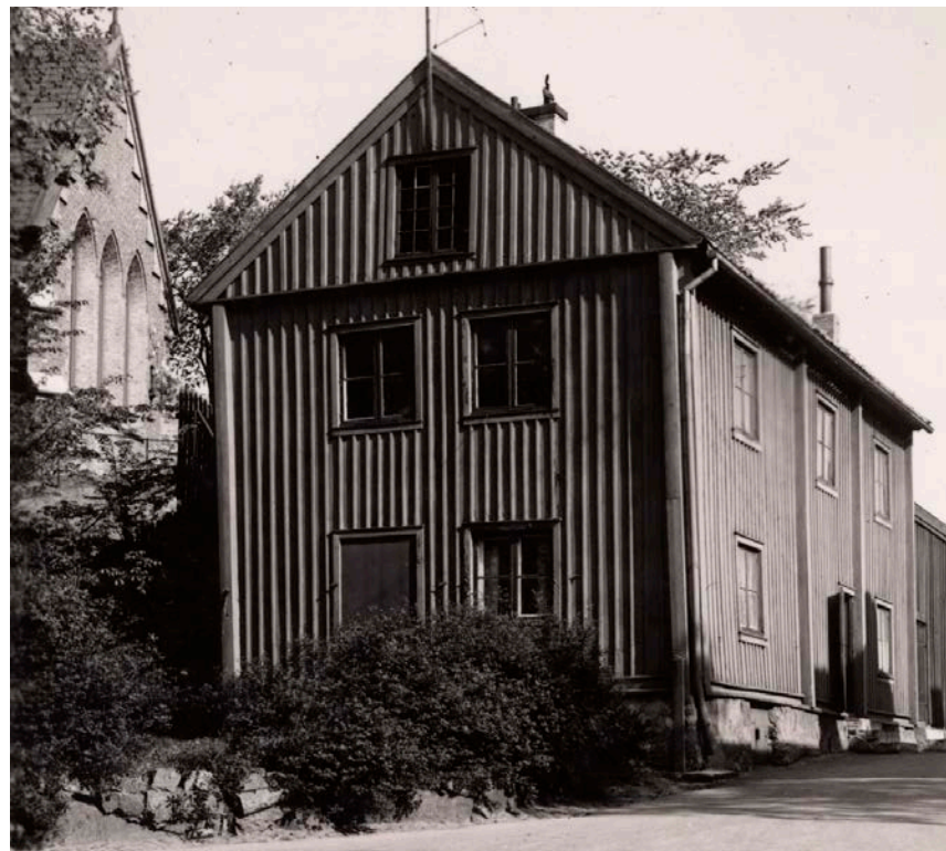
Bild från 1940 tagen från sydost med S:ta Birgittas kapell i bakgrunden. På gaveln syns bl a ett blindfönster i bottenvåningen. Källa: GSM
