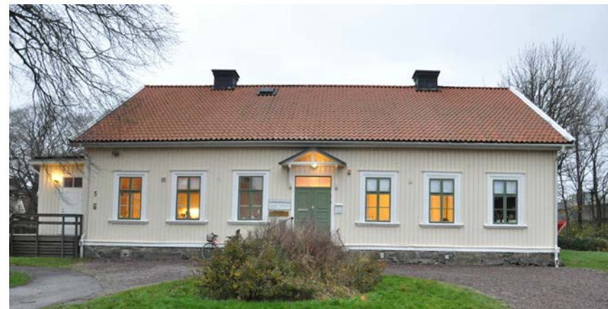
Byggnadens exeriör har förändrats mycket lite sedan uppförandet 1863 med undantag för renoveringar efter branden på 1970-talet då bl a taket rekonstruerades.
