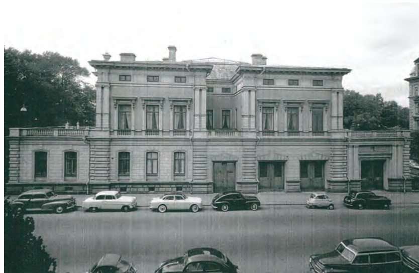
Wernerska villans södra fasad 1958. Fotot tillhör GSM.
