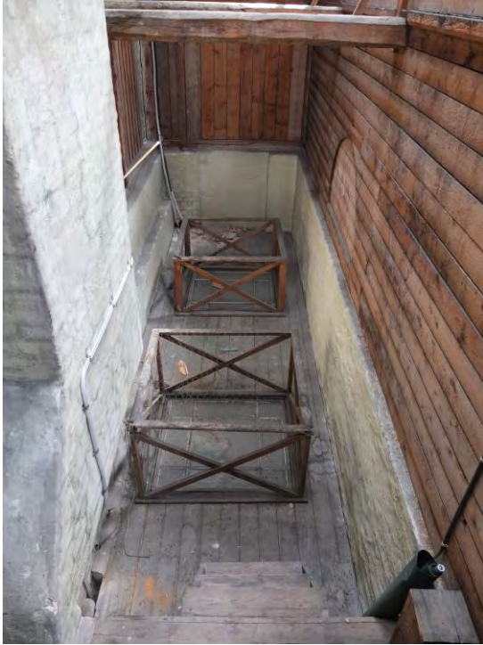
De mindre lanterninerna med skydd runt om.
