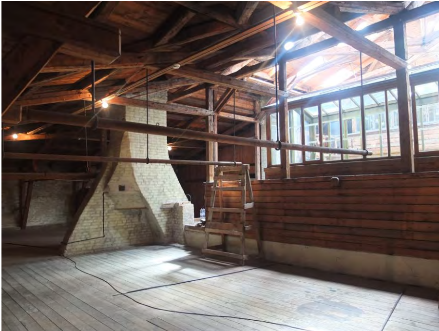
Torkvinden med murstock och lanterninkomplex samt takstol.
