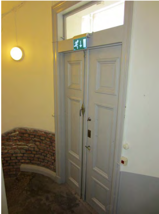
Trapphuset med huvudentrén mot gården.
