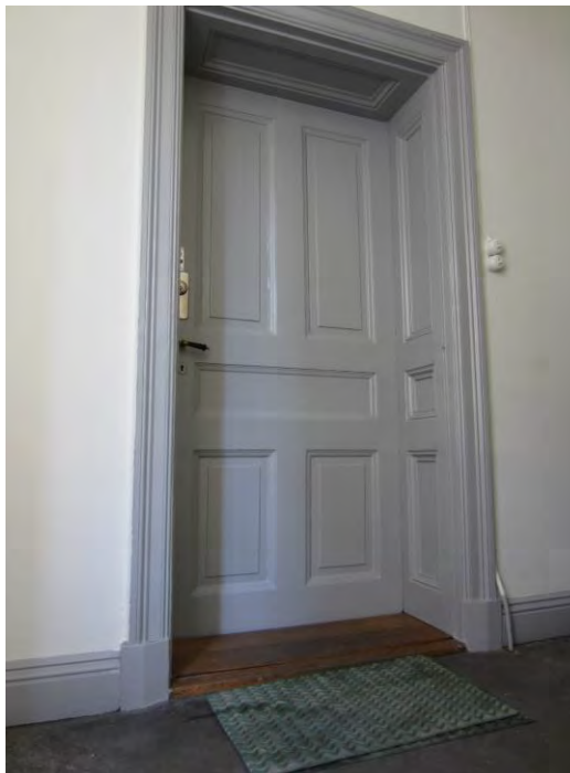
Ursprunglig dörr till övre våningen.
