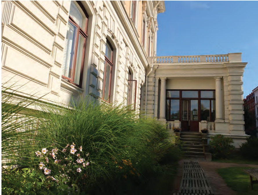
En del av trädgården som restaurerades 2007. Loggian glasades in vid renoveringen 1958.
