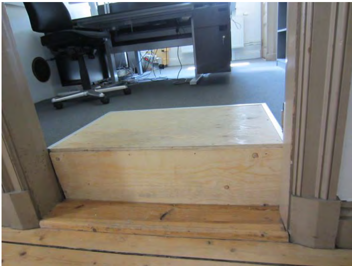
Påbyggnad på golv med plywood och matta.
