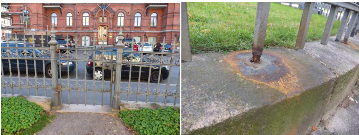
Gjutjärnsstaket med grind mot Chalmersgatan.
