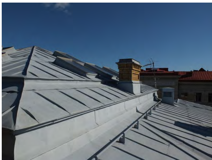
Södra takfallet med målad plåt och skorstenar i gult tegel.
