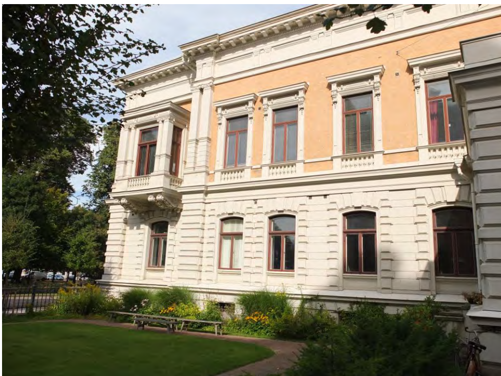
Fasaden mot Chalmersgatan med burspråk och den återskapade trädgården som ingår i byggnadsminnet.
