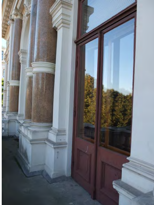
Fönsterdörr till balkong mot Parkgatan.
