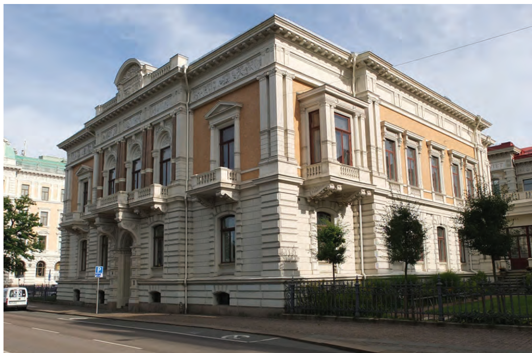
Byggnadens fasad från nordväst.
