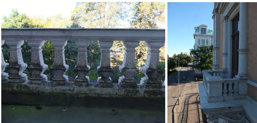
Balkongräcke med balustrad mot Parkgatan.
