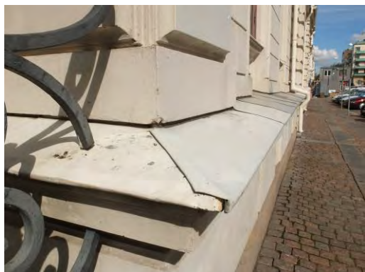
Intäckningsplåtar på fris i varierad utformning.
