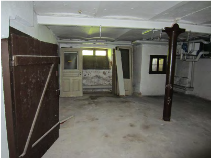
Rum 112 med fönster, dörrar, pelare och välvt betongtak.
