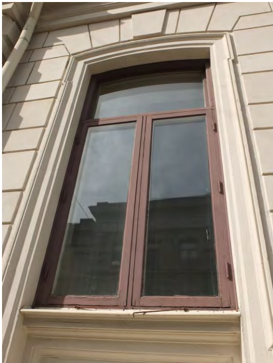
Utbytt fönster mot Storgatan.
