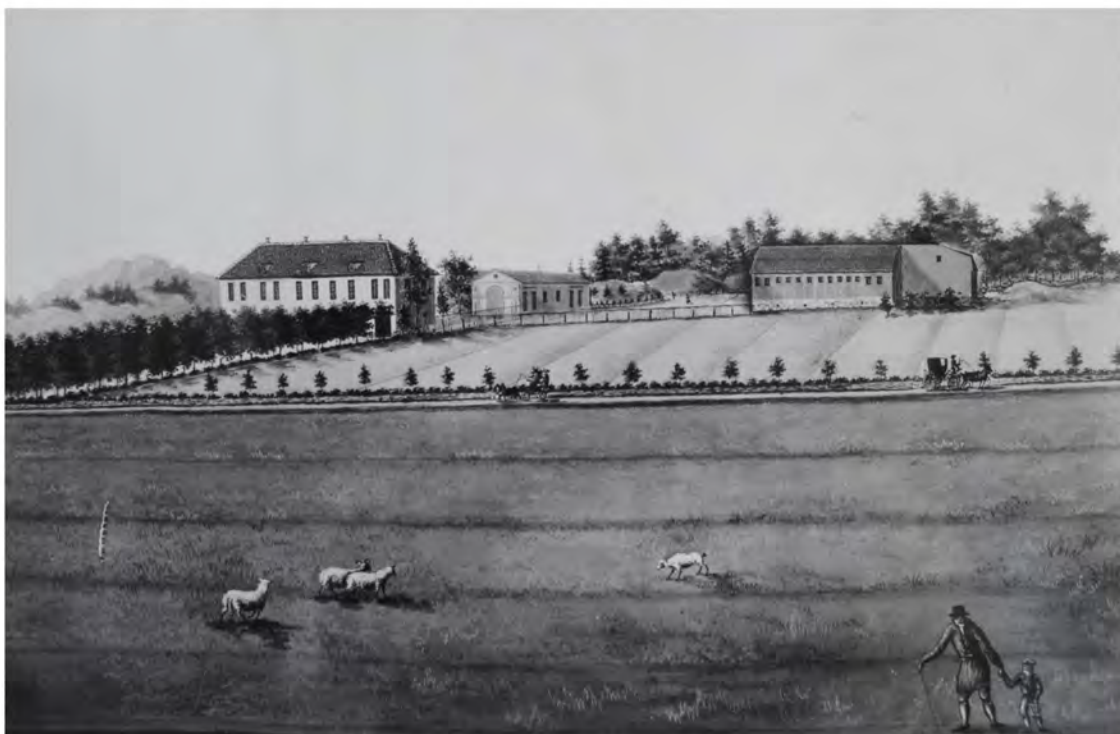
Detalj av gouachemålning, tidigt 1800-tal. Det valmade taket med takkupor är tydligt. Genomfarten på manbyggnadens västra gavel kan skönjas. Direkt höger om manbyggnaden ligger västra flygeln. Till höger i bild stall och ladugård. Källa: GSM
