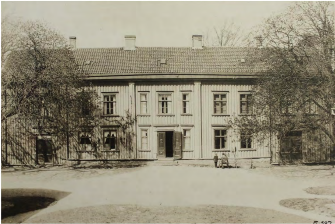
Manbyggnadens södra fasad. Sannolikt 1920-tal. Källa: GSM
