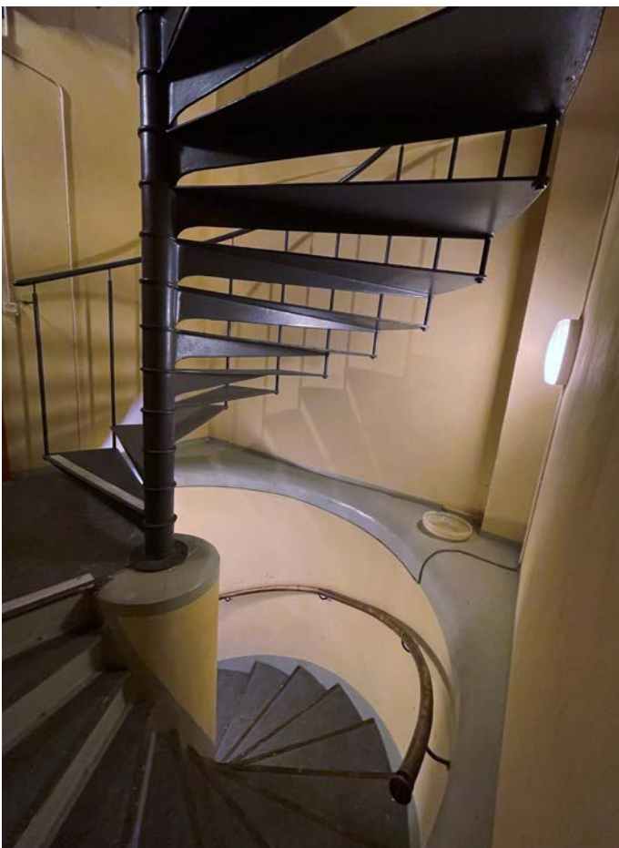
TRAPPHUS VÄST, MED GJUTJÄRNSTRAPPA.
