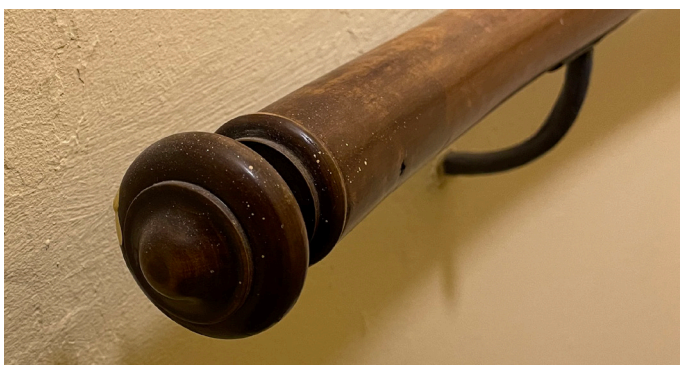
TRAPPHUS VÄST, DETALJBILD PÅ HANDELDARE AV TRÄ.
