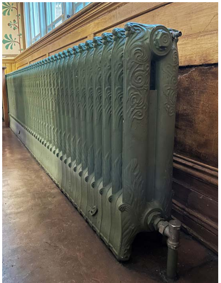
ÄLDRE GJUTJÄRNSRADIATOR MED DEKOR.
