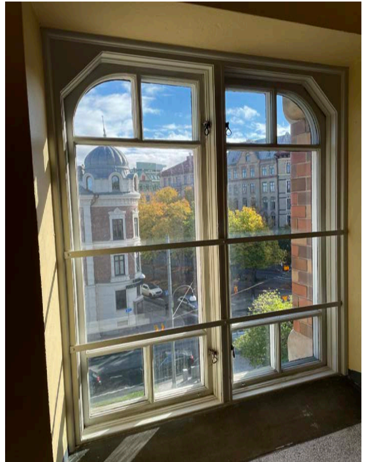
TRAPPHUS ÖST, URSPRUNGLIGT (1926) FÖNSTER PÅ VÅNING 6.
