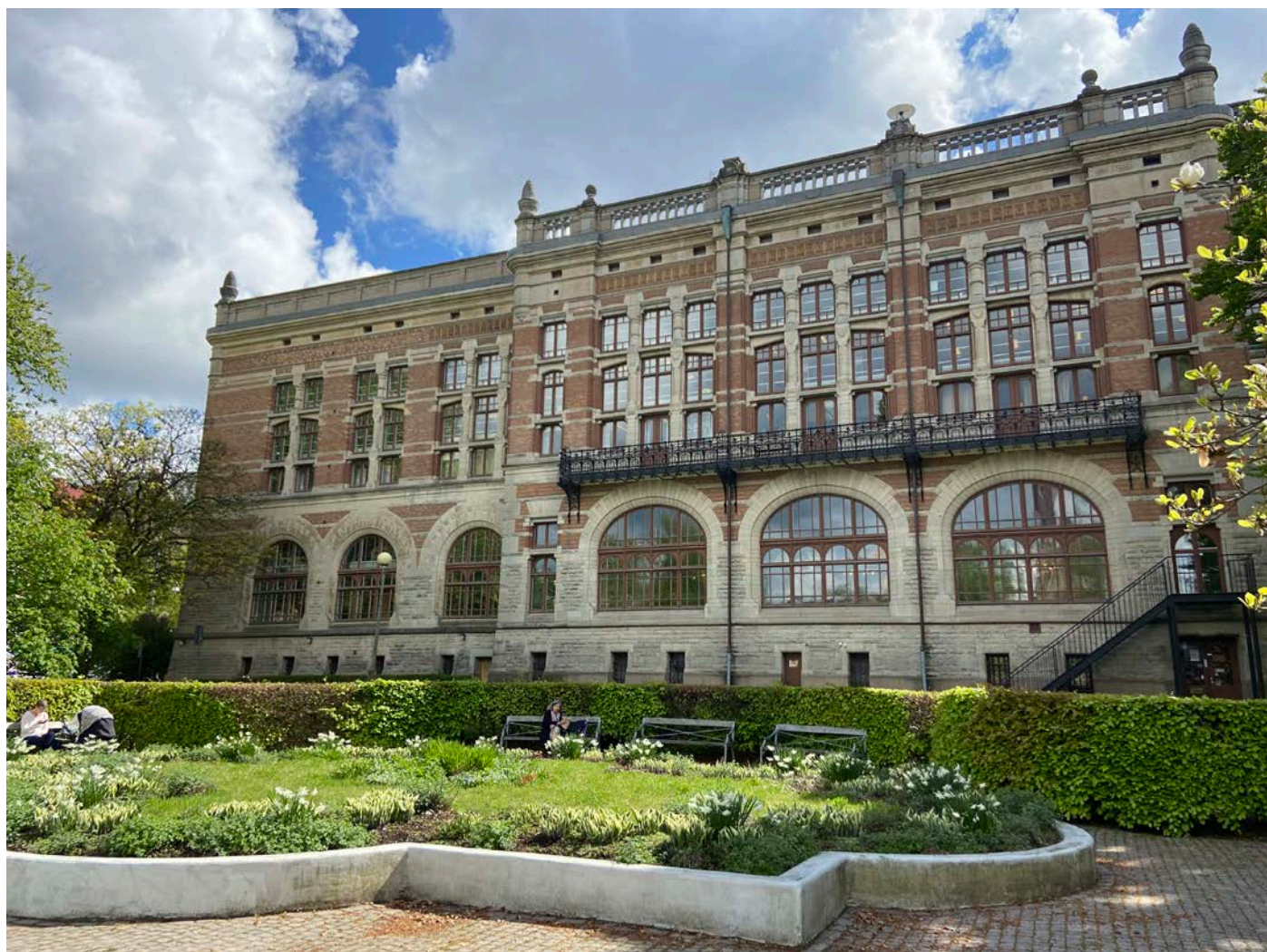
FOTO PÅ BYGGNADEN I NORR MOT HAGA KYRKOPLAN MED SMIDESBALKONGEN MED SITT DEKORATIVA SRÄCKE.
