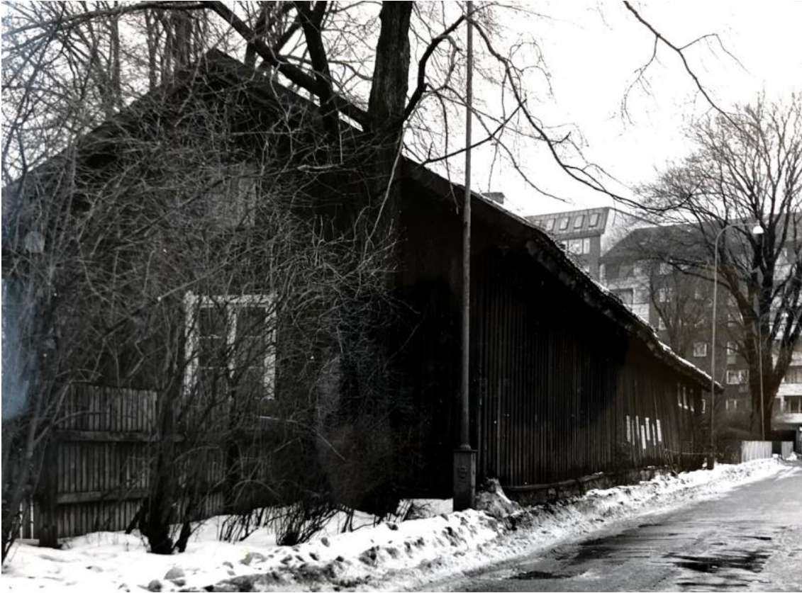
VÄSTRA SAMT NORRA FASADEN.
