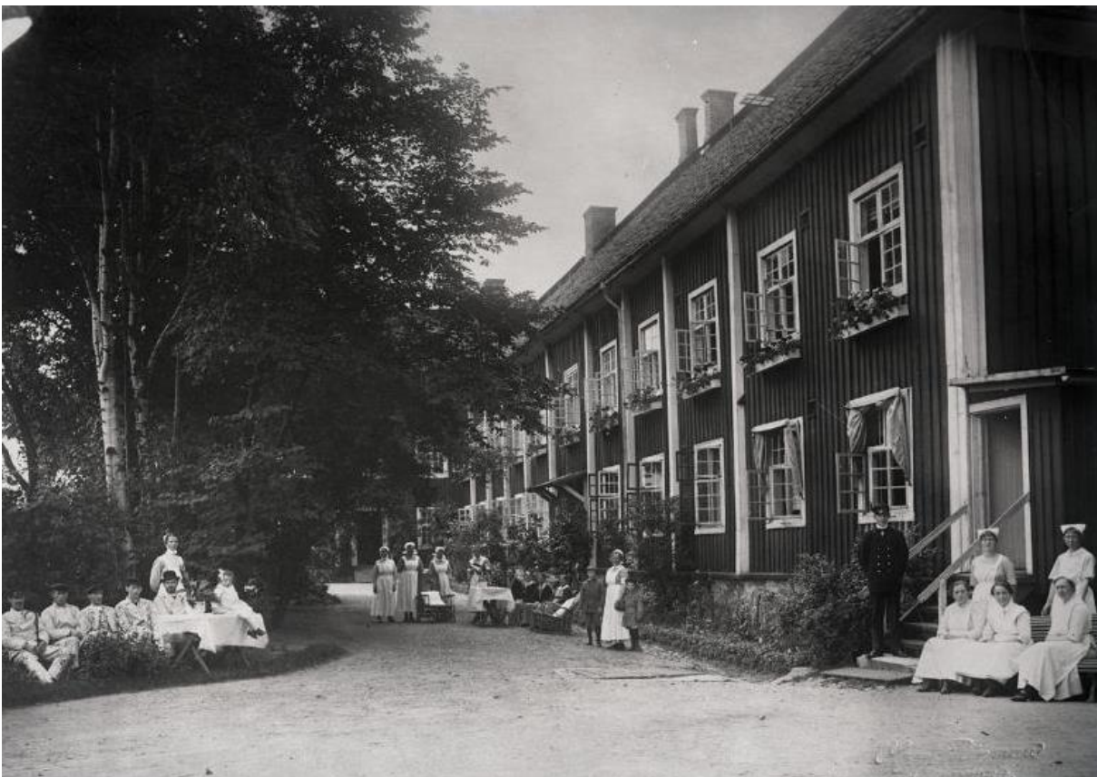
BYGGNADENS GÅRDSFASADER, TROLIGEN NÅR DET ANVÄNDES SOM TUBERKULOSSJUKHUS. VY MOT VÄSTER. FOTOGRAFIET SANNOLIKT TAGET PÅ 1910-TALET. (GÖTEBORGS STADSMUSEUM)
