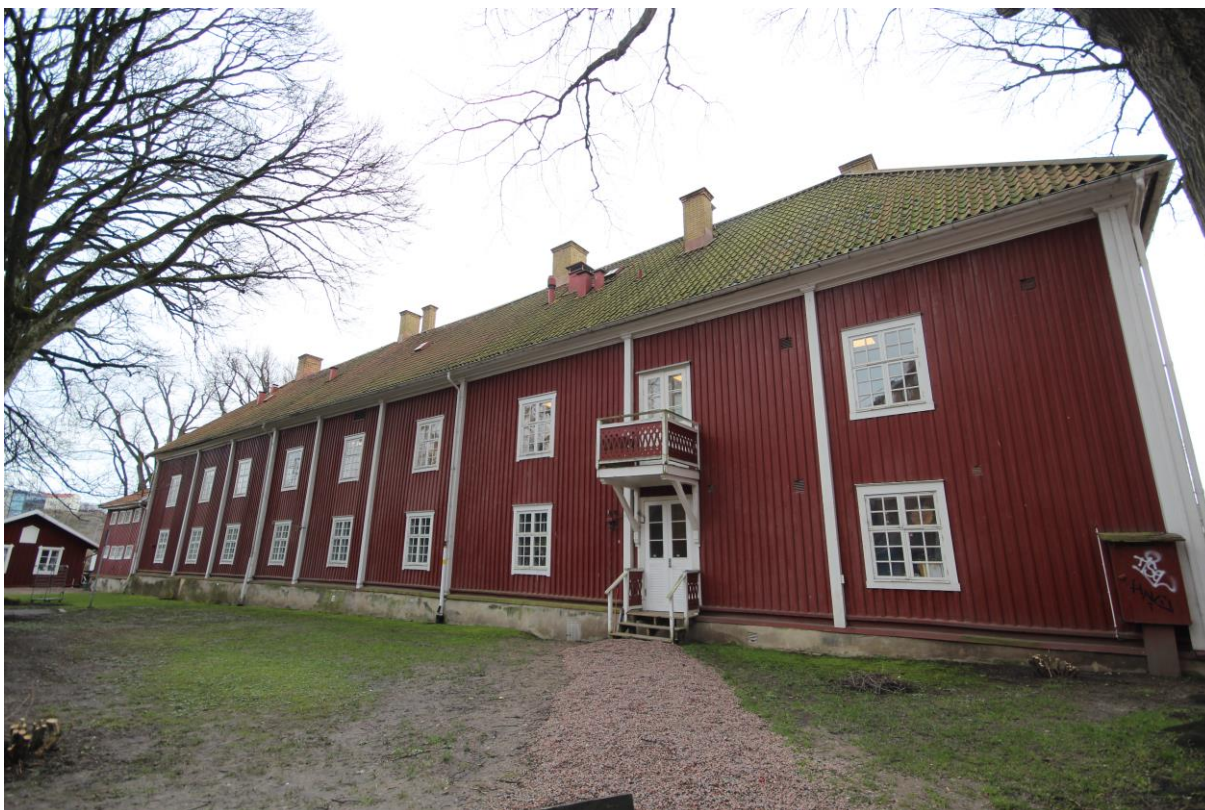
GAMLA FATTIGHUSET, NUVARANDE MARIAGÅRDEN – DEL AV FASAD MOT NORR.
