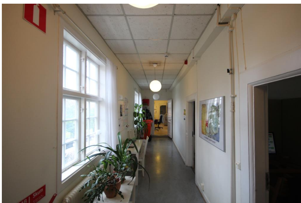
STORA DELAR AV ORIGINALSTRUKTUREN FINNS BEVARAD, BLAND ANNAT I FORM AV KORRIDORSSYSTEMET.
