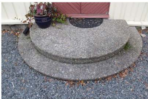
Entrétrappa av betongelement med frilagd sten.
