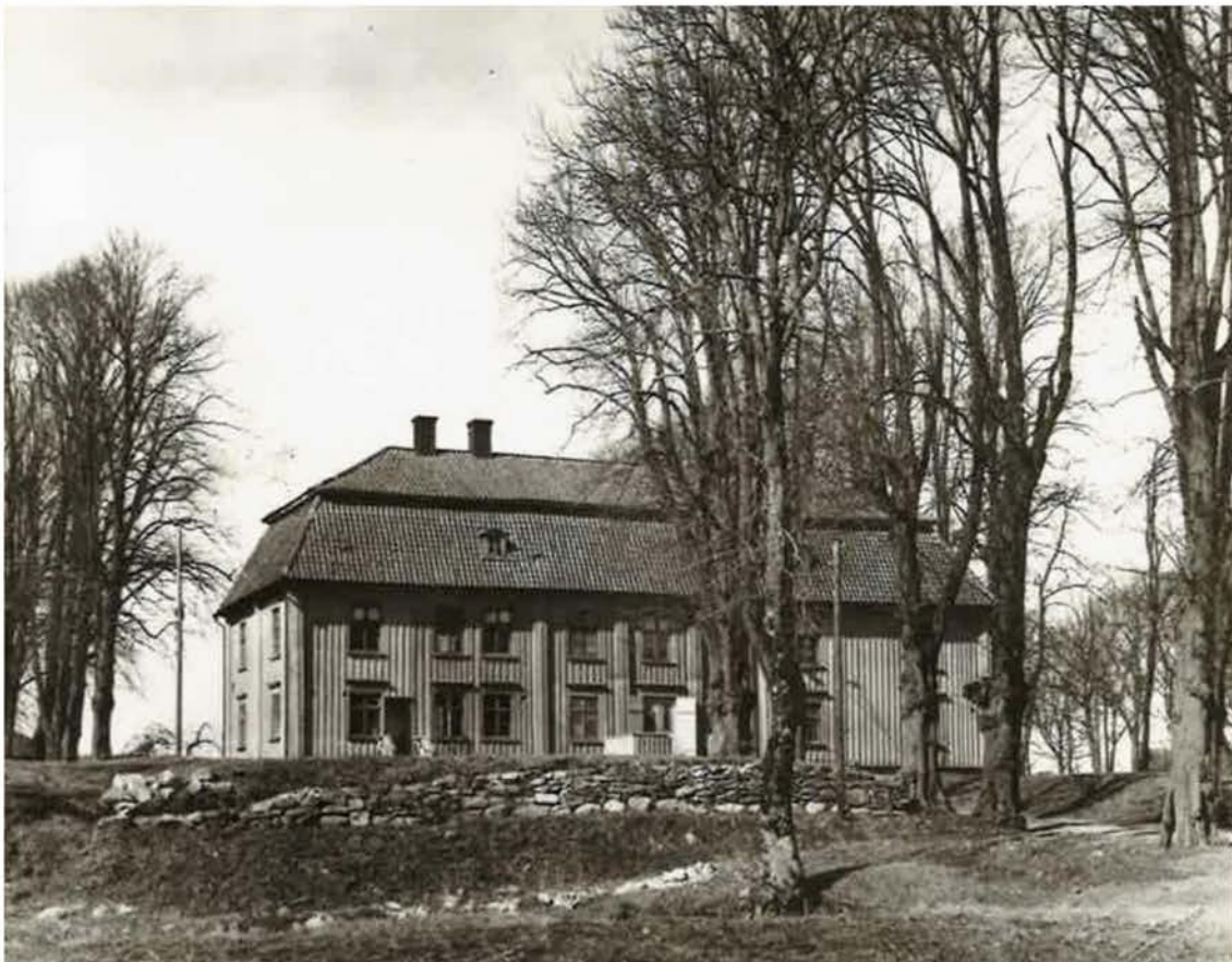
Fasad mot öster 1923. Stödmurarna mot allén syns tydligt här. Omgivningarna hölls fortfarande fria från sly. (Foto Karnell, Stadsmuseet ämnesarkivet)
