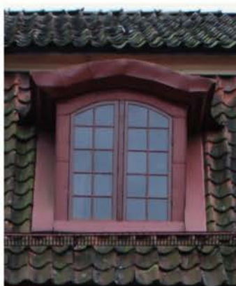
Vindskupa ovan huvudentré. Spröjsat fönster, enkelglas.
