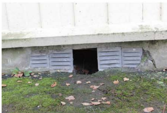
Öppning i sockel.
