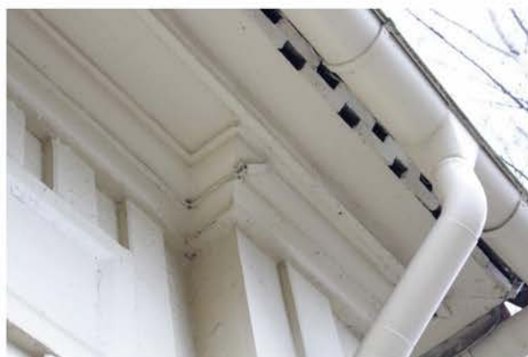
Knutlåda med profilerat kapital mot takfoten.
