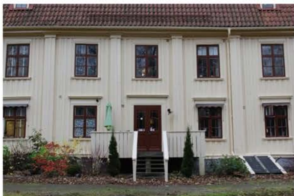
Fasad mot öster. Knutlådorna bildar ett tempelgavelmotiv, som pilastrar i fasaden.
