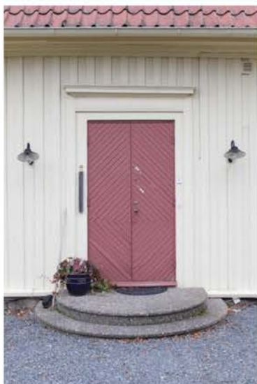
Pardörr klädd med diagonalställd smal panel – utbytt i senare tid.
