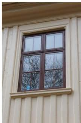
Utbytt fönster mot norr.
