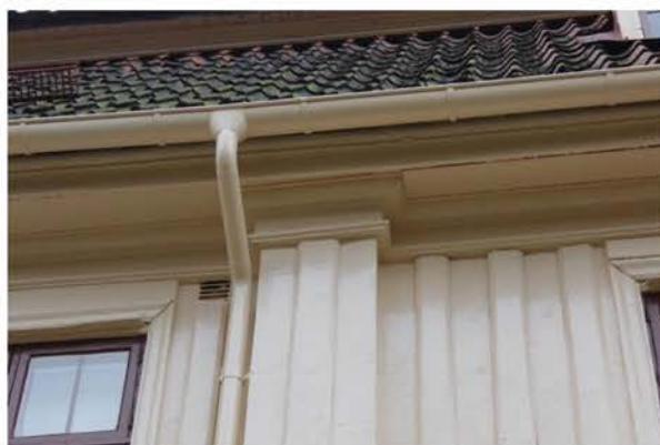
Knutlåda med profilerat kapital mot takfoten.
