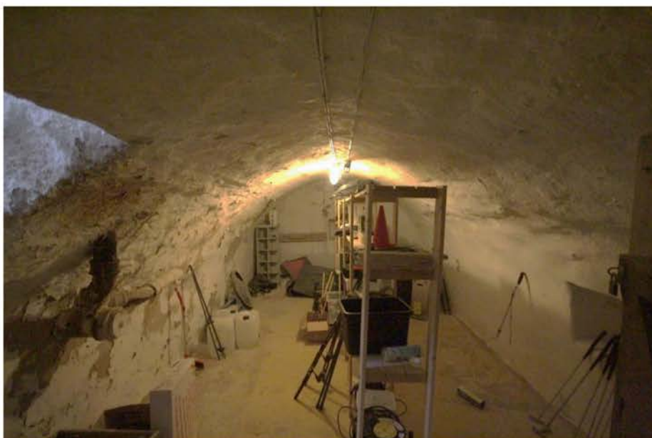
Källare med putsat välv tak.
