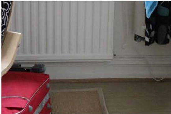
Sockel äldre/original utmed yttervägg.
