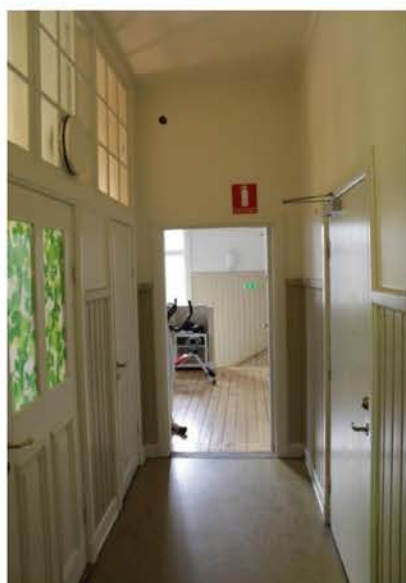
Korridor med bröstpaneler och överljus mot duschrum från omkring 1916/1918.
