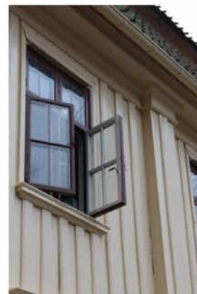
Innerbåge med spröjs i korsform och spanjolett.
