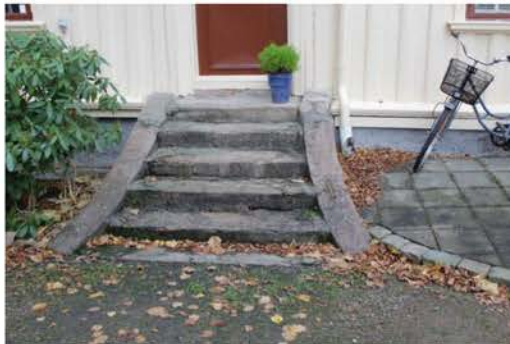
Trappa i kalksten vid sidoentré.
