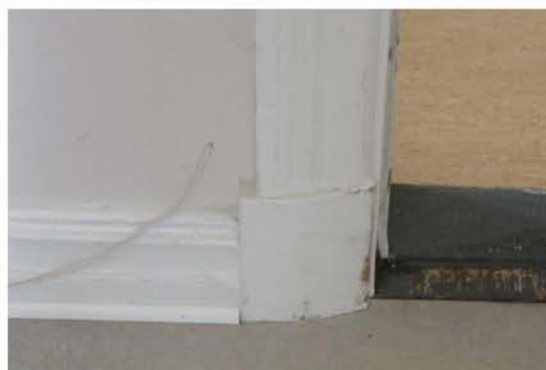
Sannolikt äldre sockel och foder som flyttats då den nya väggen byggdes.
