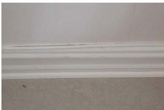
Äldre sockel utmed yttervägg.
