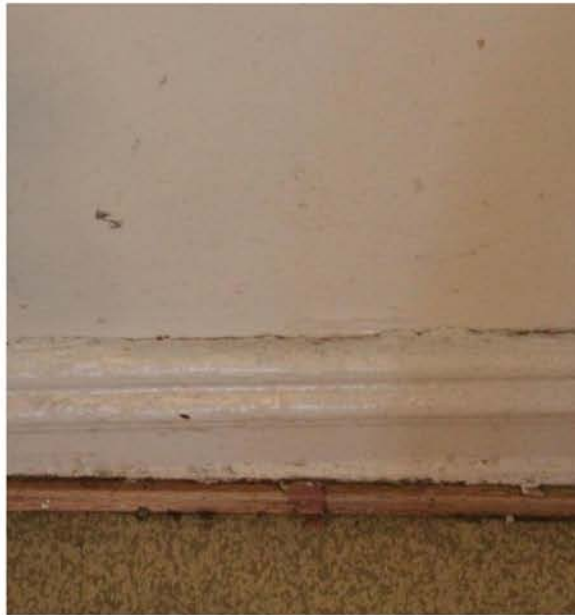
Äldre sockel utmed originalvägg i fotorum (numera telefonrum).
