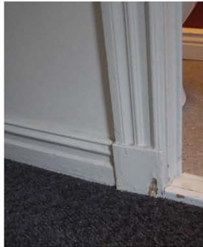
Sockel och foder i entré – omkring 1916/18.
