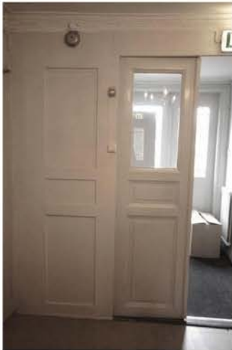
Pardörr mot entré – troligen sent 1800-tal.
