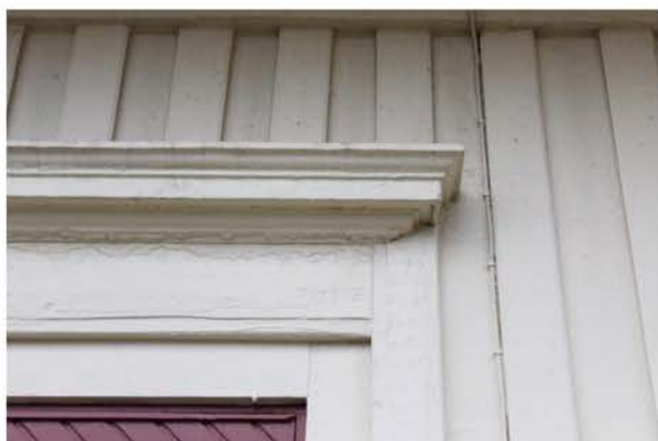
Profilerad dörromfattning – original.
