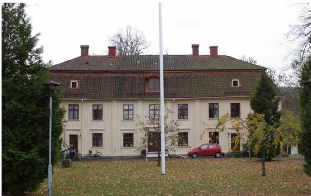
Fasad mot väster.
