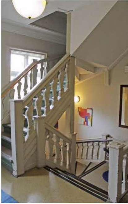
Trappan leder även upp till vinden.
