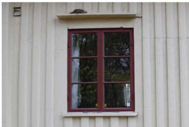
Spröjsade kopplade tvåluftsfönster. Samtliga är utbytta.
