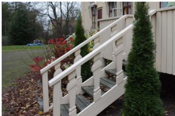
Balusterdockor av samma modell som den invändiga huvudtrappan.
