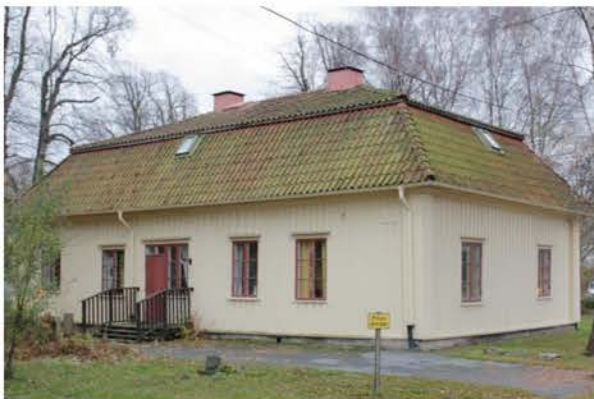
Säteritak klätt med enkupigt lertegel. Takfall mot norr
