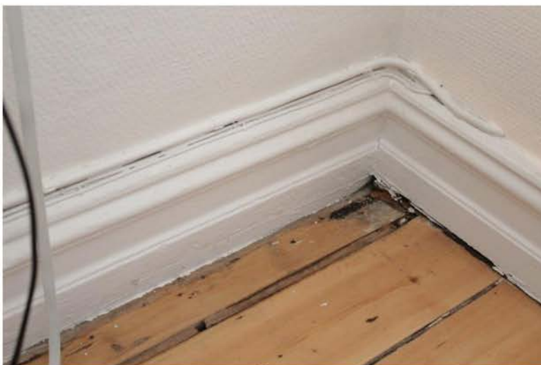
Äldre foder vid originalvägg i matsalen.
