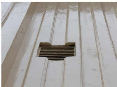
Ventilationsgaller i plåt förekommer.
