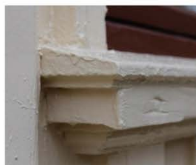
Detalj av profilerad vattbräda under fönster.
