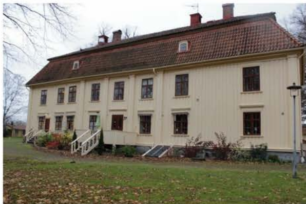
Säteritak klätt med enkupigt lertegel. Takfall mot öster.
