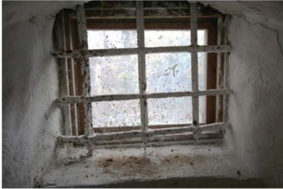
Handsmitt galler för källarfönster.
