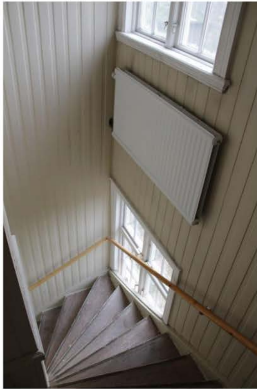
Trätrappa med linoleumklädda steg och mässingslist.
