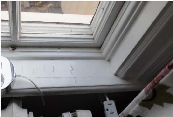
Äldre fönster och fönstersnickerier.
