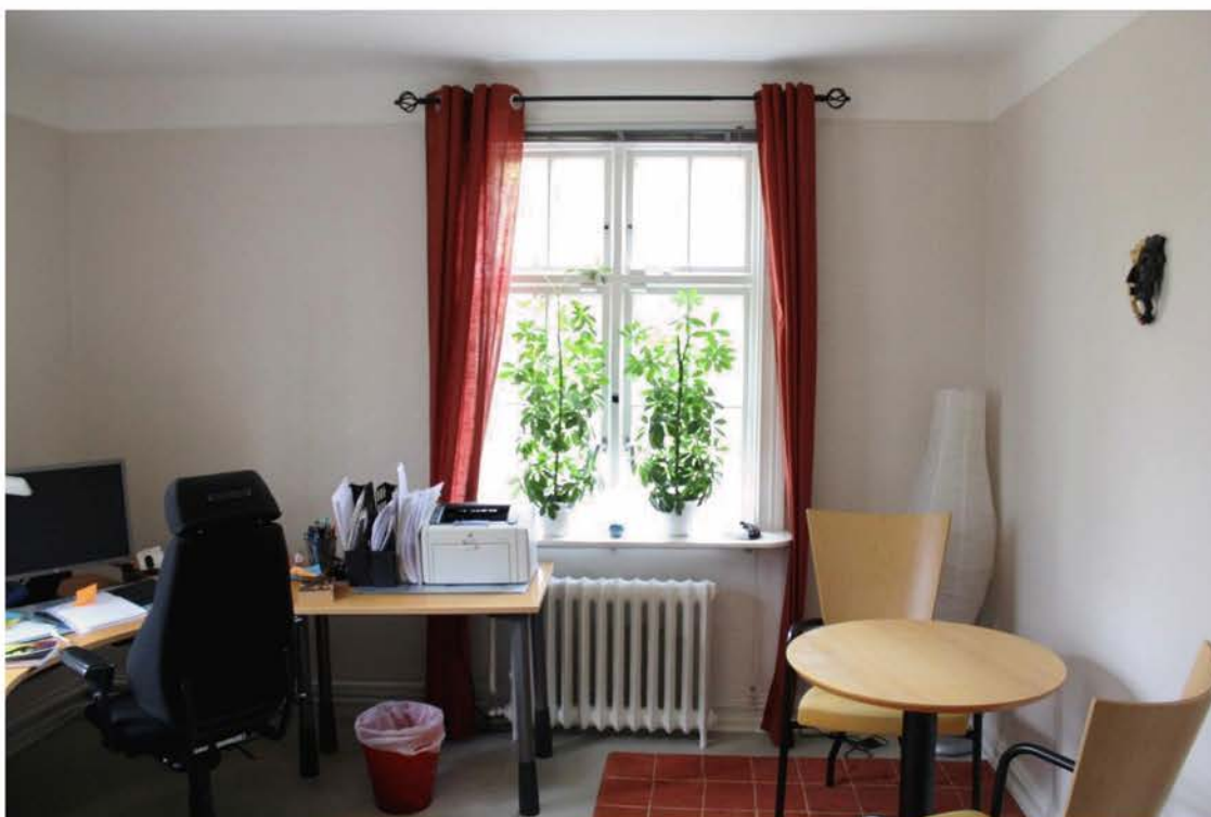
Rum som delats av till korridor och trappa.
