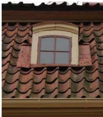
Vindskupa med spröjsat fönster, enkelglas.
