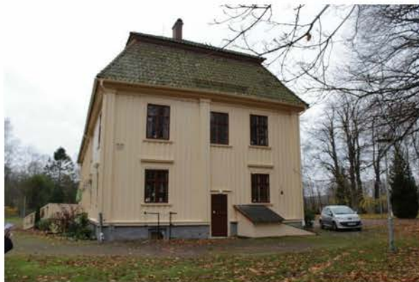
Takfall mot norr med påväxt av alger.
