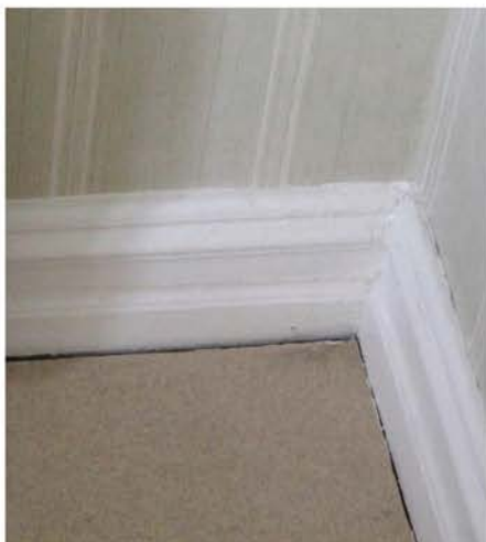
Äldre foder vid originalvägg i matsalen.
