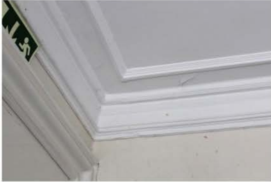
Dragen stuck original.
