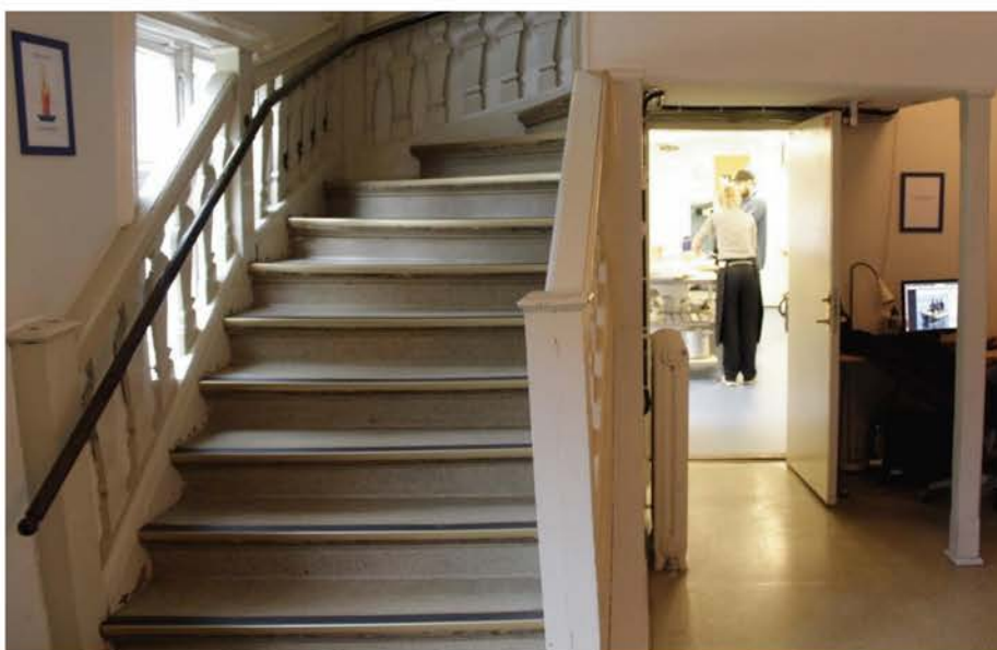
Trappa med kantiga balusterdockor sannolikt original.
