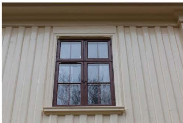
Korpostfönster med liggande spröjs i ytterbåge. Merparten av fönstren är äldre – dock ej original.
