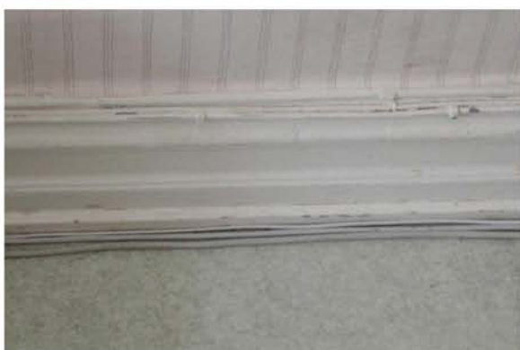
Sockel utmed originalvägg.
