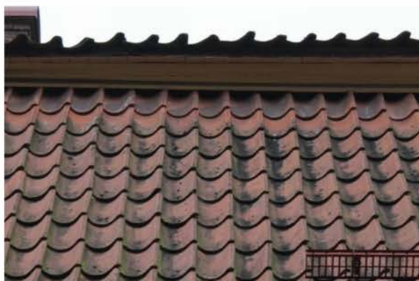
I brottet mot övre takfallet finns en gesims målad lika fasaden.
