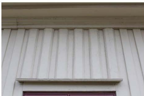
Profilerad lockläktpanel lika mangårdsbyggnaden - original.
