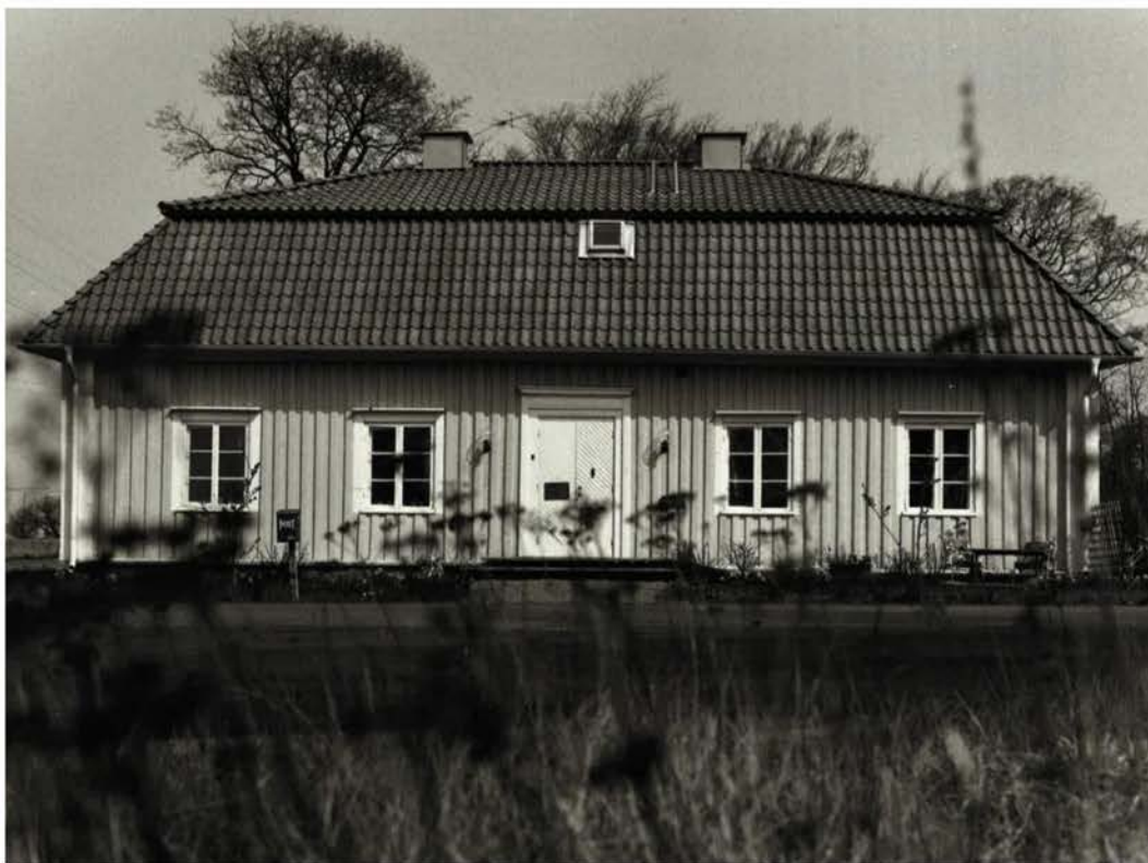
Norra flygeln 1975. Exteriören har renoverats – dörr, fönster och takfönster bytts ut, skorstenar bytts mot hugar i plåt. (Stadsmuseet ämnesarkivet)
