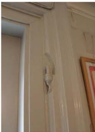
Originalfoder och gångjärn vid entrédörr mot öster.
