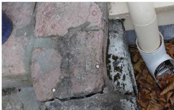
Stuprören är anslutna till dagvattensystem.
