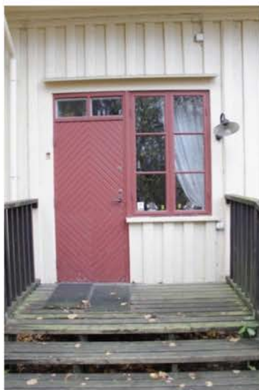
Enkeldörr klädd med diagonalställd smal panel – utbytt.
