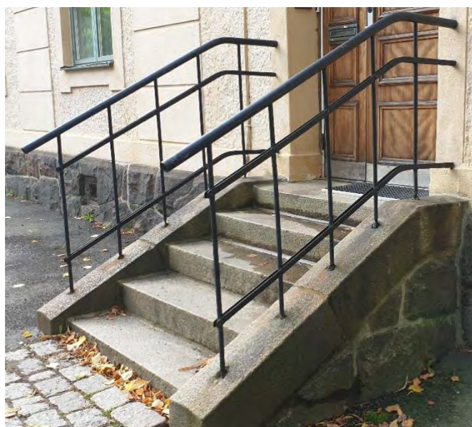
TRAPPORNA VID VAKTMÄSTARBOSTADEN (BYGGNAD 1) SAMT DIREKTÖRSVILLANS NORRA ENTRÉ (BYGGNAD 2) HAR SMIDESRÄCKEN MED ENKLARE UTFÖRANDE.
