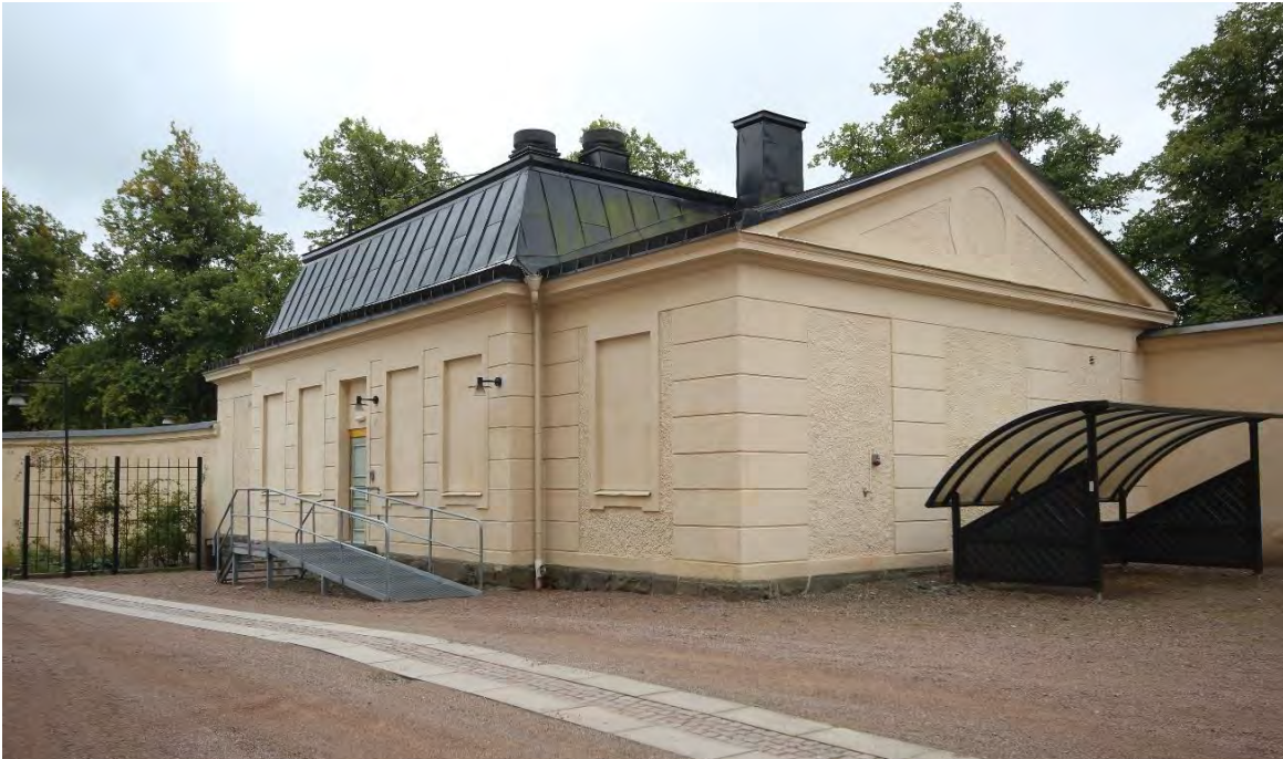
URSPRUNGLIG DOMSTOLSBYGGNAD (BYGGNAD 15) ANVÄNDES SENARE SOM DE INTAGNAS FRITIDSLOKAL. NUMERA UNGDOMSVERKSAMHETENS LOKAL.
