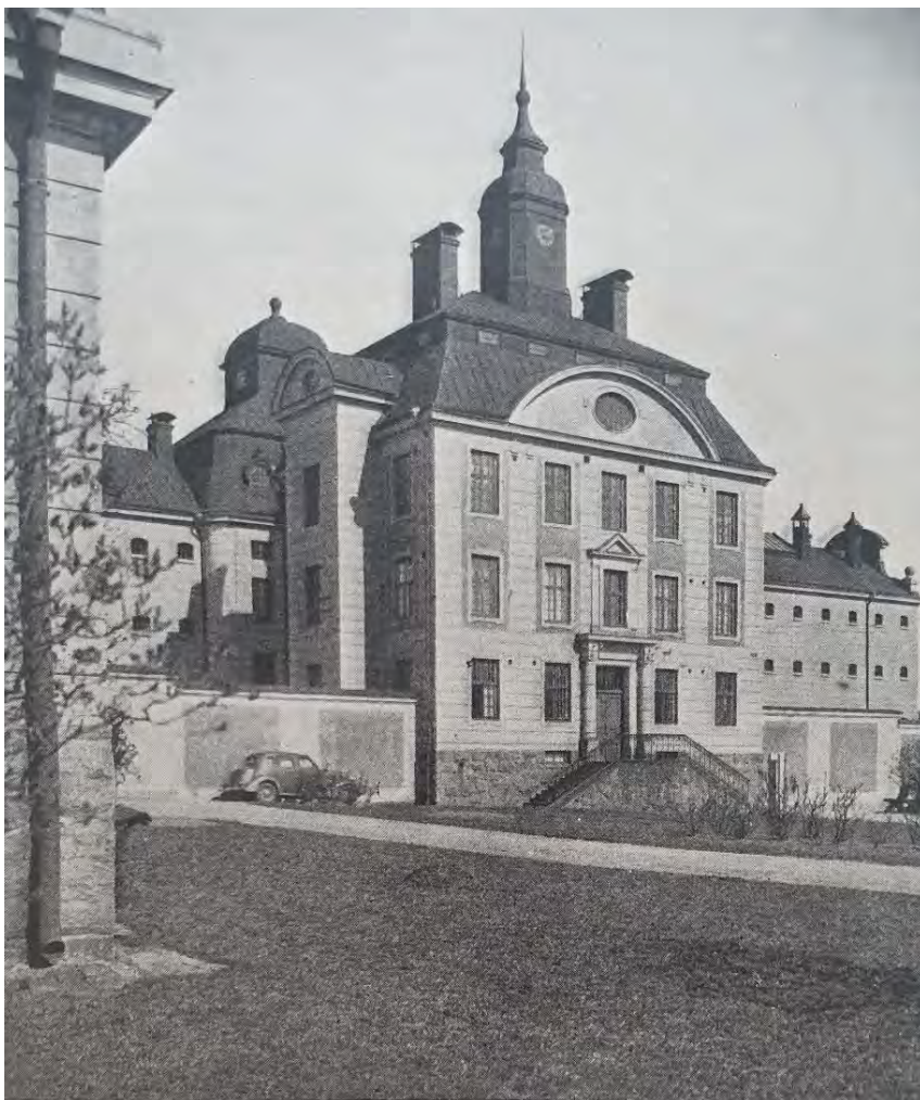
ENTRÉBYGGNADEN PÅ HÄRLANDA. KÄLLA: JOHNSON, 1936
