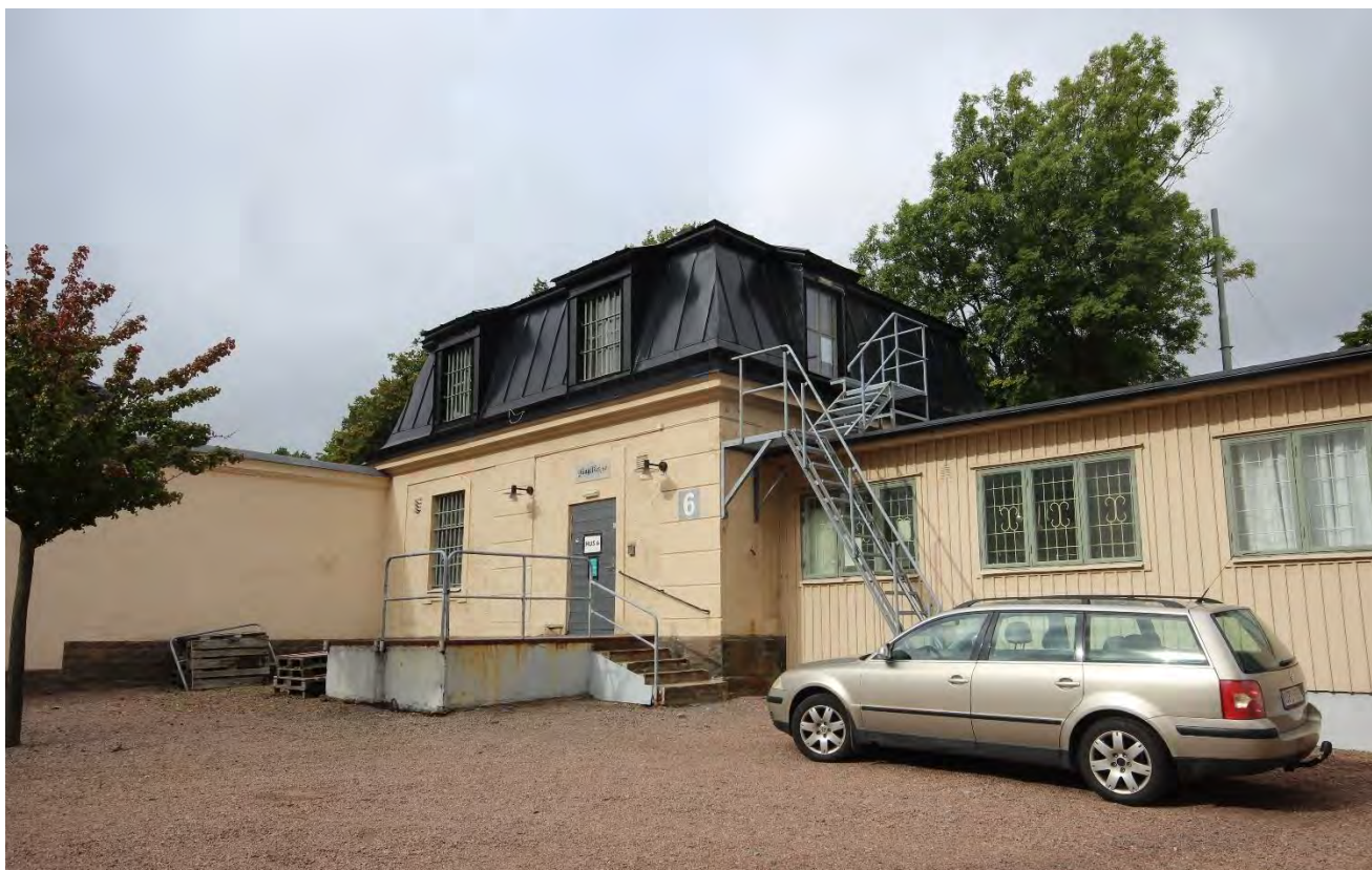
URSPRUNLIG TVÄTTSTUGEBYGGNAD (BYGGNAD 6) I FÄNGELSEMURENS NORDVÄSTRA HÖRN. SENARE INRYMDES HÄR ELVERKSTAD. NUMERA HUSERAR BYGGNADEN DEL AV UNGDOMSVERKSAMHETEN FÄNGELSET. VERKSTADSBYGGNADEN TILL HÖGER I BILD UPPFÖRDES 1959.
