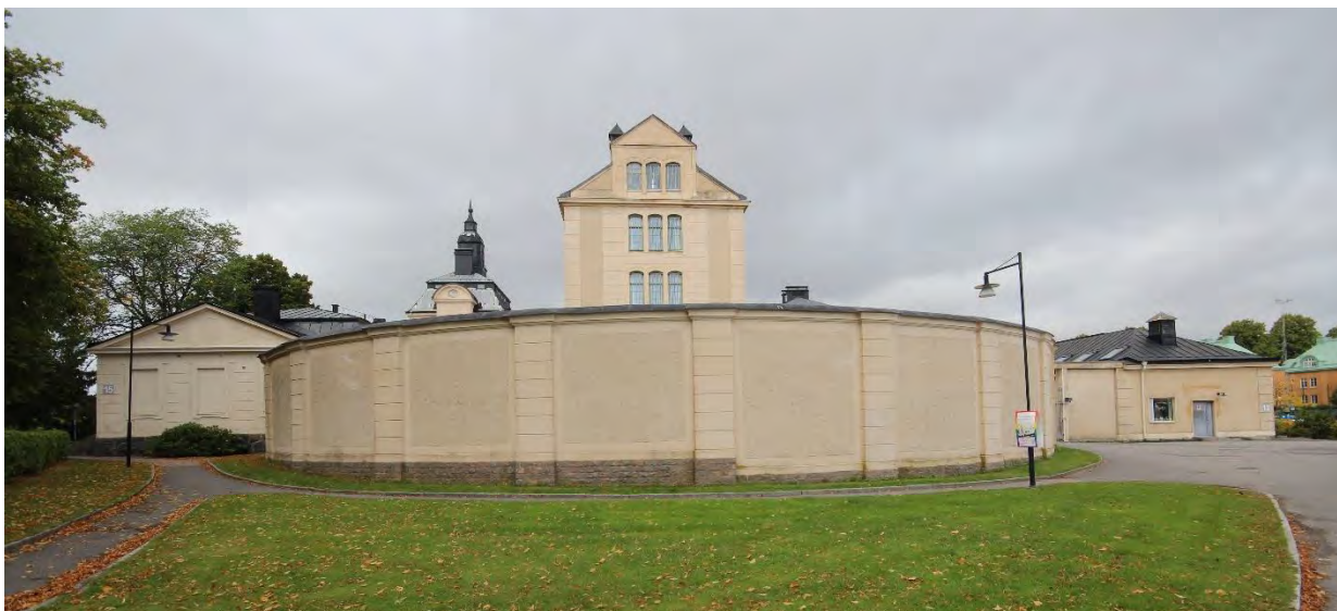
DEN VÄLVIDA FÄNGELSEMUREN ÄR ETT SPÅR AV OM DEN SÖDRA PROMENADGÅNGEN
