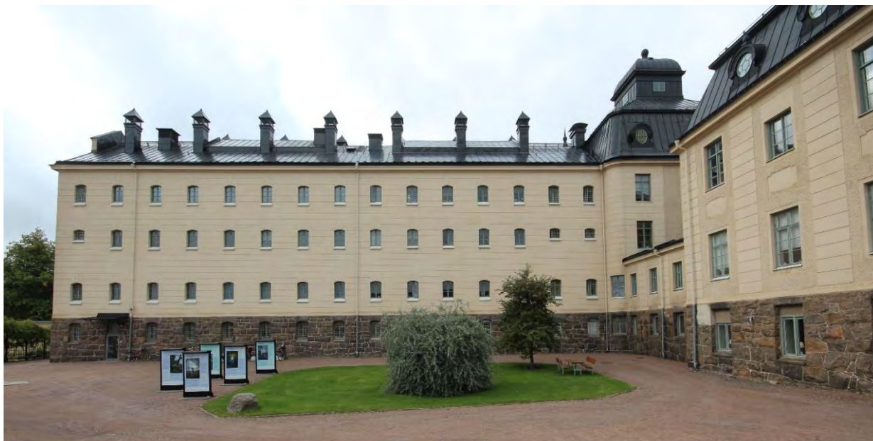
SÖDRA CELLÄNGANS ÖSTRA FASAD, MED TILL STÖRRE DELEN OMBYGGDA, FÖRSTORADE, CELLFÖNSTER. EKONOMIBYGGNAD (BYGGNAD 5) TILL HÖGER I BILD.
