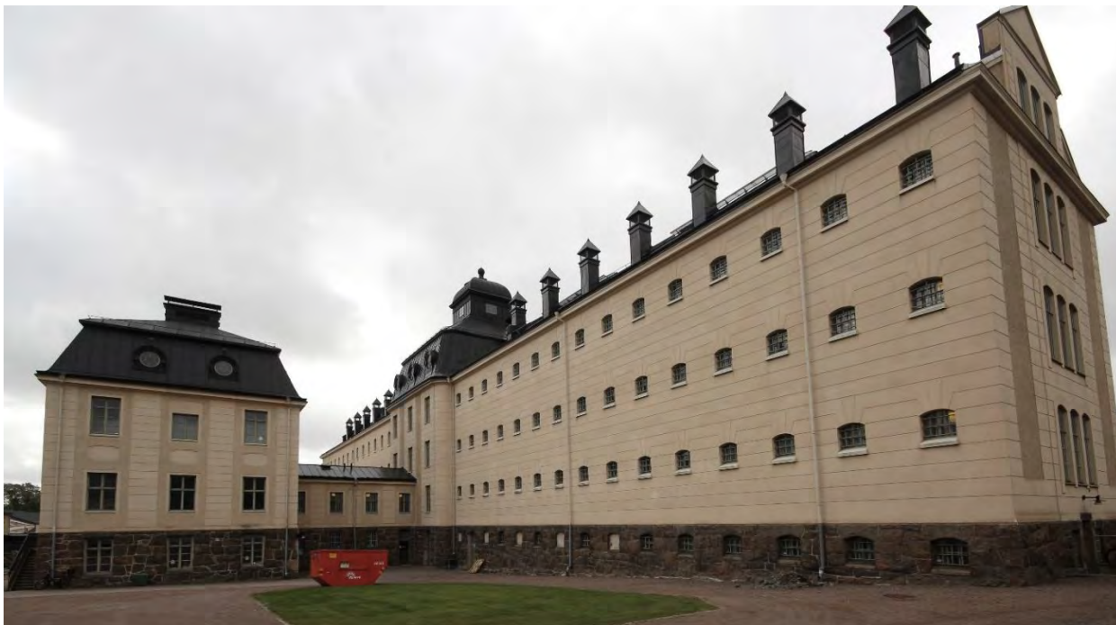
CELLBYGGNADENS (BY 4) ÖSTRA FASAD, MED BEVARADE CELLFÖNSTER. EKONOMIBYGGNAD (BYGGNAD 5) TILL VÄNSTER I BILD.
