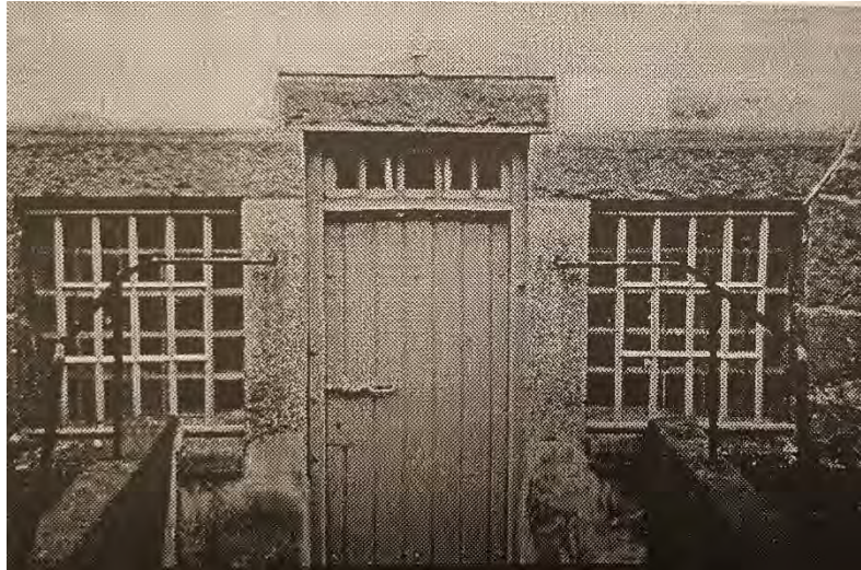
VID INVENTERING 1999 FANNS DEN URSPRUNGLIGA DÖRREN MED ÖVERLJUS KVAR VID NORRA GAVELN I SOCKELVÅNINGEN BYGGNAD 4. KÄLLA: JOHANSSON, 1999
