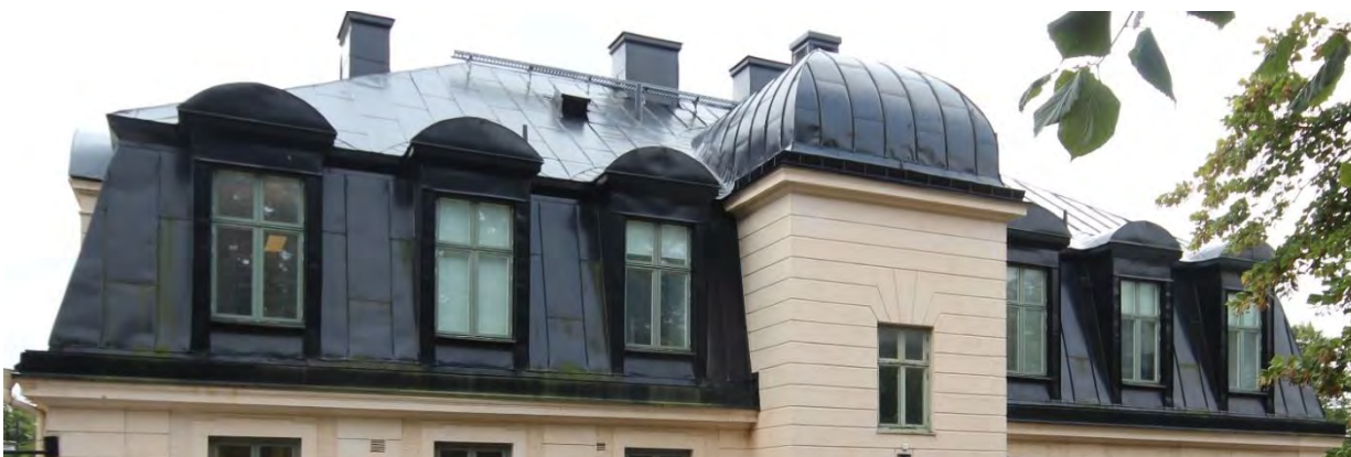
VÅLVDA TAKKUPOR SAMT HUV ÖVER TRAPPHUSET PÅ DIREKTÖRSVILLAN (BYGGNAD 2)
