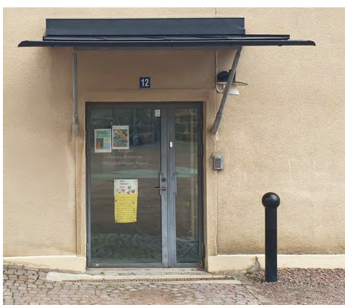
UTBYTT GLASAD STÅLDÖRR PÅ BYGGNAD 12
