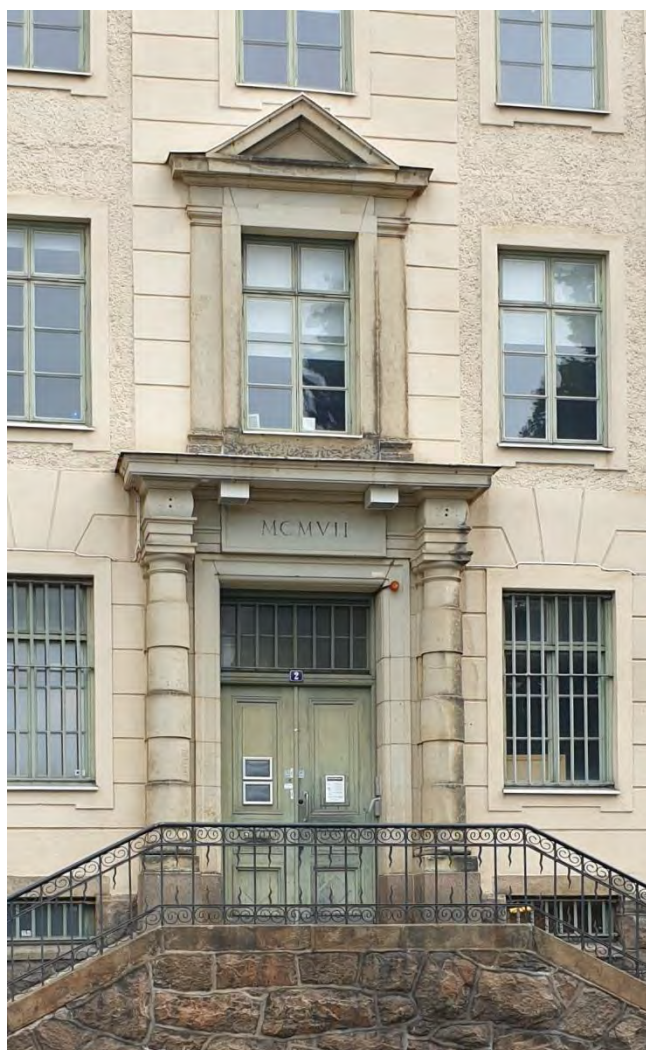
ENTRÉBYGGNADEN ÄR FÖRSEDD MED KALKSTENSportal MED KOLONNER OCH ARKIVTRAV. OMFATTNINGEN PÅ FÖNSTRET OVANFÖR FÖRSTÄRKER MONUMENTALITETEN.
