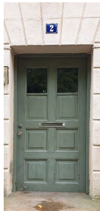
URSPRUNLIG/ÄLDRE FYLLNINGSDÖRR I ENKLARE UTFÖRANDE VID DIREKTÖRSVILLANS NORRA ENTRÉ
