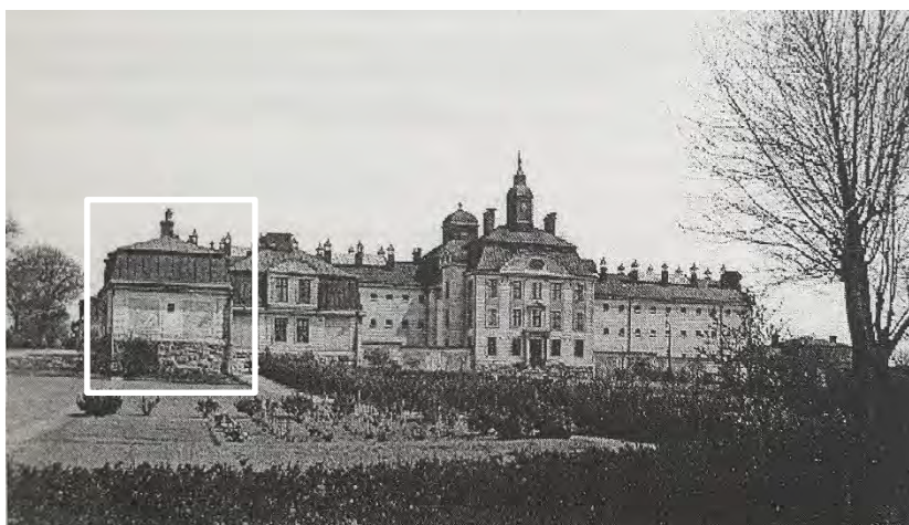
VY FRÅN VÄSTER MED VAKTMÄSTARBOSTADEN INNAN TILLBYGGNADEN, LÄNGST TILL VÄNSTER. KÄLLA: JOHANSSON, 1999
