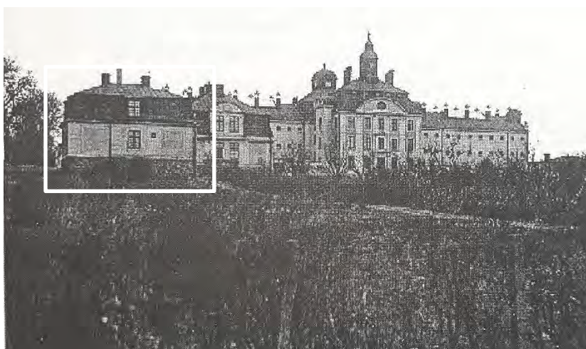
VY FRÅN VÄSTER MED VAKTMÄSTARBOSTADEN EFTER TILLBYGGNADEN, LÄNGST TILL VÄNSTER. FOTOGRAFI FRÅN 1934 KÄLLA: JOHANSSON, 1999
