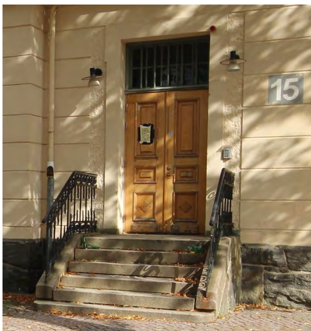
ENTRÉN TILL DOMSTOLSBYGGNADEN (BYGGNAD 15) HAR EN SENARE PARDÖRR UTFORAMDE EFTER URSPRUNGLIG FÖRLAGA SAMT EN GRANITTRAPPA MED DEKORATIVT SMIDESRÄCKE I ORIGINALUTFÖRANDE.
