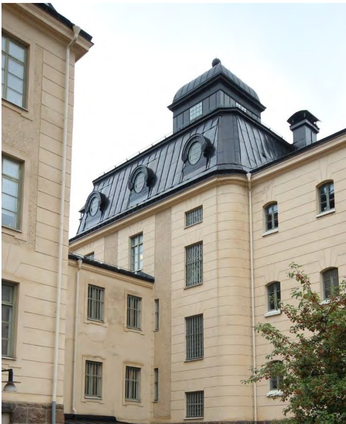
MITTKROPPEN PÅ CELLÄNGAN (BYGGNAD 4) HAR FÄLT AV SPRITPUTS SAMT FÖNSTEROMFÄTTNINGAR OCH RUNDADA HÖRNKEDJOR MED BANDRUSTIK. CELLFLYGLARNA (DEN SÖDRA TILL HÖGER I BILD) HAR FASADER MED ENBART BANDRUSTIK.
