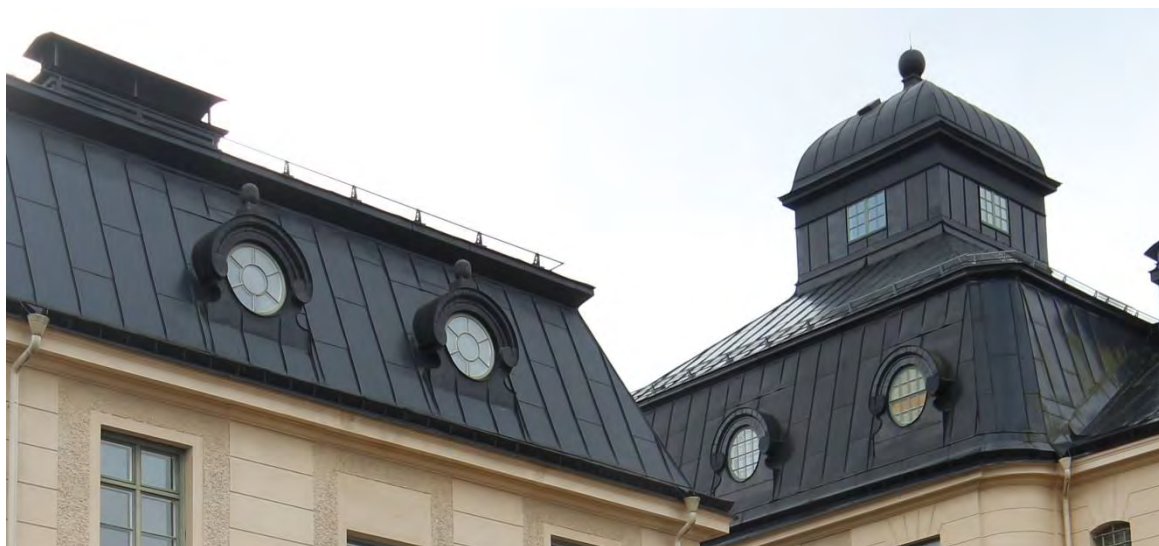
SMÅSPRÖJSADE FÖNSTER I TAKKUPOR OCH TAKHUV (BYGGNAD 5 OCH 4)
