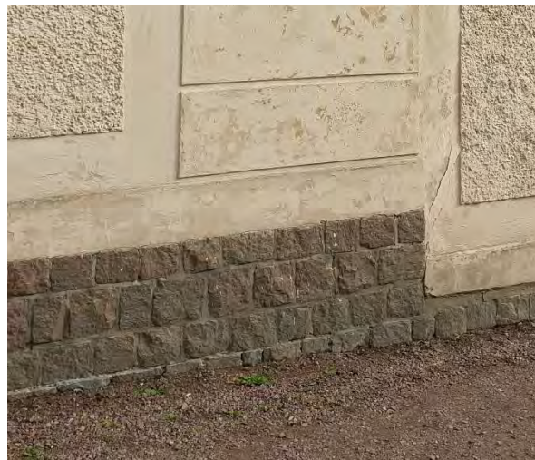
MURENS SOCKEL ÄR UTFÖRD MED KVADRATISK GRANIT I RELATIVT SMÅ MÅTT.
