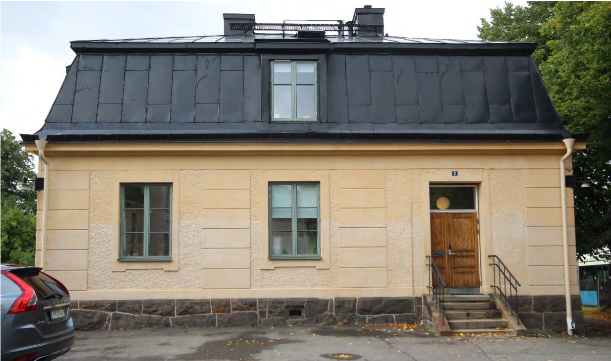
VAKTMÄSTARBOSTADEN (BYGGNAD 1) VISAR PÅ ETT TYPISKT UTFÖRANDE MED SPRITPUTSADE FÄLT INOM BANDRUSTICERADE LISENER OCH HÖRNKEDJOR. OMFÄTTNINGAR KRING FÖNSTER OCH DÖRRAR ÄR SLÅTA
