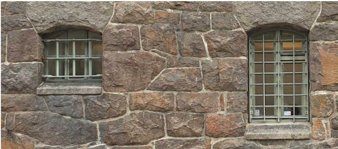
T.V. URSPRUNGLIGT CELLFÖNSTER I JÄRN MED UTVÄNDIGT GALLER I ORIGINALUTFÖRANDE. T.H. FÖRSTORAT CELLFÖNSTER MED TRELUFFSFÖNSTER I TRÄ SAMT UTVÄNDIGT GALLER (1940-TAL)
