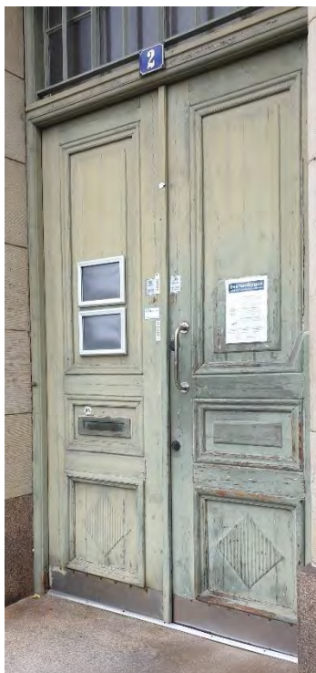
URSPRUNGLIG PARDÖRR VID ENTRÉBYGGNADEN.
