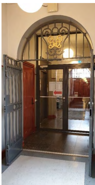
BEVARADE SMIDESGRINDAR I ENTRÉBYGGNADEN (BYGGNAD 3)
