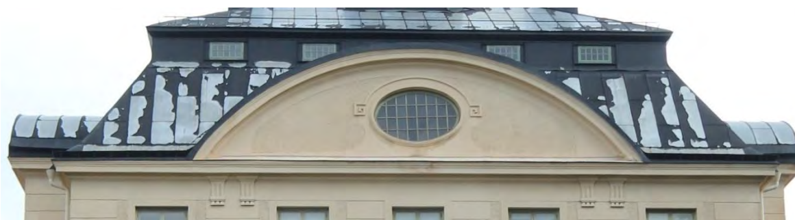
OVALT SMÅSPRÖJSAT FÖNSTER I FRONTOIN VID HUVUDFASADEN PÅ ENTREBYGGNADEN (BYGGNAD 3)
