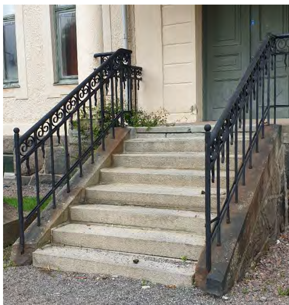
DIREKTÖRSVILLAN (BYGGNAD 1) SAMT ENTRÉBYGGNADEN, EKONOMIBYGGNADEN OCH DOMSTOLSBYGGNADEN (3,5,15) HAR LIKADANA DEKORATIVA SMIDESRÄCKEN I ORIGINALUTFÖRANDE.
