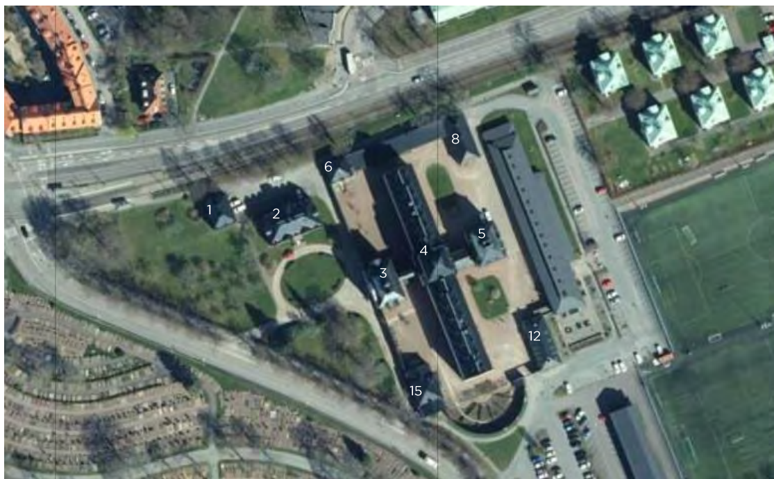
FLYGFOTO ÖVER ANLÄGGNINGEN. ENTRÉPARKEN TILL VÄSTER MED GRUSVÄG SOM LEDER FRAM TILL ENTRÉBYGGNADEN SOM FRONTAR SJÄLVA DET MUROMGÄRDADE FÄNGELSEOMRÅDET. KÄLLA: ENIRO
