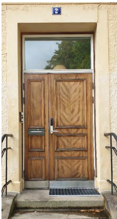
UTBYTT ENTRÉDÖRR MED ÖPPNINGSBART SIDOPARTI (BYGGNAD 1).
