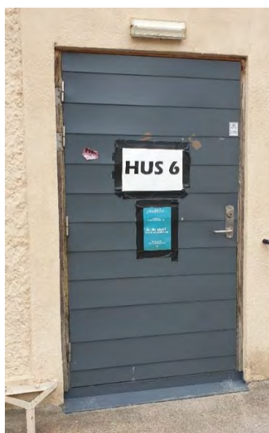
UTBYTT DÖRR PÅ BYGGNAD 6
