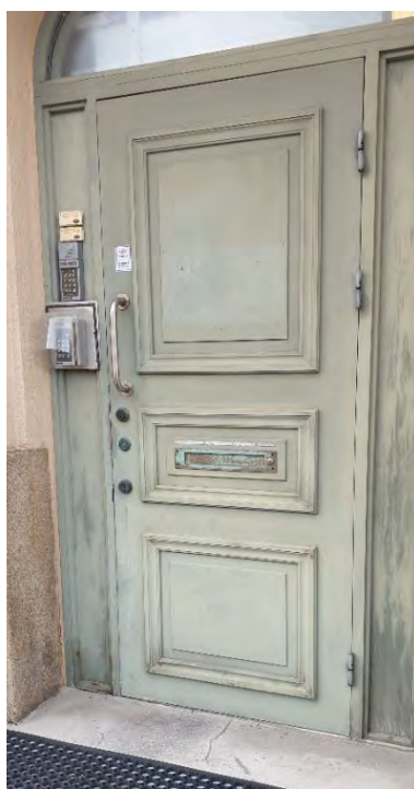
UTBYTT ENTRÉDÖRR MED IGENSATTA SIDOPARTIER (BYGGNAD 5)
