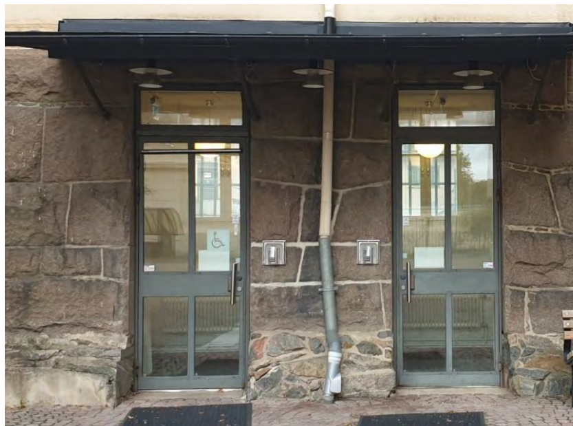
SENARE STÅLDÖRRAR I FÖRBINDELSEGÅNGENS SOCKELVÅNING, MELLAN BYGGNAD 3 OCH 4.
