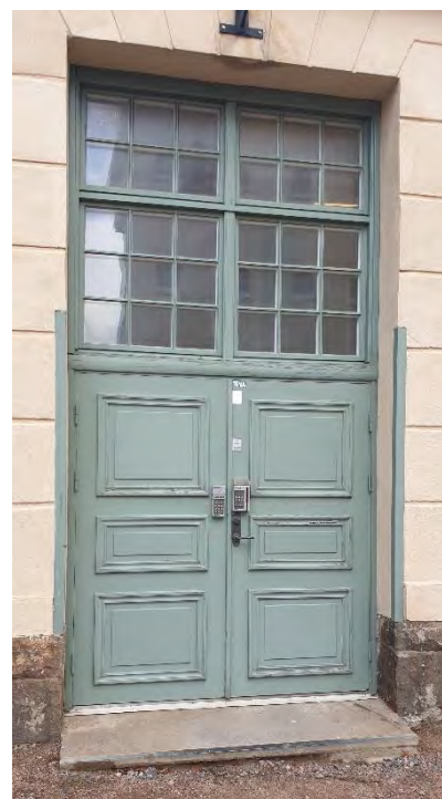
UTBYTT PARDÖRR MED SMÅSPRÖJSAT ÖVERLJUS (BYGGNAD 8)
