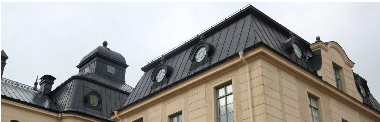
EKONOMIBYGGNAD (BYGGNAD 5) MED MANSARDTAK OCH VÅLVDA TAKKUPOR MED KULFORMADE KRÖNINGAR. ÄVEN HUVEN PÅ BYGGNAD 4 OCH TORNET PÅ BYGGNAD 3 I BAKGRUNDEN HAR KULFORMADE KRÖN.
