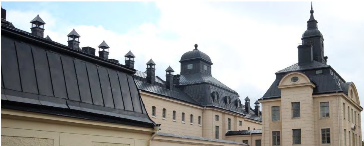
TAKLANDSKAP MED MANSARDTAK PÅ BYGGNAD 6 I FÖRGRUNDEN. BAKOM DET SKYMTAR CELLÄNGAN (BYGGNAD 4) MED VENTILER LÄNGS FLYGLARNAS TAK OCH MANSARDTAK MED HUV PÅ MITTKROPPEN. TILL HÖGER I BILD ENTRÉBYGGNADEN (BYGGNAD 3) MED SÄTERITAK OCH KLOCKTORN.
