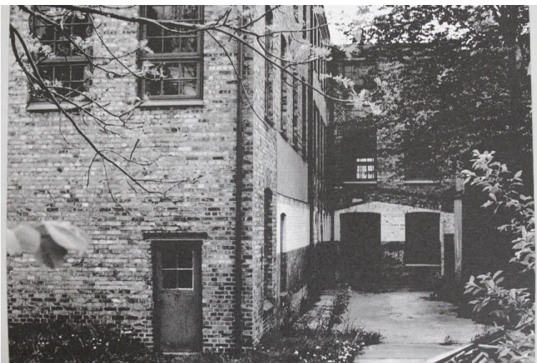
De målade väggarna i det nu rivna avsynings- och paketeringsskjulet väl synliga på norra väggens fasad samt östra fasaden vid dörren mot lagret. Fotografi taget 1984 signatur S.W. (Göteborgs Stadsmuseums arkiv)
