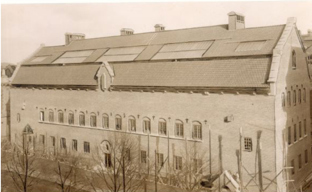
Foto från 1916 där de ursprungliga takfönstren mot Vasagatan syns (idag igensatta). Källa: GSM,
