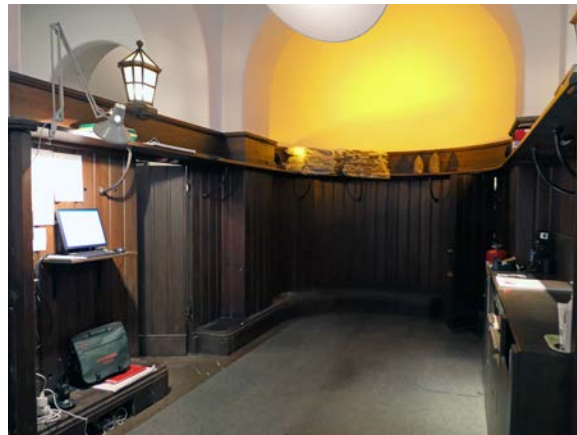
Det fd kapprummet i vestibulen med panelklädda väggar och integrerade sko- och kapphyllor samt en tapetdörr.
