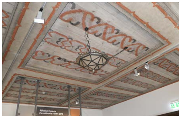
Trapphall 301 med ursprungligt kalkstengolv samt gjutet och dekormålat kassettak med ursprungliga armaturer. Mot utställningssalarna sitter ursprungliga dörrpartier som under senare tid kompletterats med moderna brandpartier.
