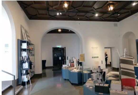
Vestibulen med ursprungligt kalkstensgolv, vitputsade väggar och kassetak av trä med ursprungliga armaturer.
