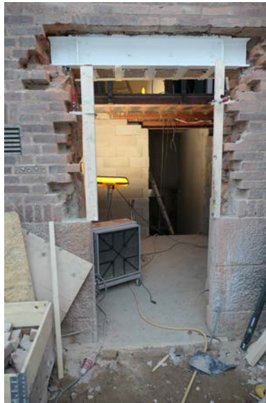
År 2019 kom ett källarfönster att göras om till dörröppning i samband med iordningställandet av en tillgänglig entré mot Vasagatan.
