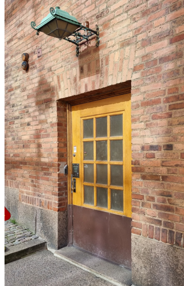
Ursprunglig entré och fasadarmatur till flygelbyggnaden.
