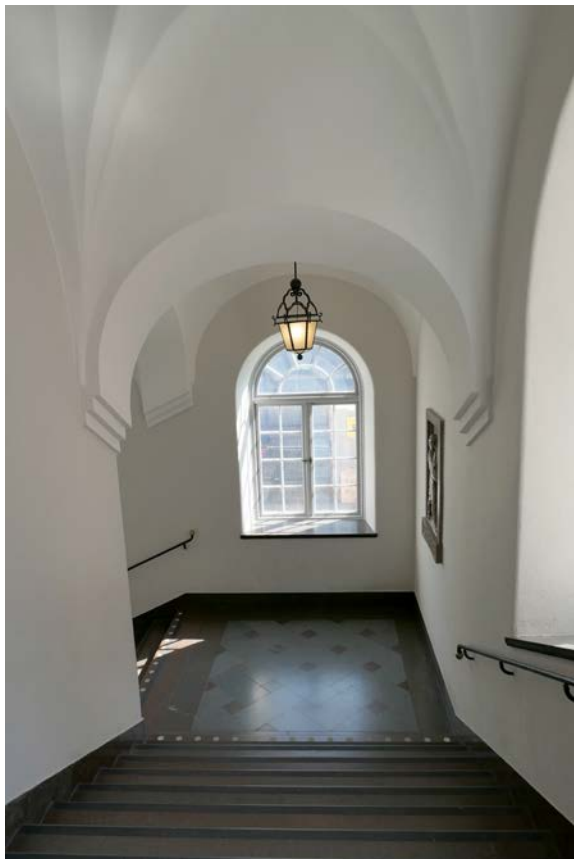
Huvudtrapphuset (trappa C) med bl a ursprunglig kalkstens-trappa, golv, ursprungliga fönster och armaturer.
