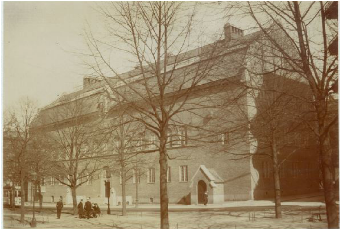
Huvudfasad mot Vasagatan år 1915. På taket anas de ursprungliga takfönstren. Källa: GSM.
