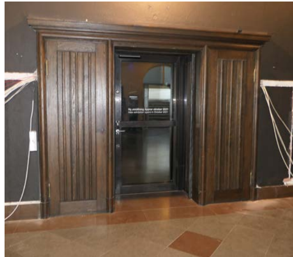
Dörrparti i trapphallen med ursprungliga tapetdörrar och skjuddörr klädd med plåt. Brandpartiet är senare tillkommet.
