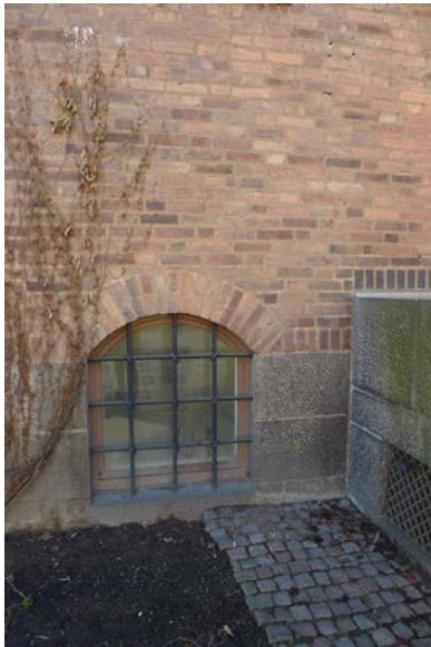
År 2019 kom ett källarfönster att göras om till dörröppning i samband med iordningställandet av en tillgänglig entré mot Vasagatan.
