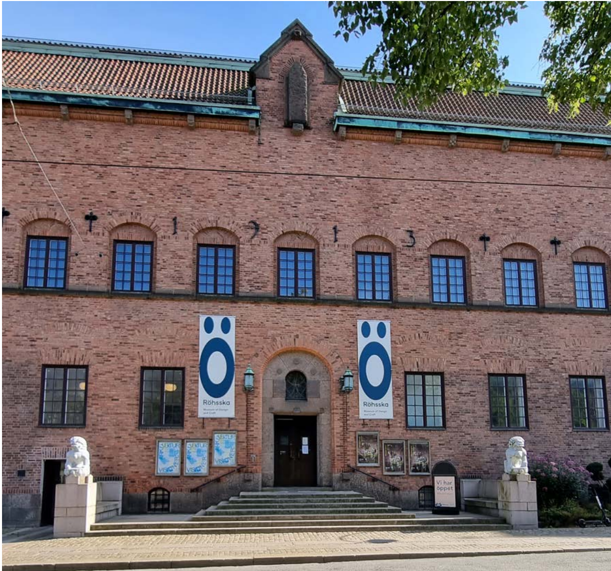
Röhsska museets huvudentré mot Vasagatan med ursprunglig fritrappa av granit, flankerad av kopior av de kinesiska hundarna. Entrén till vänster togs upp 2019 i samband med en tillgänglighetsanpassning.
