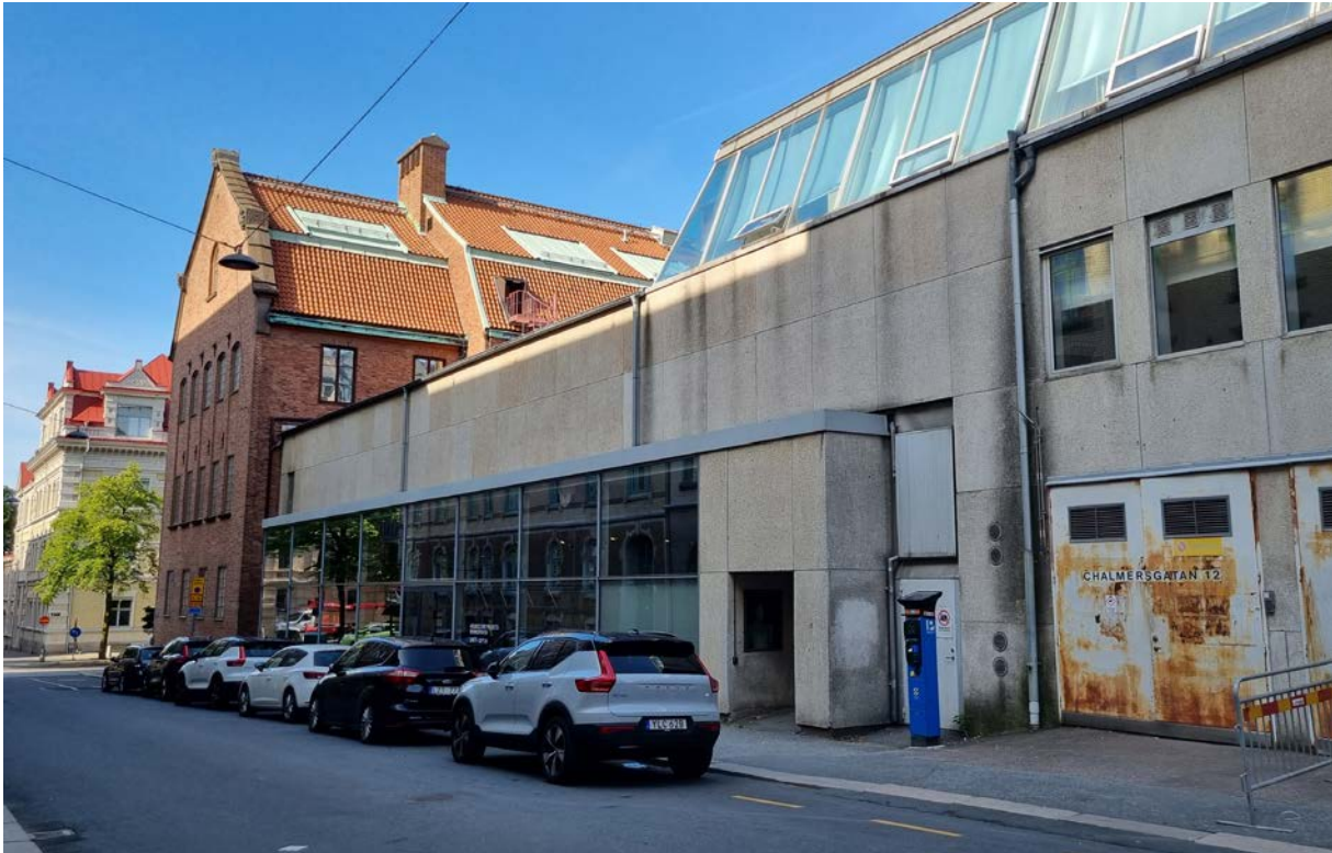
Tillbyggd flygel mot Chalmersgatan. Uppfördes ursprungligen 1937 men byggdes på- och till samt omgestaltades 1964.
