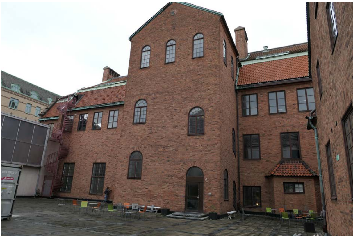
Huvudbyggnadens gårdsfasad med utskjutande trapphusbyggnad. Till vänster i bild syns en senare tillkommen utrymningstrappa som lackats i tegelröd kulör.
