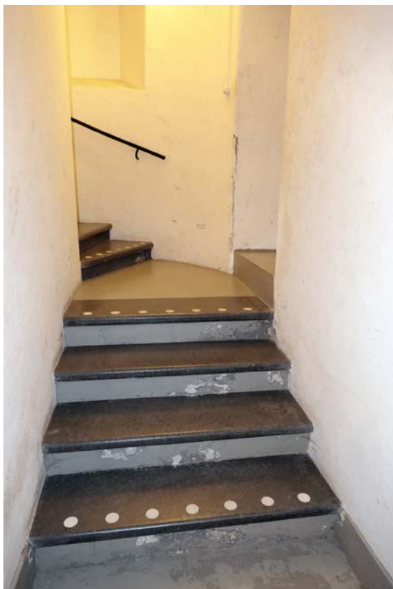
Det mindre trapphuset i flygelbyggnaden (trappa E) har en enkel karaktär men är välbevarad sedan uppförandet.
