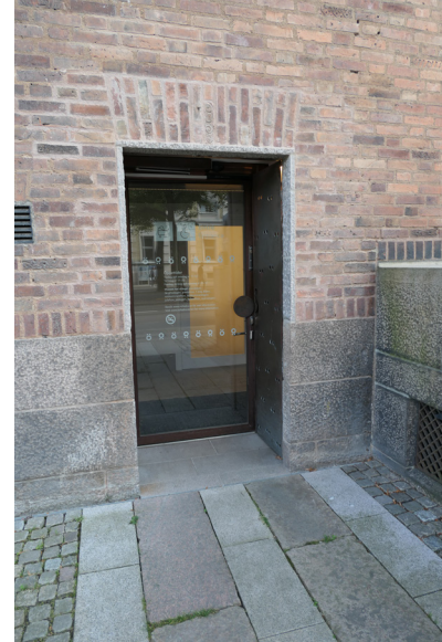
År 2019 kom ett källarfönster att göras om till dörröppning i samband med iordningställandet av en tillgänglig entré mot Vasagatan.
