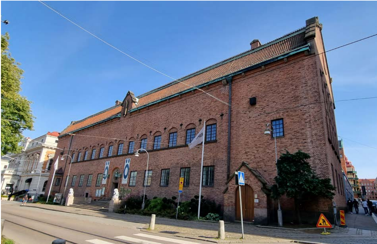
Röhsska museets huvudfasad mot Vasagatan. Andra våningen är försedd med småspröjsade fönster som markerar den innanför-liggande utställningssalen. I våning tre saknas fönster, vilket ger fasaden ett slutet och borgliknande utseende.
