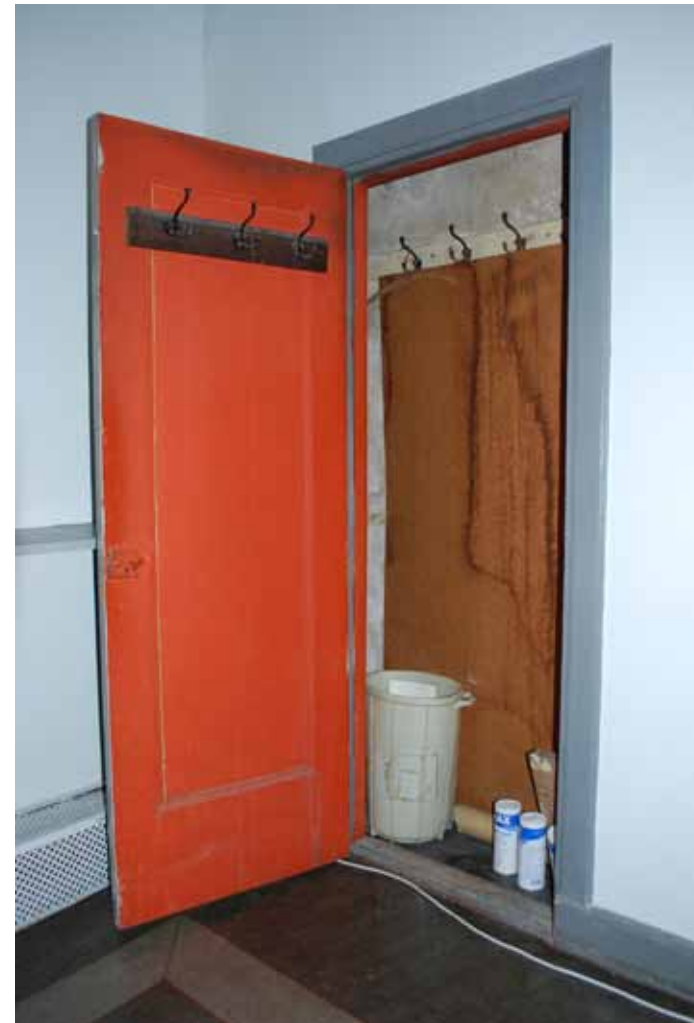
B 304. Spegeldörr med trolig originalmåleri i rött på insidan samt bevarade klädhängare.
