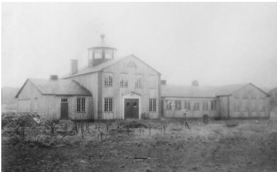
Fasad mot norr. Byggnaden är nyligen uppförd och den norra stalden i en våning saknas. (Foto ur Kvibergs kaserner s. 81).
