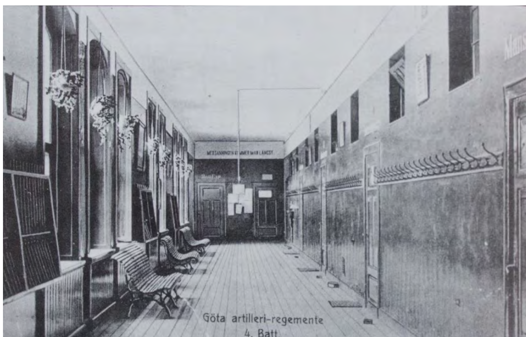
Batterikorridoren i 4:e batteriets förläggning. Fotografi från 1913. (Kvibergs kaserner, 1994)
