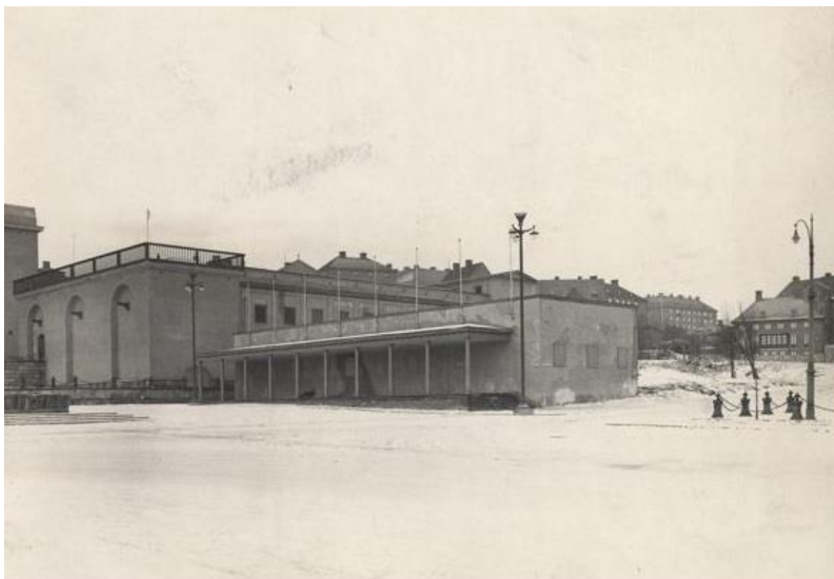
KONSTHALLEN 1931 MED TILLFÄLLIG ADMINISTRATIV BYGGNAD FÖR JUBILEUMSUTSTÄLLNINGEN NÄRMAST I BILD. SKULPTURERNA PÅ KONSOLERNA ÄR NU BORTA. BAKOM HALLEN SKYMTAR ÄVEN DEN BYGGNAD SOM REVS I MITTEN AV 1980-TALET. (GÖTEBORGS STADSMUSEUM)
