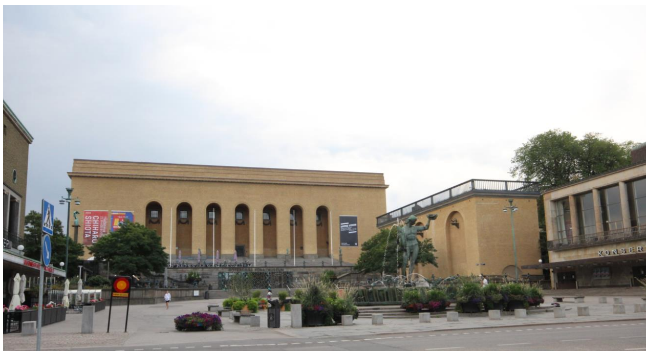
KONSTHALLEN INGÅR SOM EN AV MONUMENTALBYGGNADERNA VID GÖTAPLATSEN.
