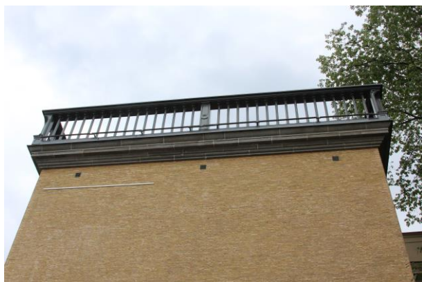
FASADEN AVSLUTAS UPPÅT MED EN KRAFTIG TAKFOT I GNEJS OCH EN KARAKTÄRSSKAPANDE BALUSTRAD I GJUTJÄRN.
