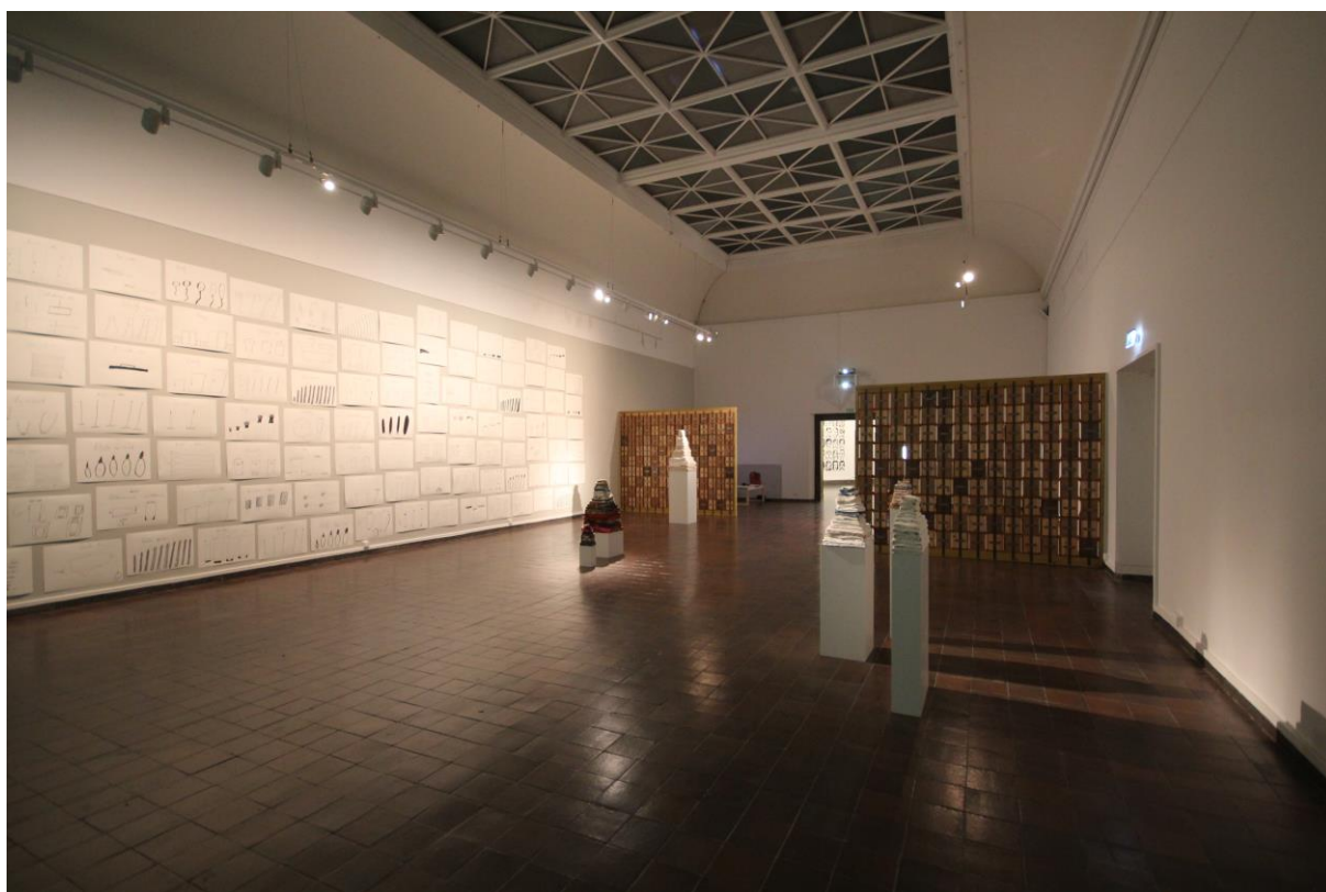
EN AV UTSÄLLNINGSHALLARNA MED KVADRATISKT TEGELGOLV OCH TEGELSOCKEL, VÄLVT TAK OCH REKTANGULÄR LANTERNIN MED SPRÖJS I GJUTJÄRN.
