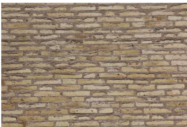
FASADER AV GULT, HANDSLAGET TEGEL.
