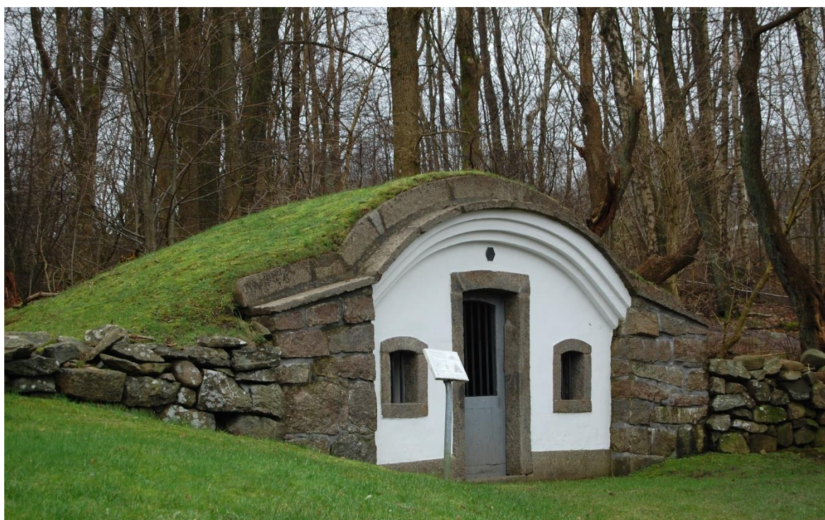
2. Foto på källhusets fasad.
