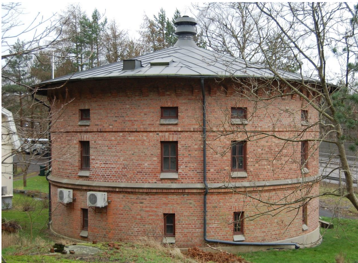
13. Foto på reservoaren.
