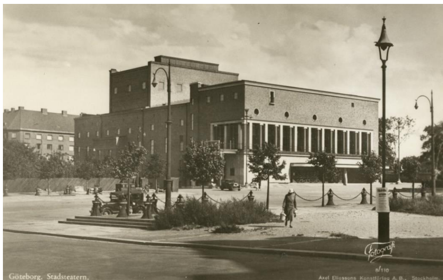
STADSTEATERN SEDD FRÅN VIKTOR RYDBERGSGATAN ÅR 1935. NÄRMST I BILD SES FOYERHUSET MED ENTRÉ OCH BORTOM DET SALONGSHUSET MED SCENHUSET SOM TORNAR UPP SIG. KÄLLA: ARKITEKTUR- OCH DESIGNCENTRUMS ARKIV
