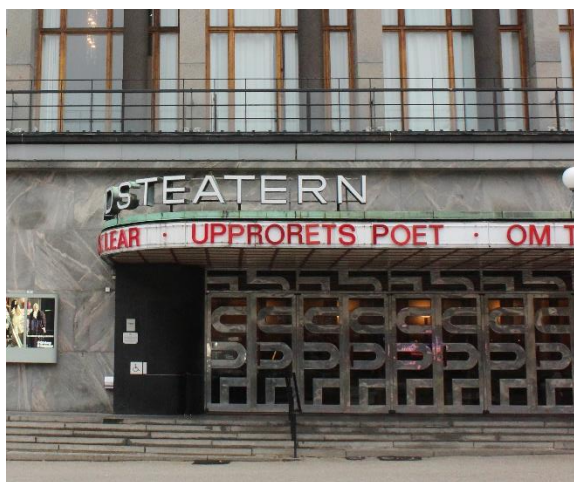
SKÄRMTAK OCH ENTRÉDÖRRAR MED SVÄNGDA FORMER
