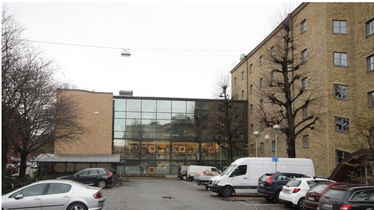
TILLBYGGNADEN HAR GLASADE FASADER SAMT FASADER I GULT TEGEL.
