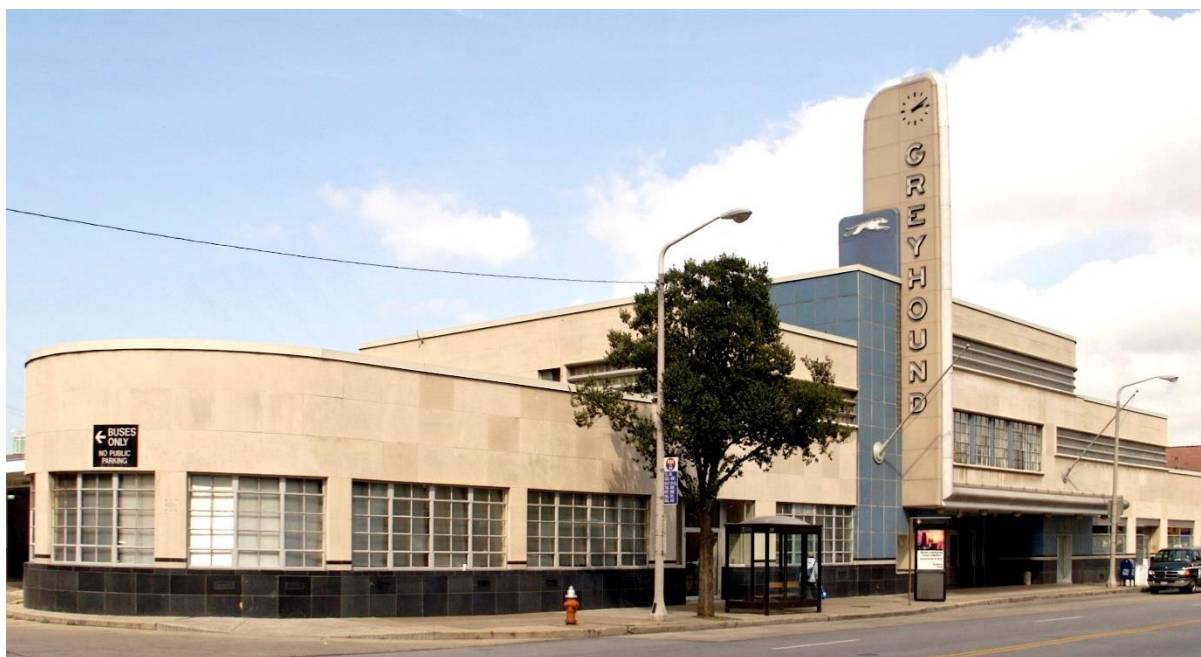
BUSSTATION, OHIO CLEVELAND. KÄLLA: WIKIPEDIA.ORG
