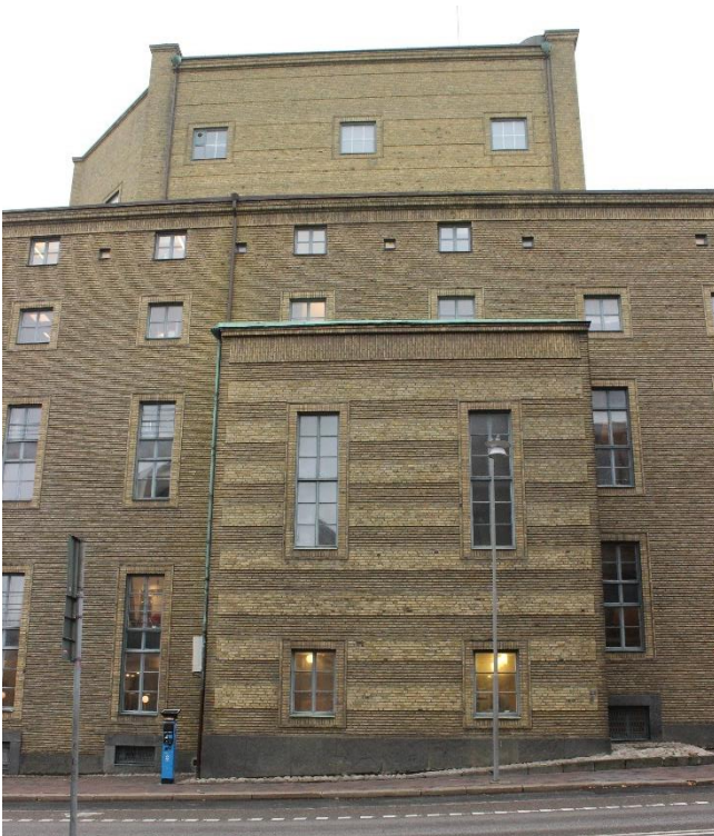
SIDOSCENEN STICKER UT MOT BERZELIIGATAN. SCENHUSET STICKER UPP OVAN ÖVRIGT TAK.
