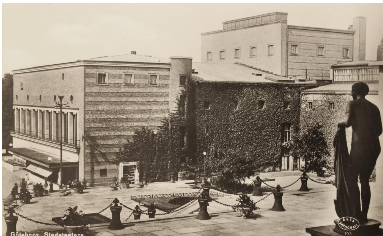
STADSTEATERN SEDD FRÅN KONSTMUSEETS TRAPPA. FOYERHUSET MED ENTRÉ LIGGER TILL VÄNSTER OCH TILL HÖGER OM DET SALONGSHUSET MED SCENHUSET SOM TORNAR UPP SIG. VERKSTADSHUSET LÄNGST TILL HÖGER I BILD. KÄLLA: GÖTEBORGS STADSMUSEUMS ARKIV
