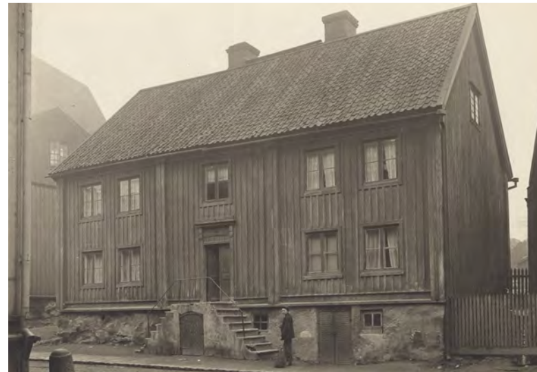
Hälleberget, byggnad A. Huvudfasaden mot Allmänna vägen år 1910 med den tidigare fritrappan. (GSM)
