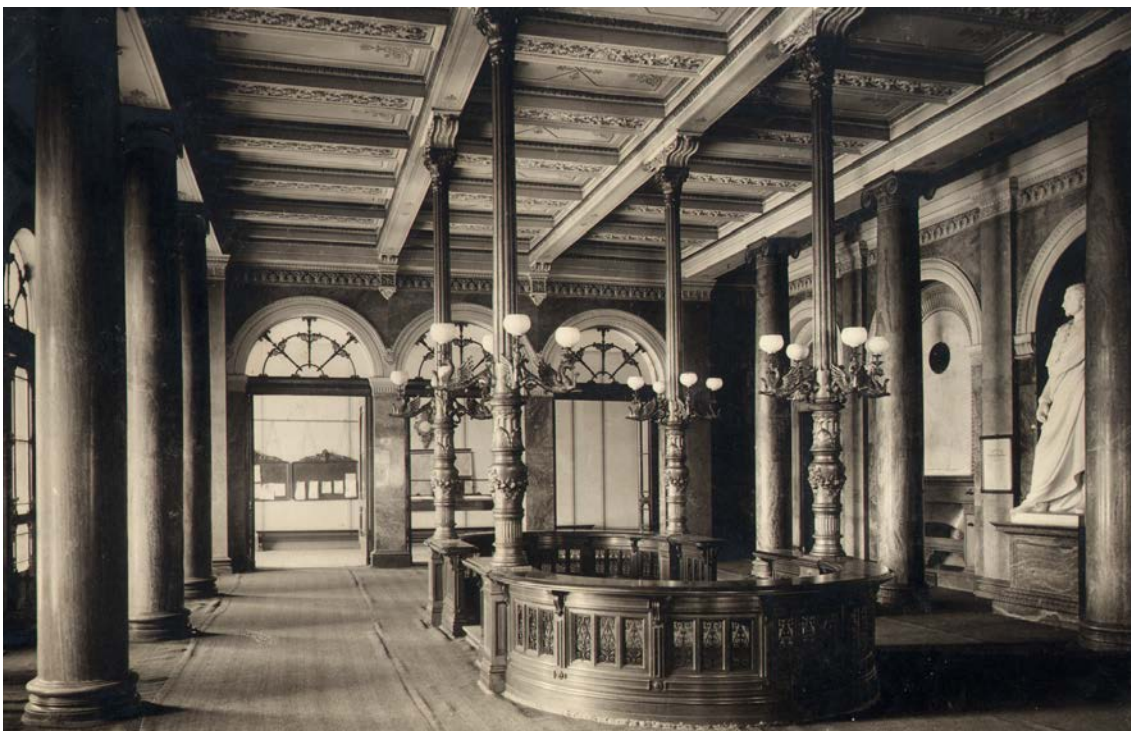
Fotografier över Börsalen där vi bl a ser den äldre balustraden samt att kungastatyn står placerad i öppningen mot gården. Det övre fotot är odaterat och det nedre från år 1901. Bägge är tagna efter ombyggnaden och förstärkningen av bjälklaget 1877. (GSM)
