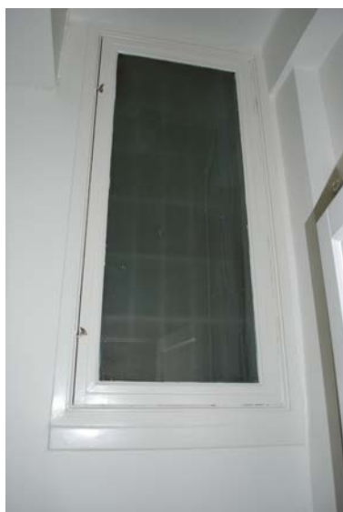
Foto på fönster i rum 4264b.
