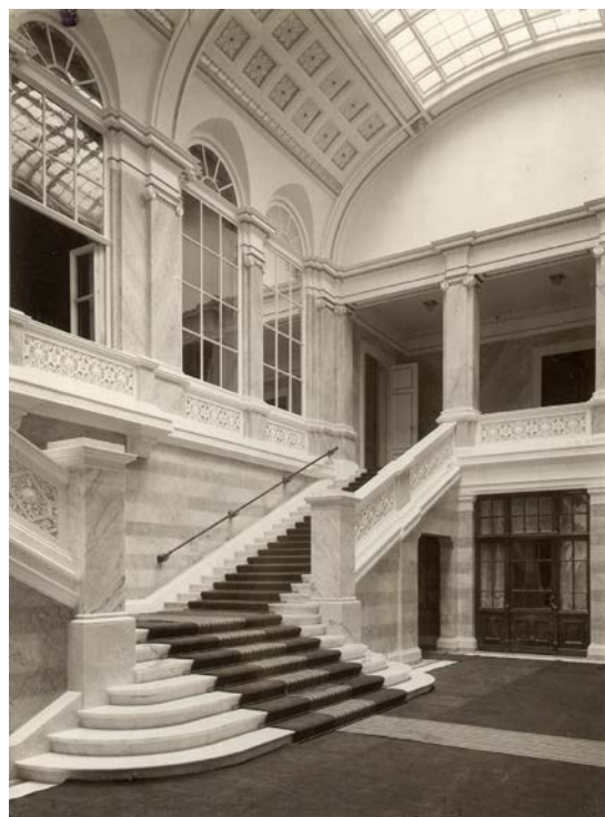
Foto från 1910 efter det att gårdsutrymmet byggts om till en större trapphall. (GSM)
