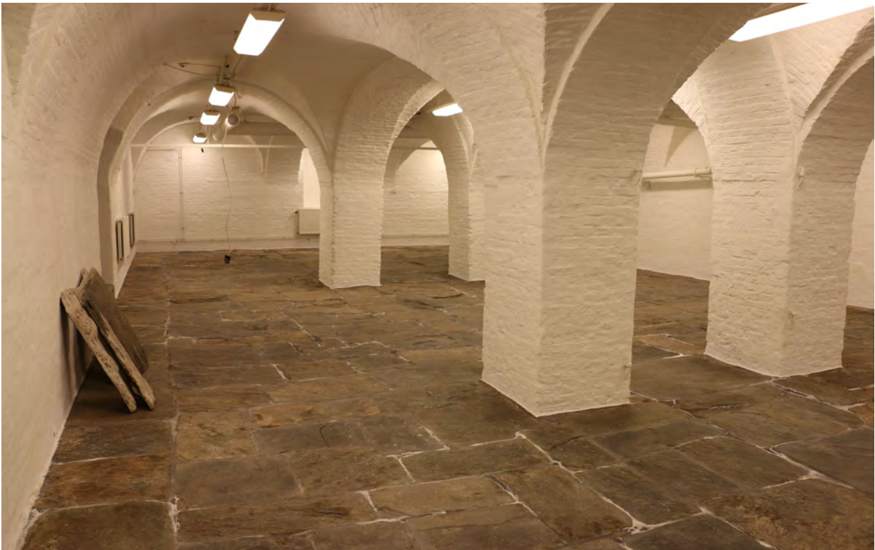
Bottenvåningens tegelvalv i den så kallade kakelkällaren.
